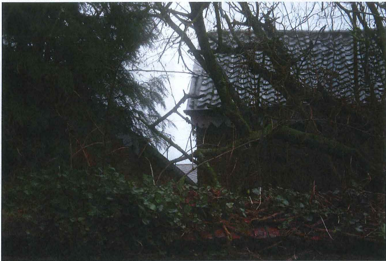
Foto 8: Flankerend bedrijfsgebouw langs de zuidzijde (rechts) en losstaand bedrijfsgebouw (links)
