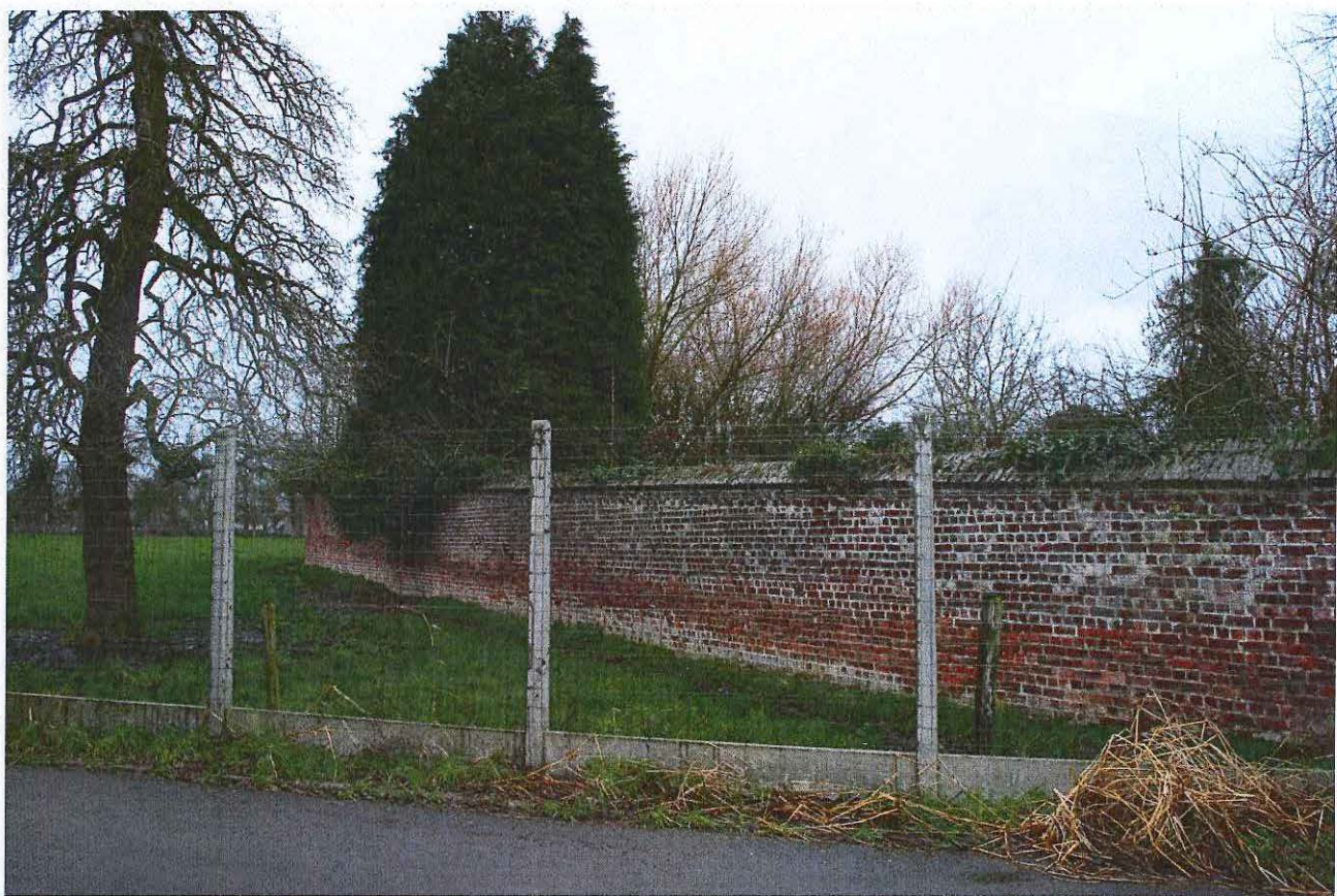
Foto 18: Omheiningsmuur langs de zuidwestzijde, gezien vanuit de weideboomgaard
