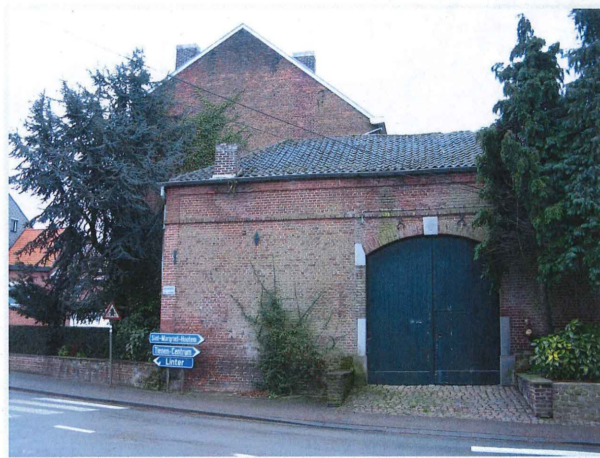
Foto 9: Flankerend bedrijfsgebouw langs de noordzijde
