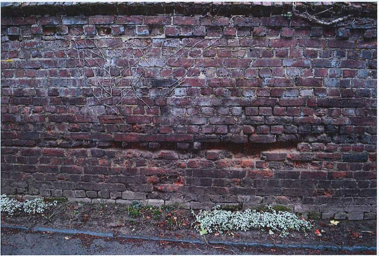
Foto 17: Detail muur langs de zuidzijde van het perceel
