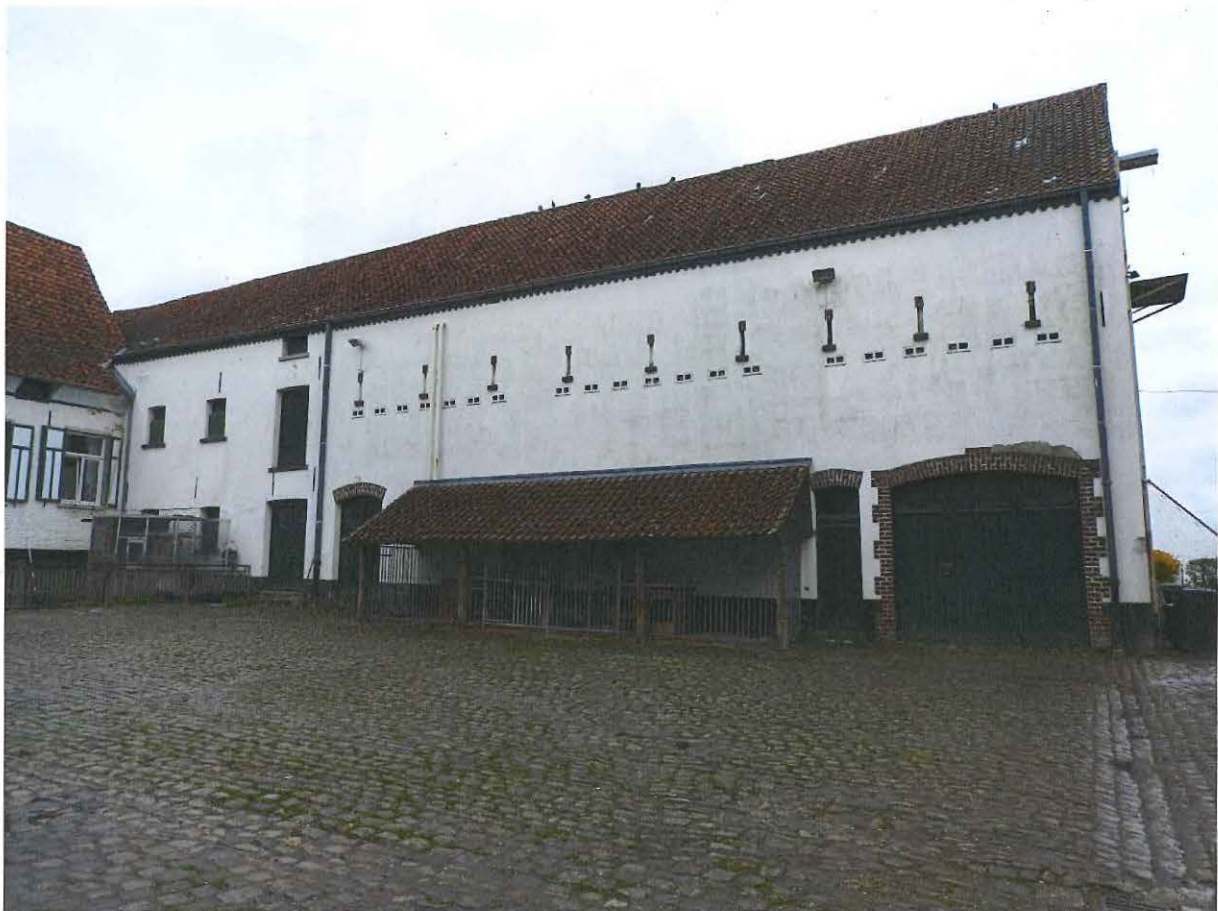
Foto 15: Hoeve-brouwerij Goossens: west- of erfgevel van het pakhuis
