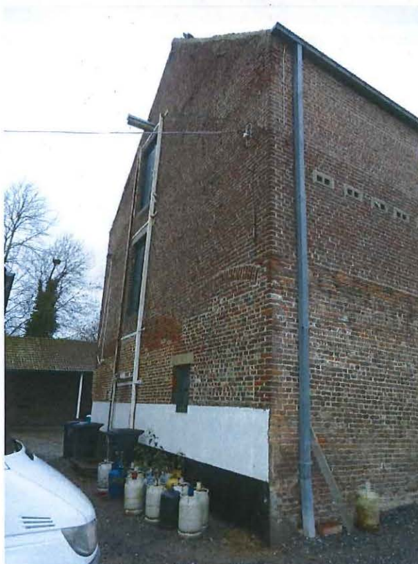
Foto 14: Hoeve-brouwerij Goossens: zuidgevel pakhuys met laadvensters
