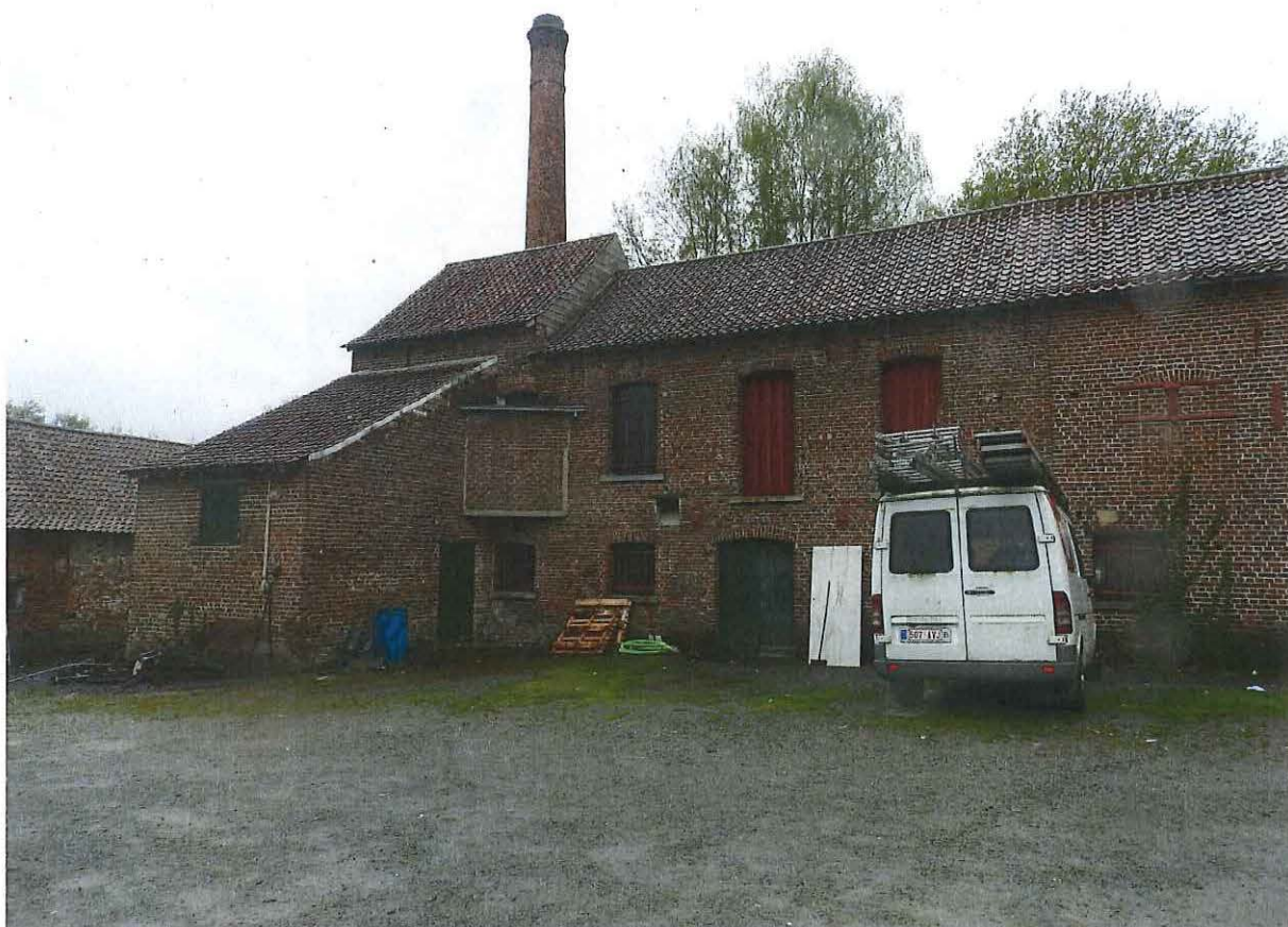
Foto 18: Hoeve-brouwerij Goossens: nieuwe brouwerij, oostgevel
