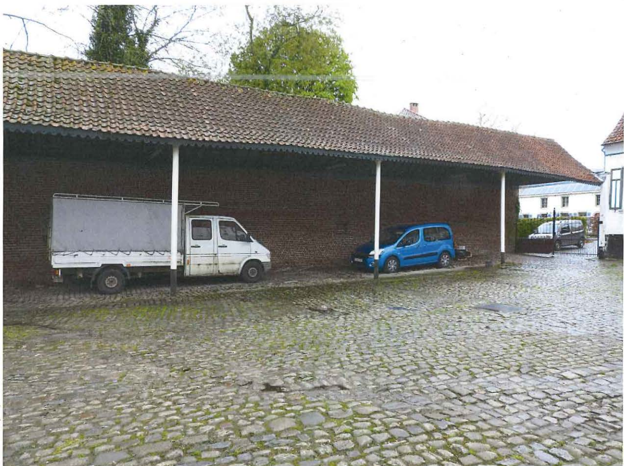
Foto 16: Hoeve-brouwerij Goossens: erf met ten westen overdekte bergplaats onder zadeldak
