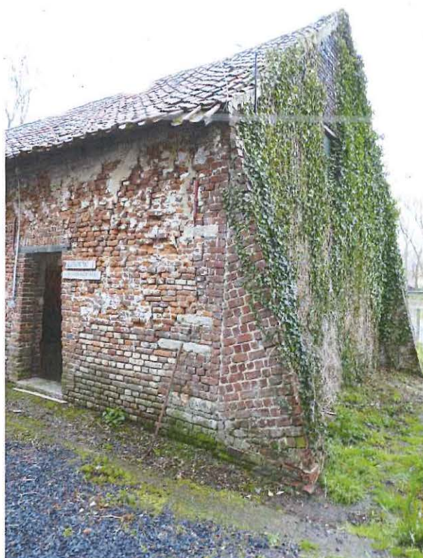
Foto 24: Hoeve-brouwerij Goossens: oude brouwerij met mouterij, toegang tot de mouterij en westgevel
