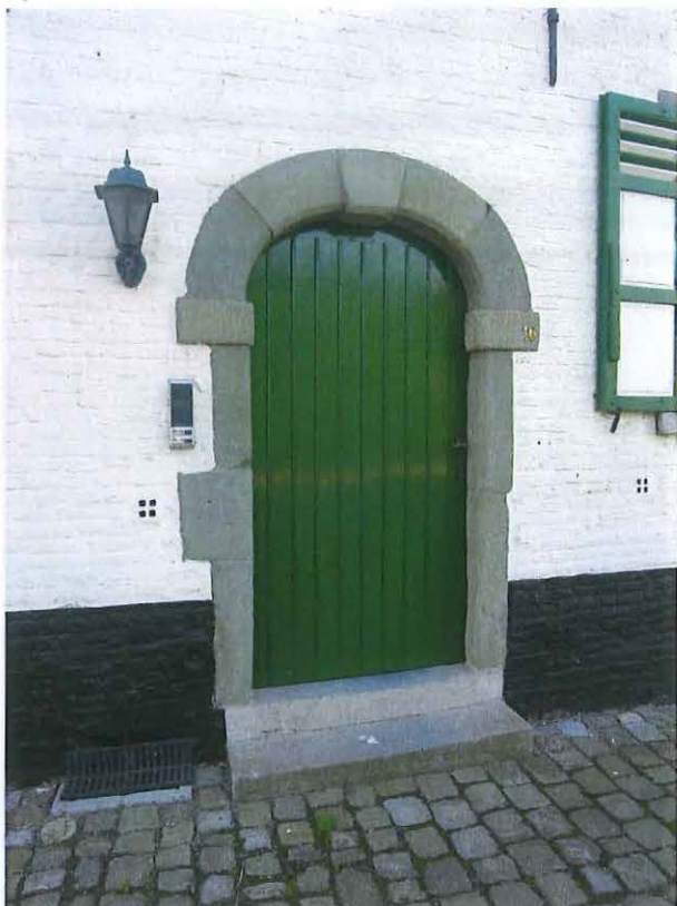
Foto 3: Hoeve-brouwerij Goossens: deuroplijsting in arkoze in de noord- of straatgevel
