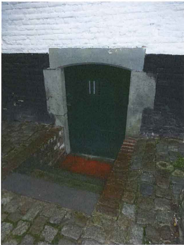
Foto 6: Hoeve-brouwerij Goossens: zuid- of erfgevel van het woonhuis met toegang tot de kelder met omlijsting in arkoze
