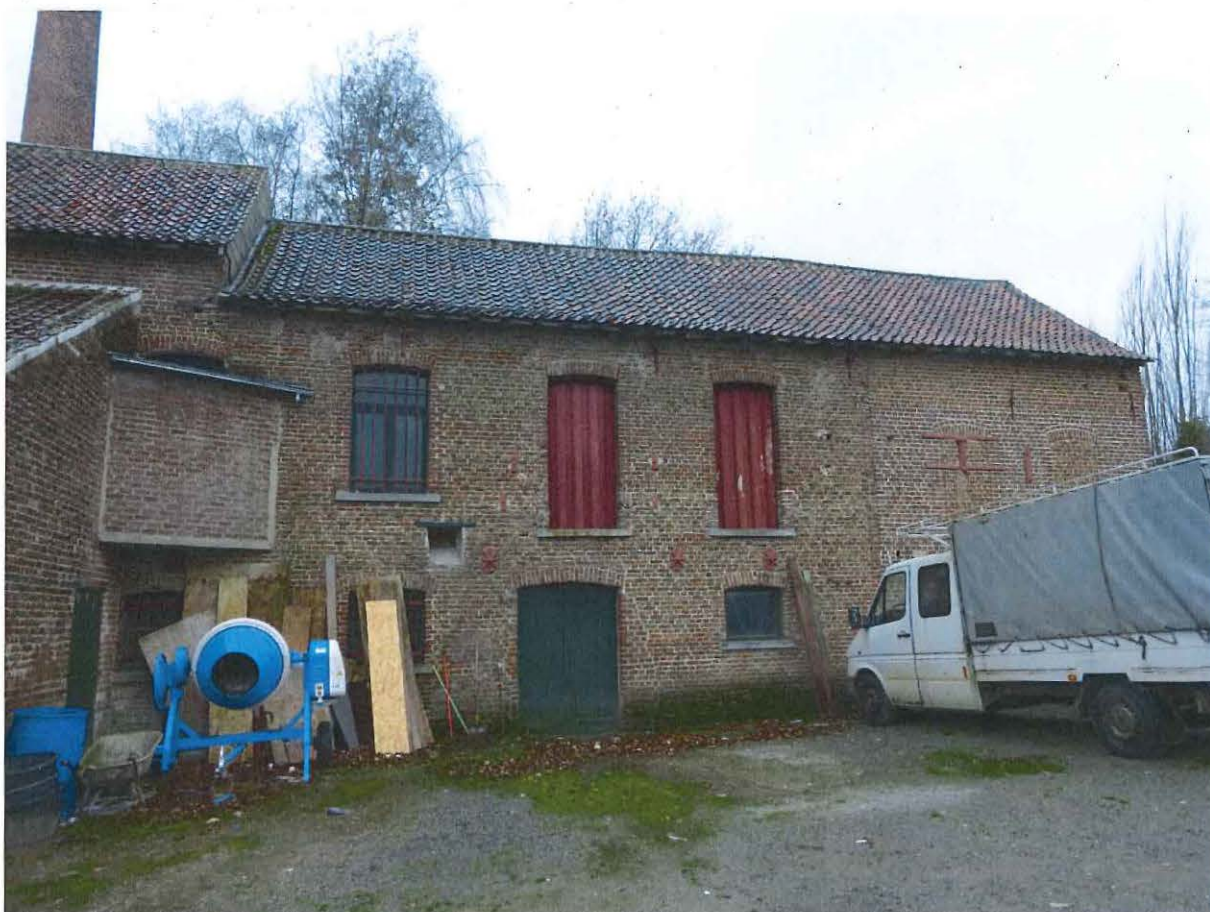
Foto 19: Hoeve-brouwerij Goossens: oostgevel nieuwe brouwerij met centraal op de eerste verdieping de voormalige brouwzaal en de lamellen waarachter zich het koelschip bevond
