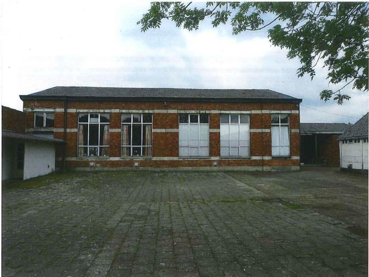
Foto 16: Achtergevel klasvleugel met rechts 'préau couvert'
