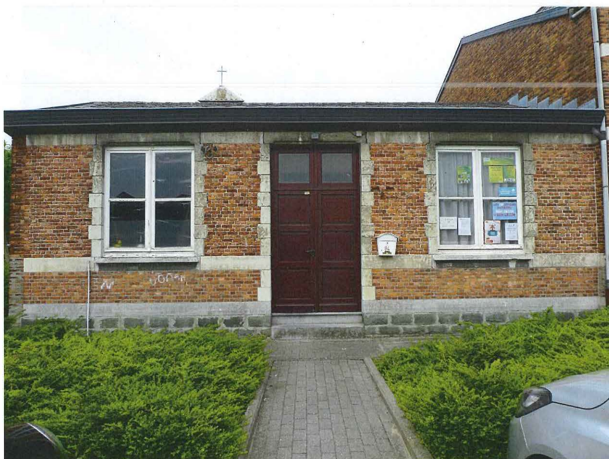
Foto 5: Voorgevel 'préau couvert' met deel van voetpadstrook
