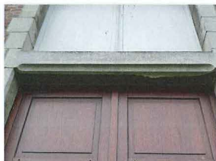
Foto 13: Voorgevel rechterdeurtravee tussenlatei
