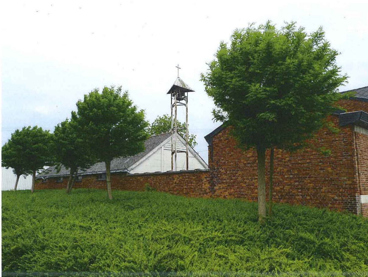
Foto 2: Buitenaanzicht van 'préau couvert', speelplaatsmuur en voormalige Sint-Gerarduskapel met klokkentoren
