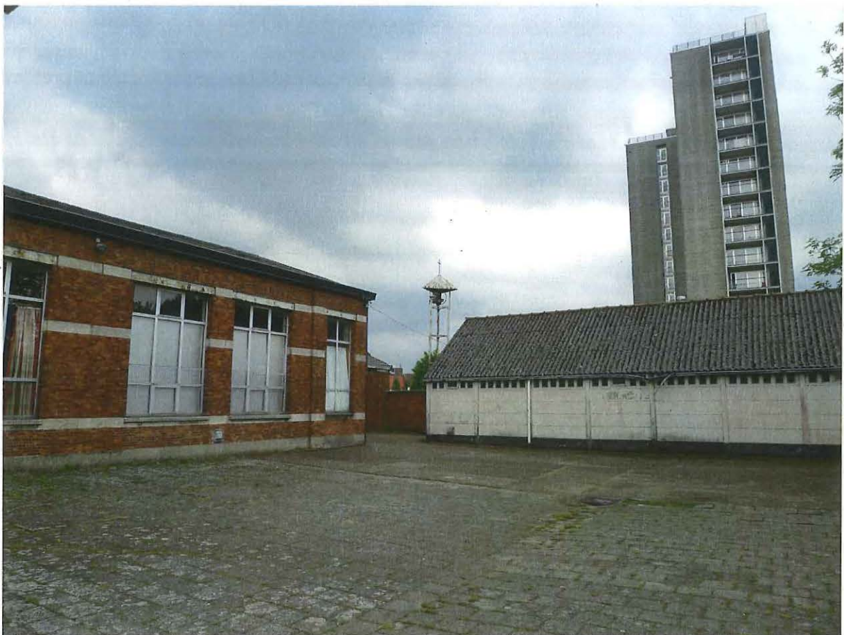
Foto 23: Achtergevel klasvleugel, klokkentoren, voormalige Sint-Gerarduskapel, verharde speelplaats
