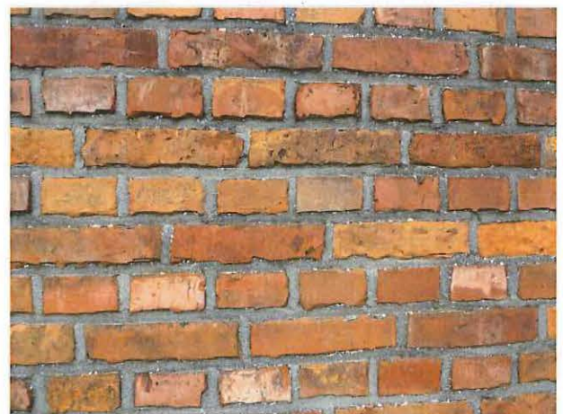
Foto 18: Achtergevel klasvleugel metselwerk
