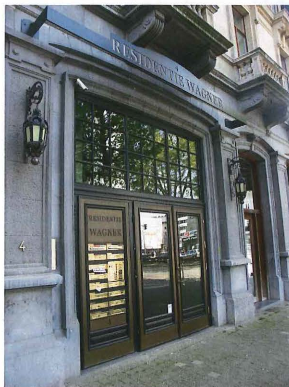
Foto 123: voormalig hotel Wagner, nieuwe inkom appartementen
