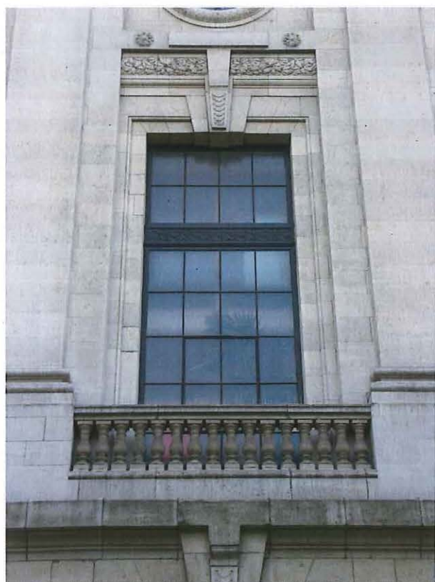
Foto 102: voormalig schermenmagazijn: bovenbouw
