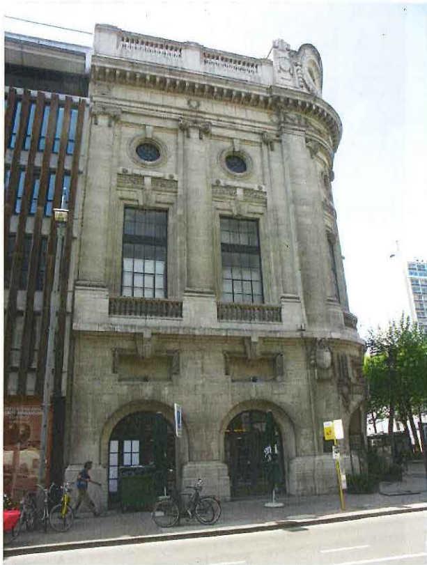
Foto 96: voormalig schermenmagazijn: gevel Van Ertbornstraat
