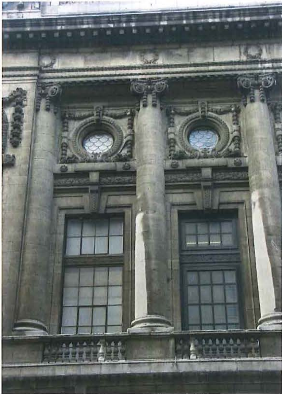
Foto 12: Vlaamse opera: achtergevel: bovenbouw
