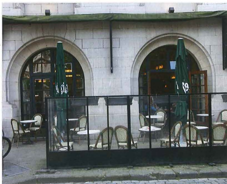
Foto 103: voormalig schermenmagazijn: begane grond (brasserie)
