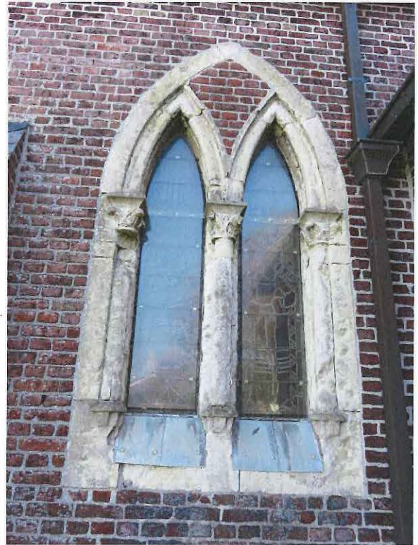
Foto 24. Westelijke zijgevel van de Milanenkapel, detail gekoppelde lancetvensters met zuiltjes (04/05/2016)
