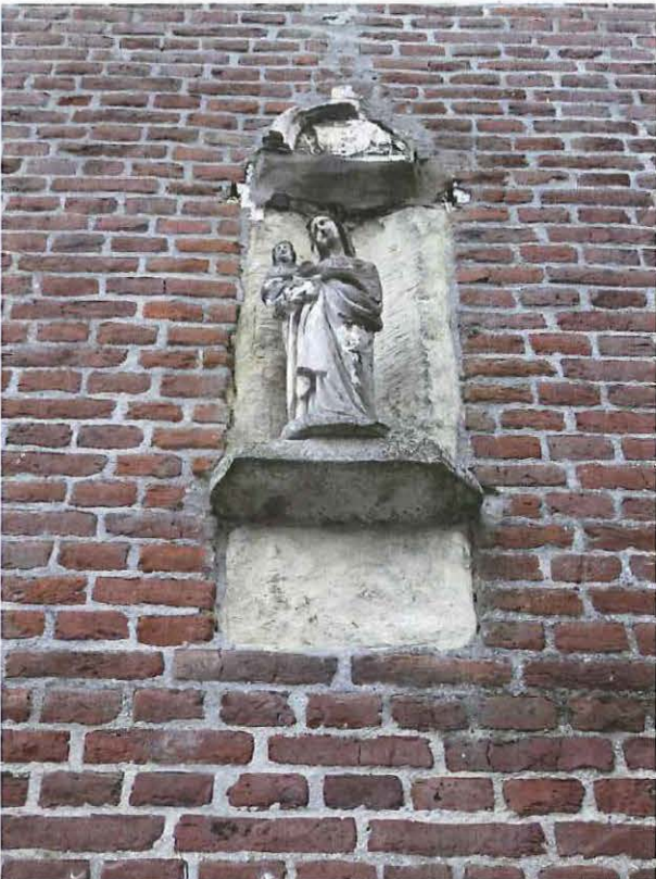
Foto 21. Portaalzijde (detail gevelveld): uitkragend baldakijn in natuursteen met beeld en wapenschild, spoor van vroegere bekroning traceerbaar in metselwerk (08/04/2016)
