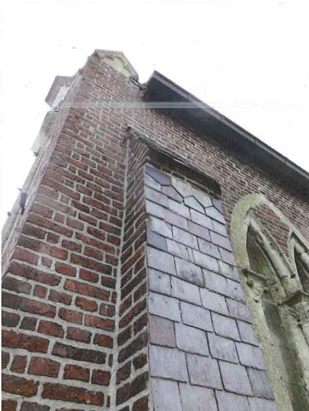
Foto 25. Westelijke zijgevel van de Milanenkapel, detail: bezetting van de steunberen met leien en natuurstenen aanzetsteen van het aandak met drielobmotief (08/04/2016)
