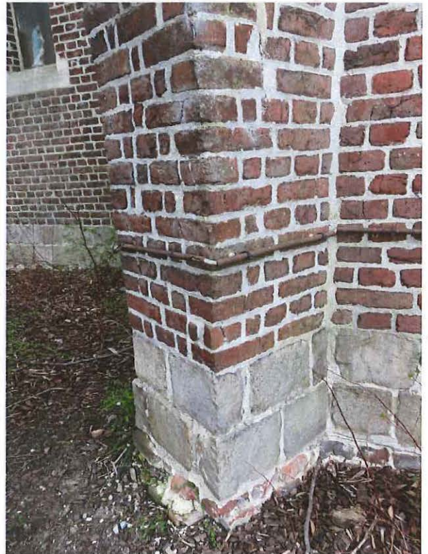
Foto 22. Plint in Artesische zandsteen, detail koorzijde (08/04/2016)
