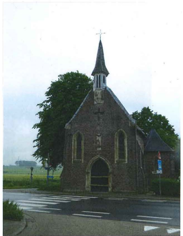
Foto 8. De Milanenkapel en de gekandelaarde kapellinde in de zomer, schade aan de poort intussen hersteld (21/06/2013)
