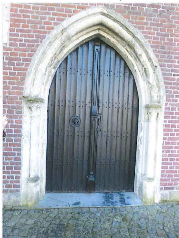
Foto 14. Portaal, uitgewerkt met briefpaneel, gevat in een natuurstenen omlijsting (04/02/2015)
