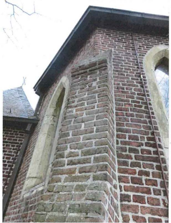
Foto 32. Koor van de Milanenkapel, detail: omlijsting lancetvensters en steunbeer aan oostzijde, nagelssporen van vroegere bezetting met leien (08/04/2016)
