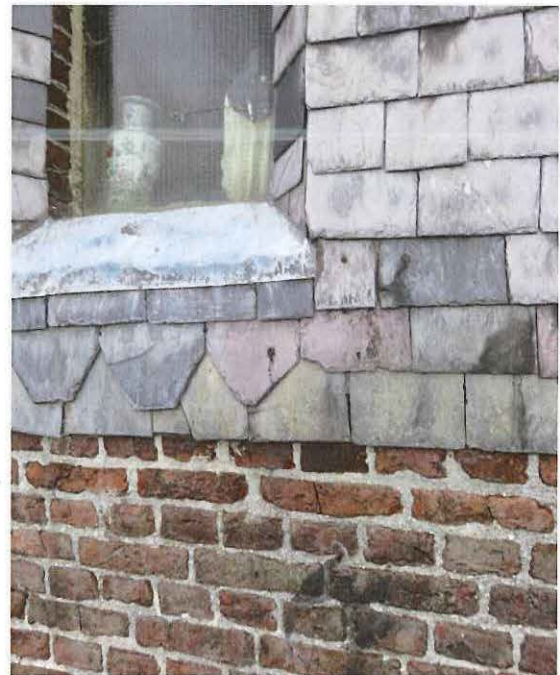
Foto 26. Westelijke zijgevel van de Milanenkapel, detail: zijgevel van de sacristie bezet met leien in sierlijke motieven (08/04/2016)
