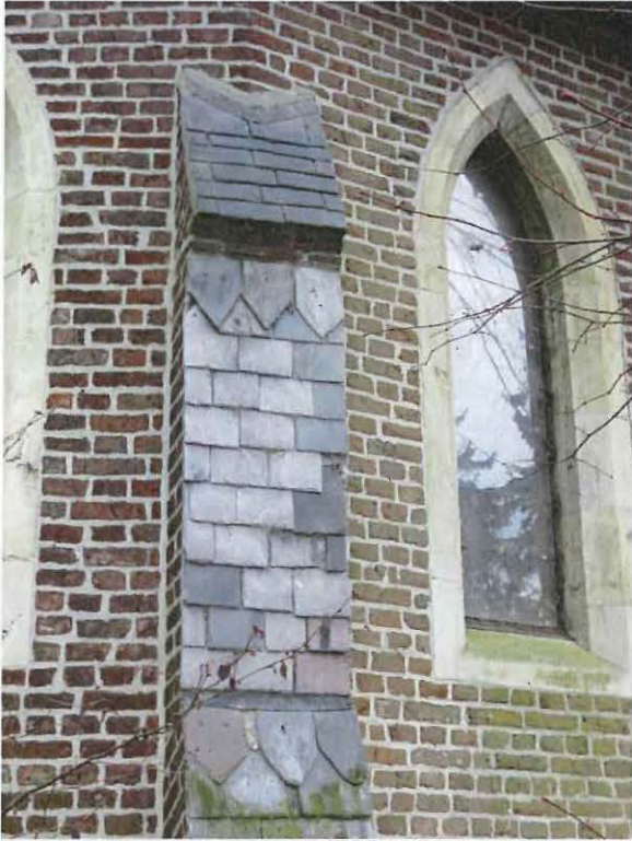
Foto 31. Koor van de Milanenkapel, detail: omlijsting lancetvensters en steunbeer aan oostzijde, bezet met leien (08/04/2016)
