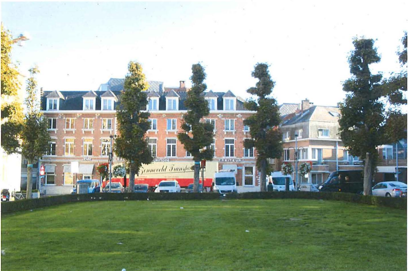
Foto 4: Hogeschoolplein, zicht op de noordoostelijke pleinwand
