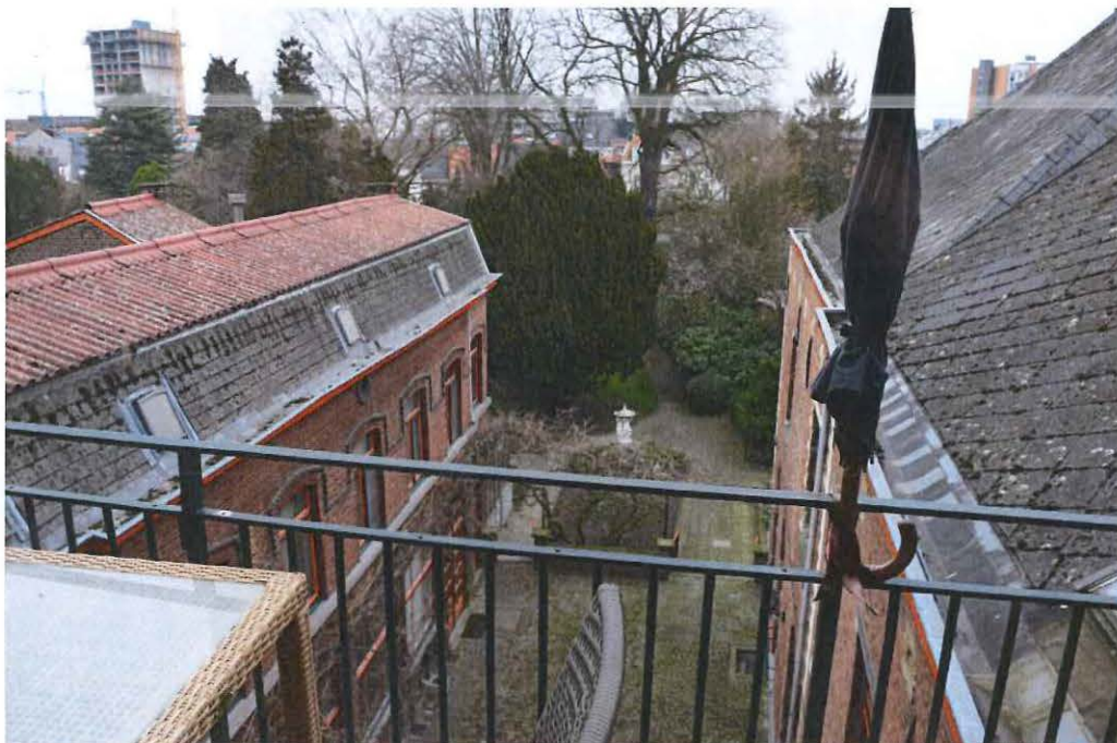
foto 10: zicht vanuit de derde verdieping hoofdbouw op de bedaking van beide achterliggende vleugels georiënteerd naar de tuin
