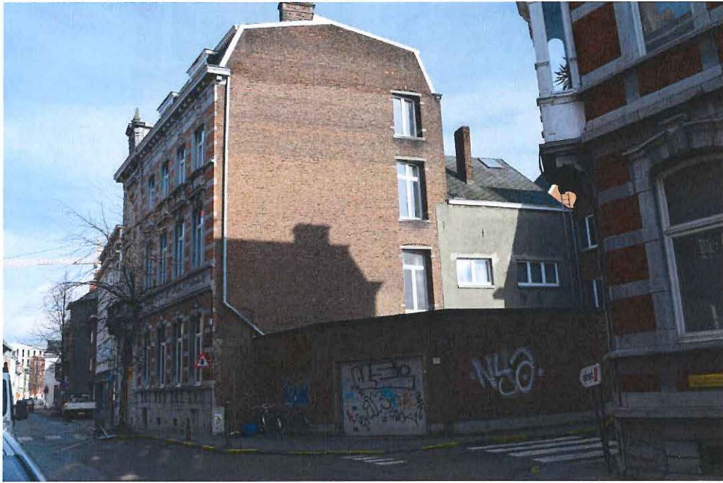
foto 5: rechter zijgevel (hoek Vaartstraat-Lombaardenstraat) met vensteropeningen in de trapkoker
