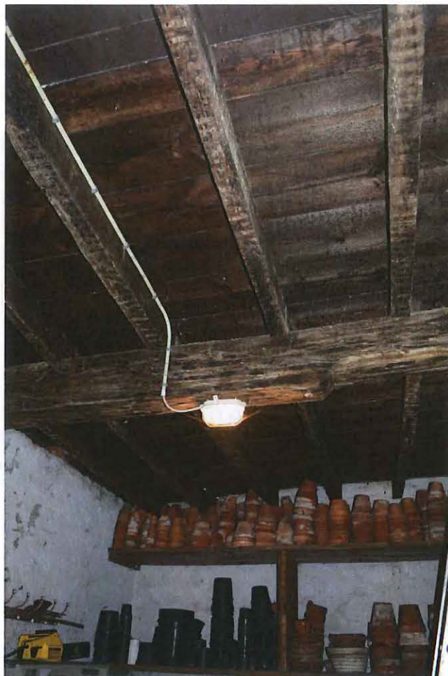
foto 19: bewaarde balkenlaag in het eenlaags gebouwtje
