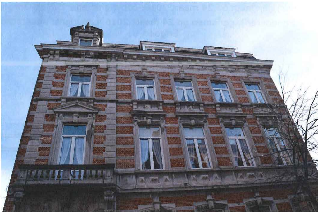
foto 2: zicht op de bovenverdiepingen van de voorgevel
