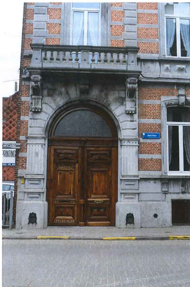
foto 3: detail van de poort bekroond met deurtravee met balkon
