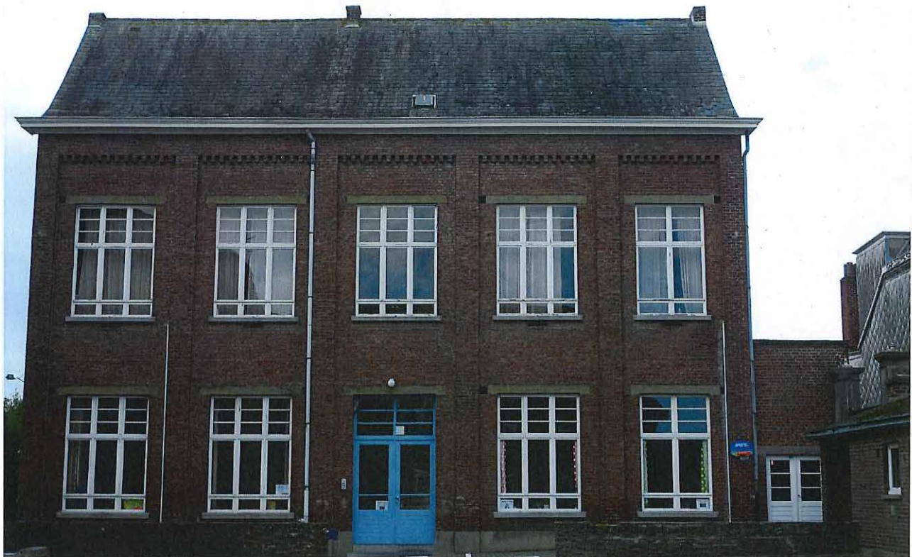
Foto 11: voorgevel van voormalige huishoudschool van 1899
