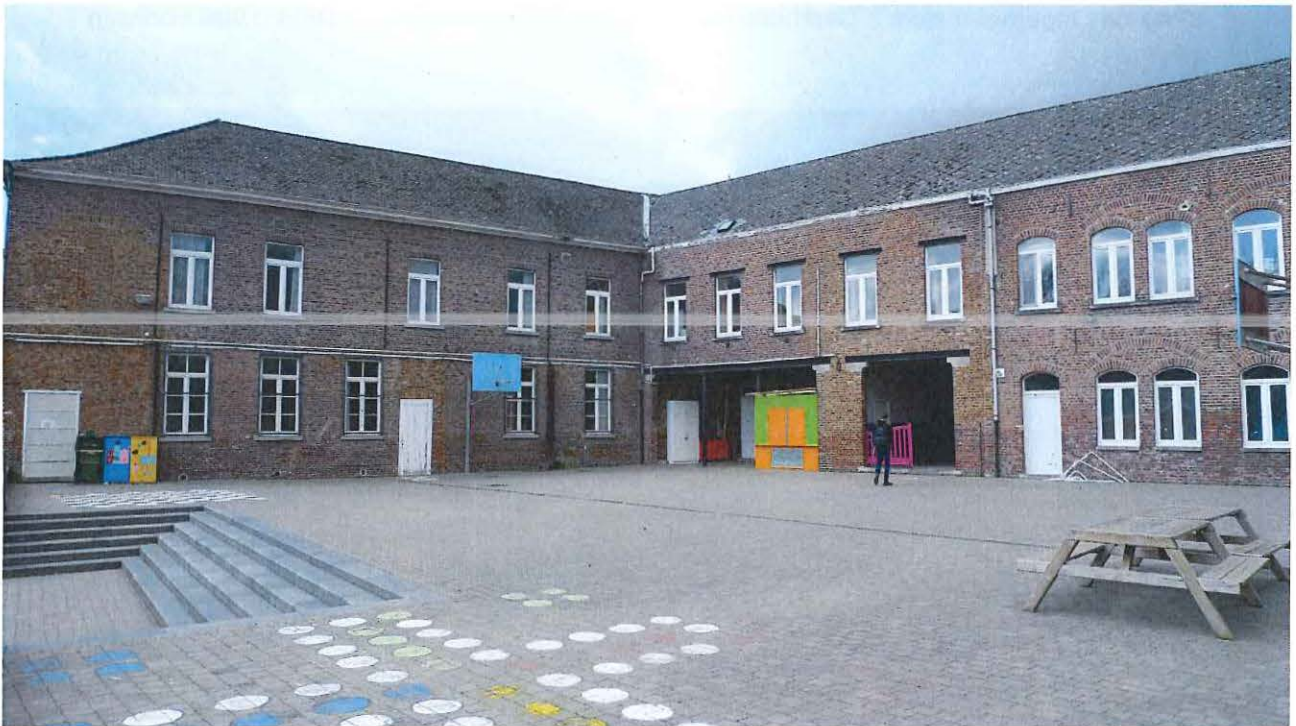
Foto 67: achtergevel oostvleugel van U-vormig inkomgebouw, achtergevel straatvleugel, speelplaats in niveaus
