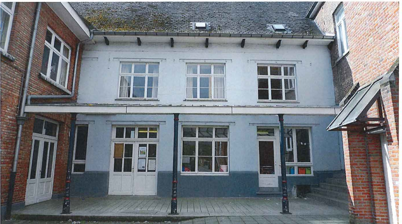
Foto 51: NO-kloostervleugel – speelpleinzijde; rechts U-vormig inkomgebouw, links schoolvleugel 1947
