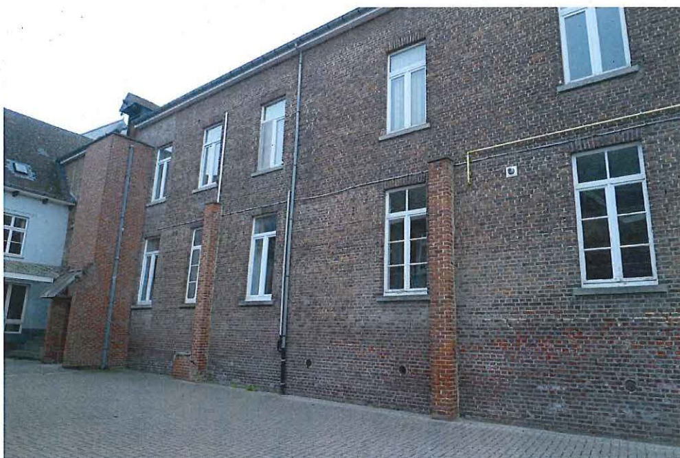
Foto 72: achtergevel van hoofdvleugel van U-vormig inkomgebouw van circa 1860
