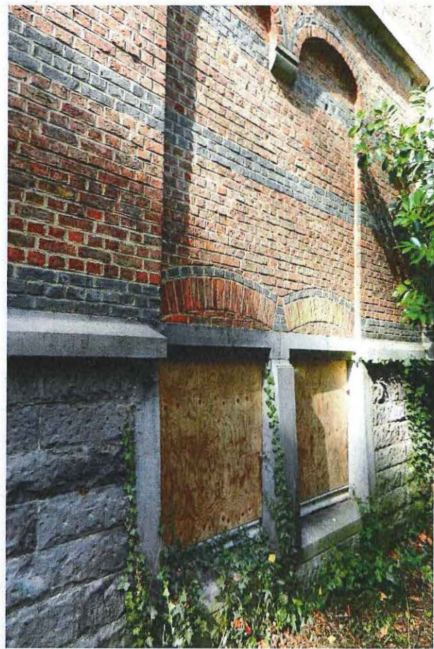
Foto 28: de plint en eerste bouwlaag van de noordgevel van de voorbouw
