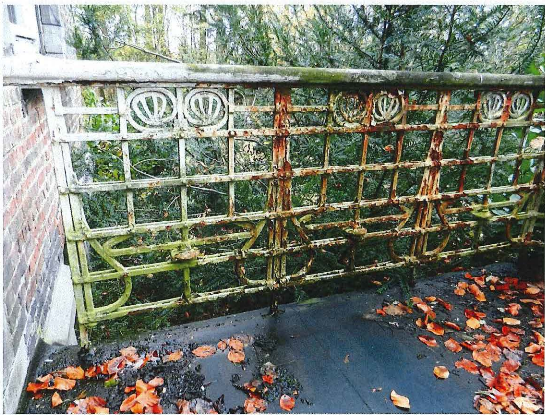
Foto 32: balustrade van het balkon van de voorbouw
