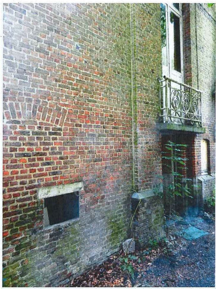
Foto 34: venster met balkon en balustrade in de achtergevel
