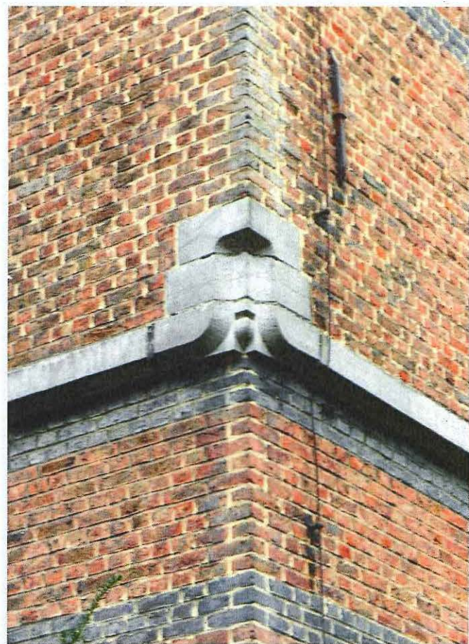
Foto 30: hoek van de voorgevel en noordgevel, met overstek tussen de tweede derde bouwlaag
