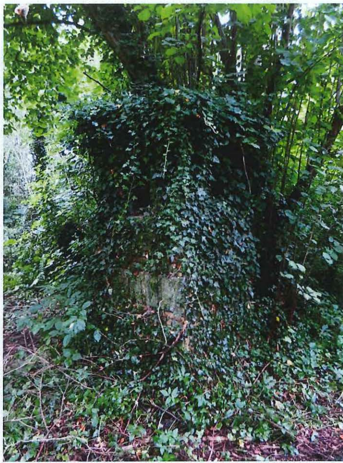
Foto 9: niskapel op het zuidelijke eiland
