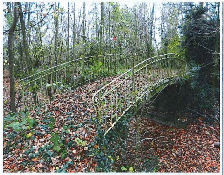
Foto 7: brug over de ringgracht van het zuidelijke eiland
