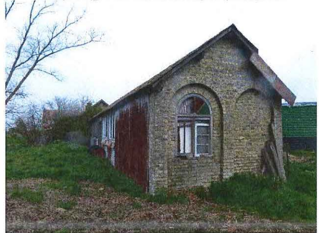
Foto 5: Zicht vanaf het zuidoosten op de lighalle
