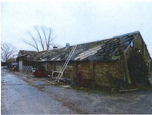
Foto 2: Zicht vanaf het noordwesten op het oostelijke paviljoen
