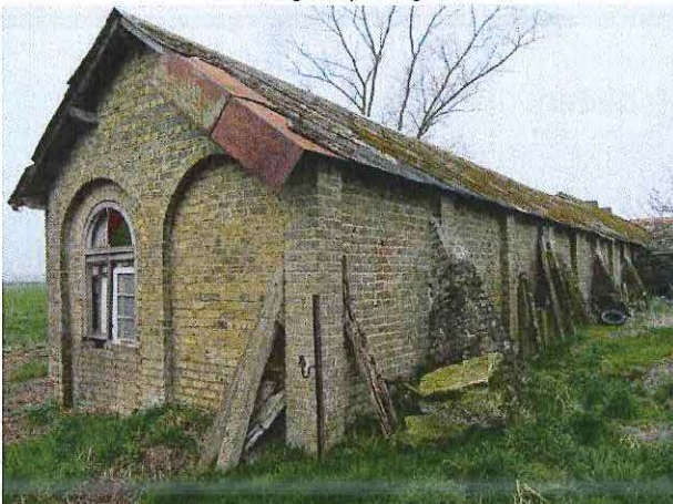
Foto 4: Zicht vanaf het oosten op de lighalle (verlengde van het oostelijke paviljoen)
