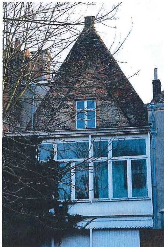
Foto 15: Diephuis, achtergevel met veranda
