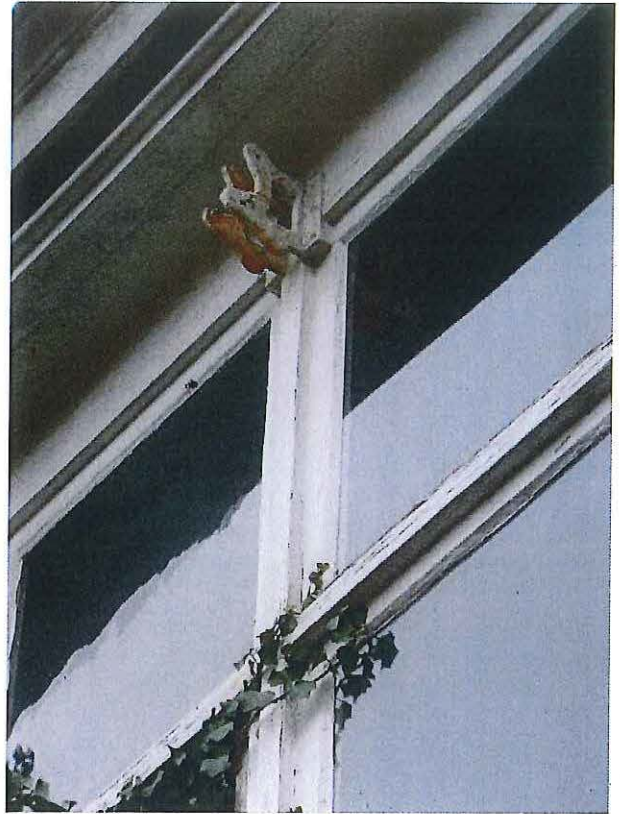
Foto 17: Diephuis, achtergevel met veranda, detail schrijnwerk
