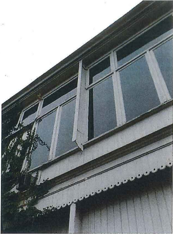
Foto 16: Diephuis, achtergevel met veranda
