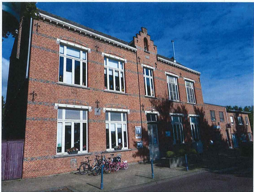
Foto 22: Meisjesschool, voorgevel, Nieuwstraat 1
