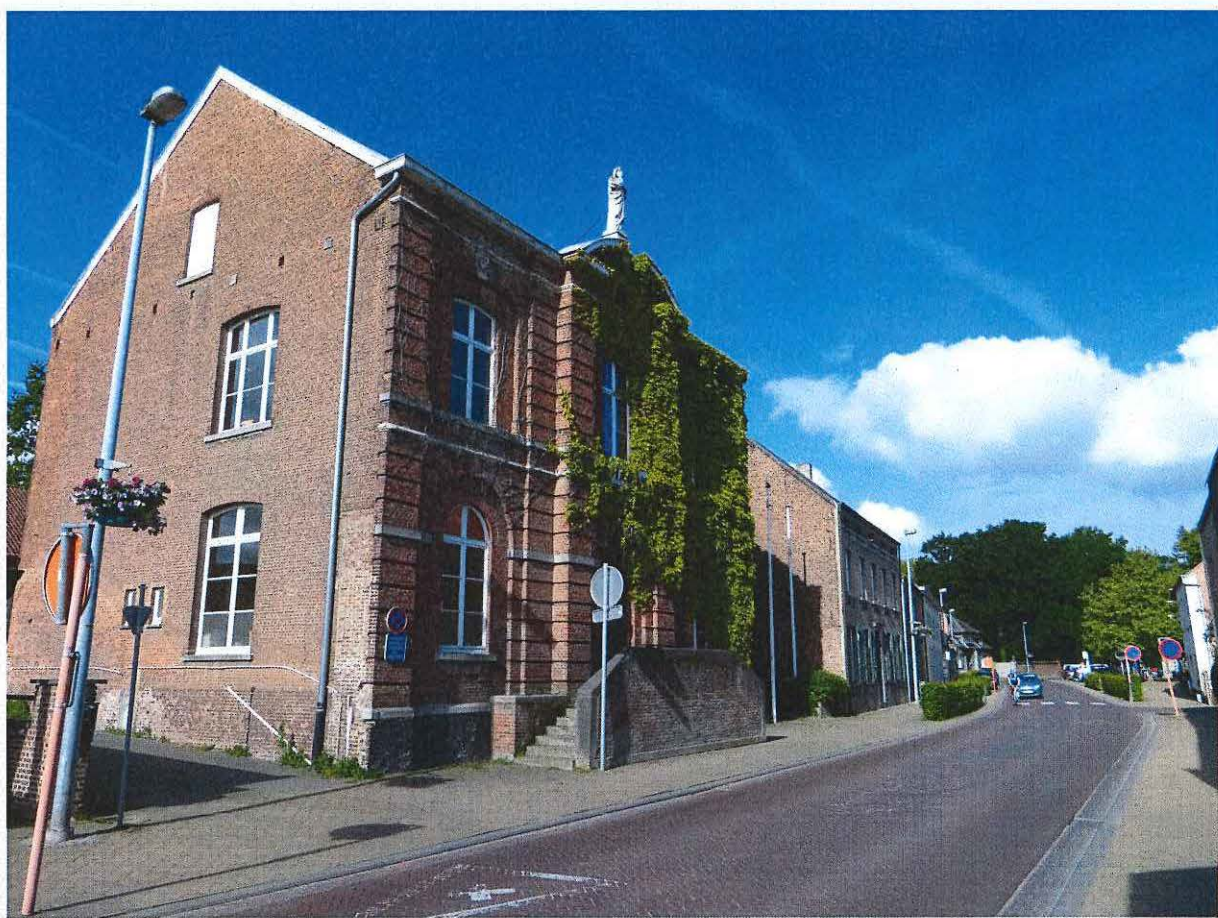
Foto 36: Gemeentehuis van Wespelaar, Grote Baan 55, zijgevel en voorgevel
