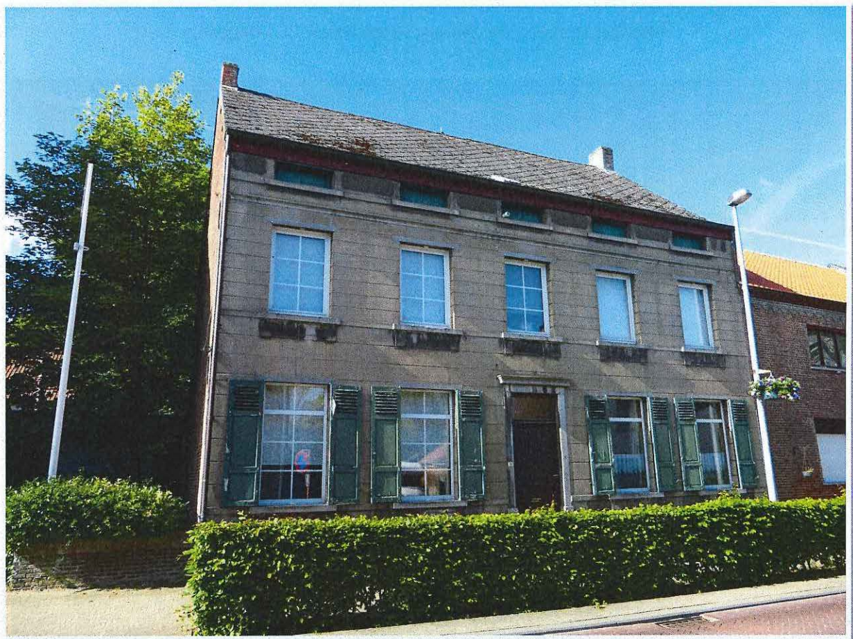
Foto 32: Burgerwoning, Grote Baan 57, voorgevel
