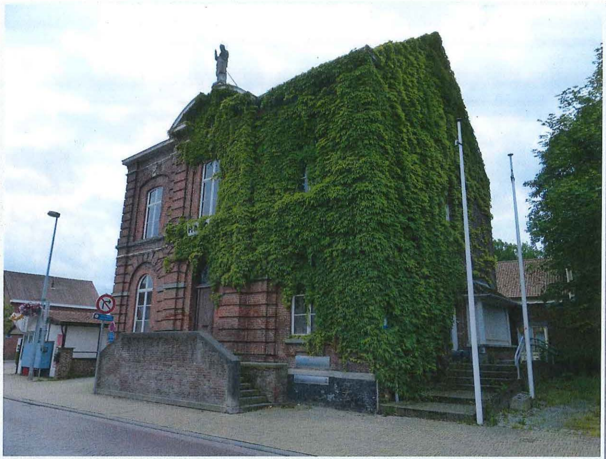
Foto 37: Gemeentehuis van Wespelaar, Grote Baan 55, zijgevel en voorgevel
