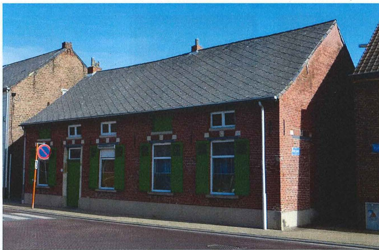
Foto 42: Dorpswoning, Grote Baan 24, zijgevel en voorgevel
