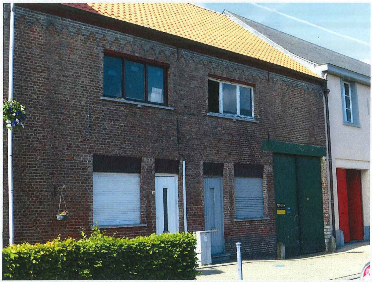
Foto 33: Bijgebouw burgerwoning, Grote Baan 59-61, voorgevel
