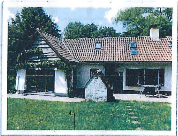
Foto 9: Erfzijde met paardenstal en vrijstaande steenput
