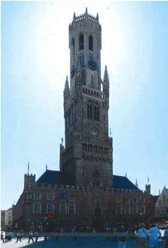
Markt 7, Belfort met hallen
