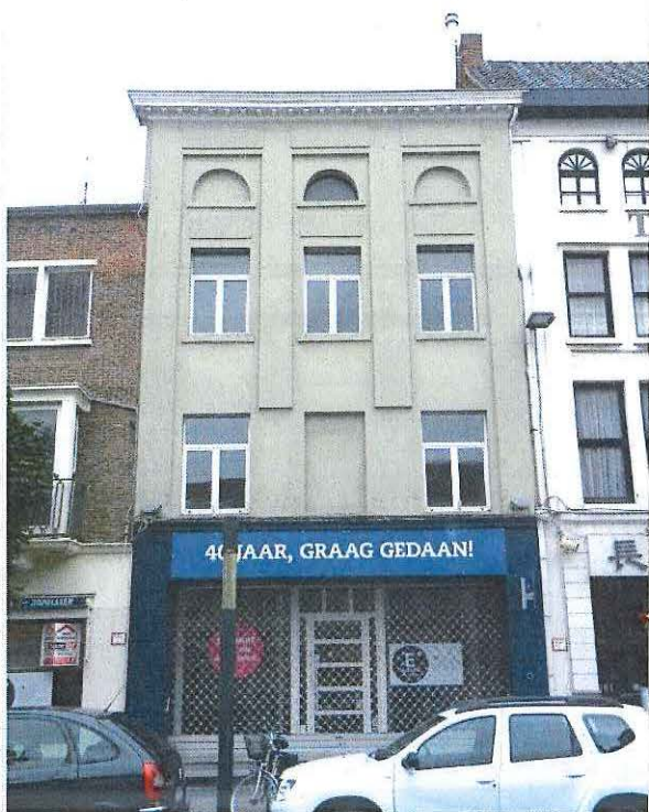
Foto 2: de voorgevel van het huis De Croone.
