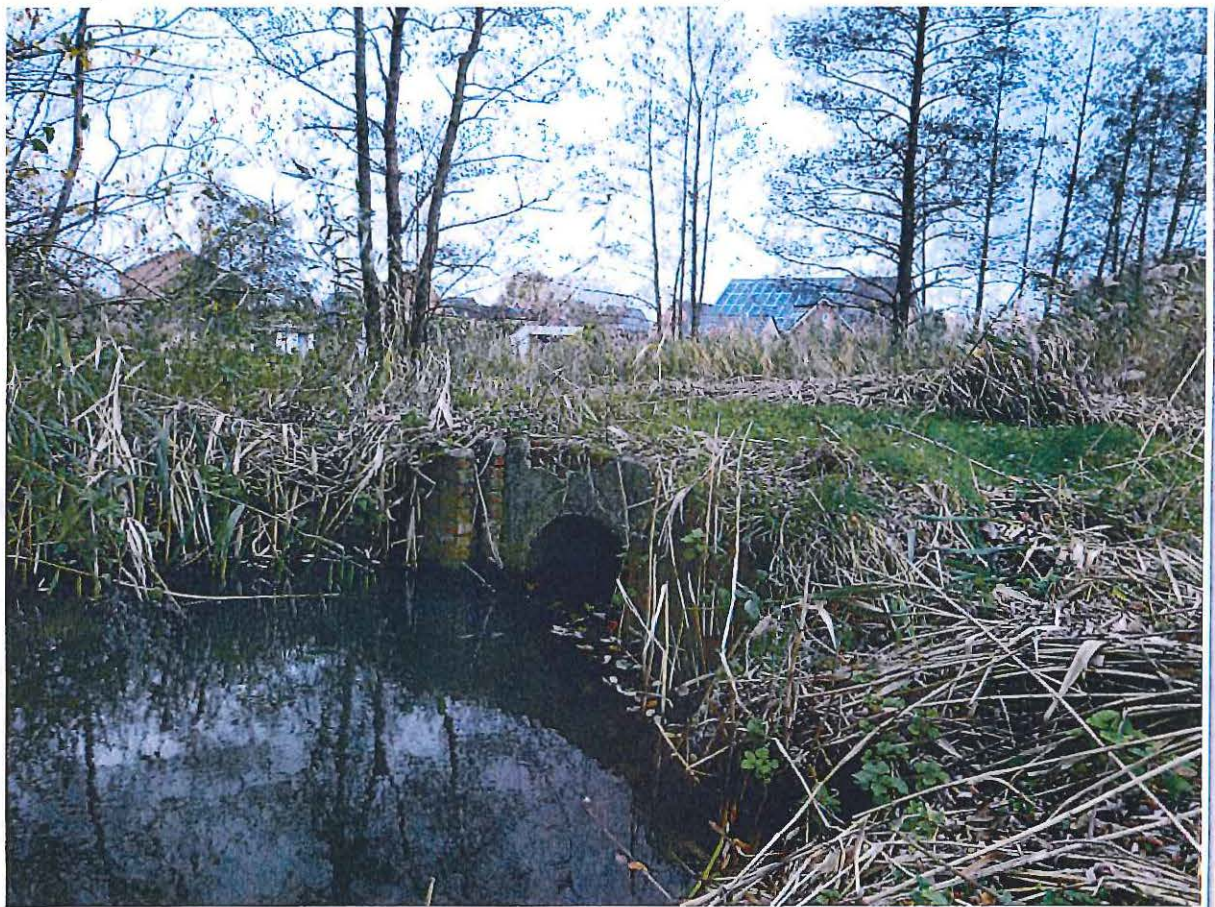
Foto 2: Duiker voor de bovensloot in verruigde watering
