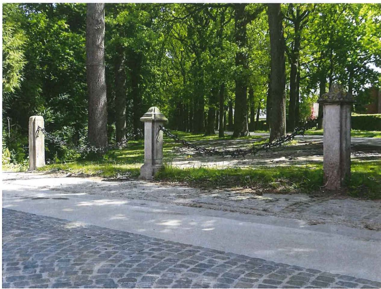
Foto 6: Algemeen zicht op de natuurstenen afsluiting van de Bisschopsdreef ter hoogte van de Polderstraat
