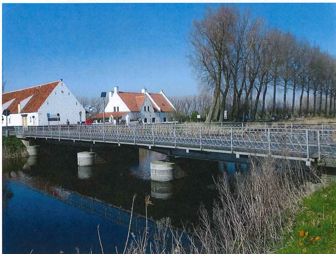
Foto 9: Kanaalbrug tussen Dammesteenweg en Kerkstraat in Damme
