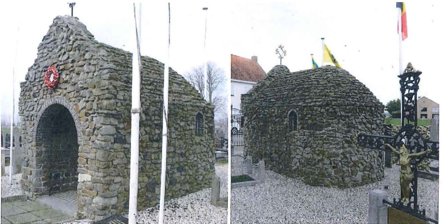
Voorgevel, zijgevel en achtergevel van de kapel. Merkwaardig zijn het gebogen dak en de afronding van de achterzijde
