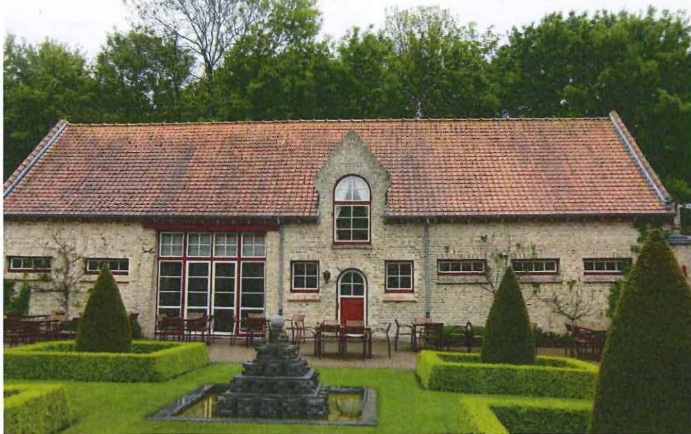
De gerenoveerde koeien- en paardenstalling
