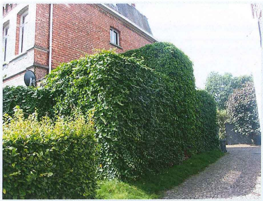
Foto 12: Rechterzijgevel met begroeide aanbouw
