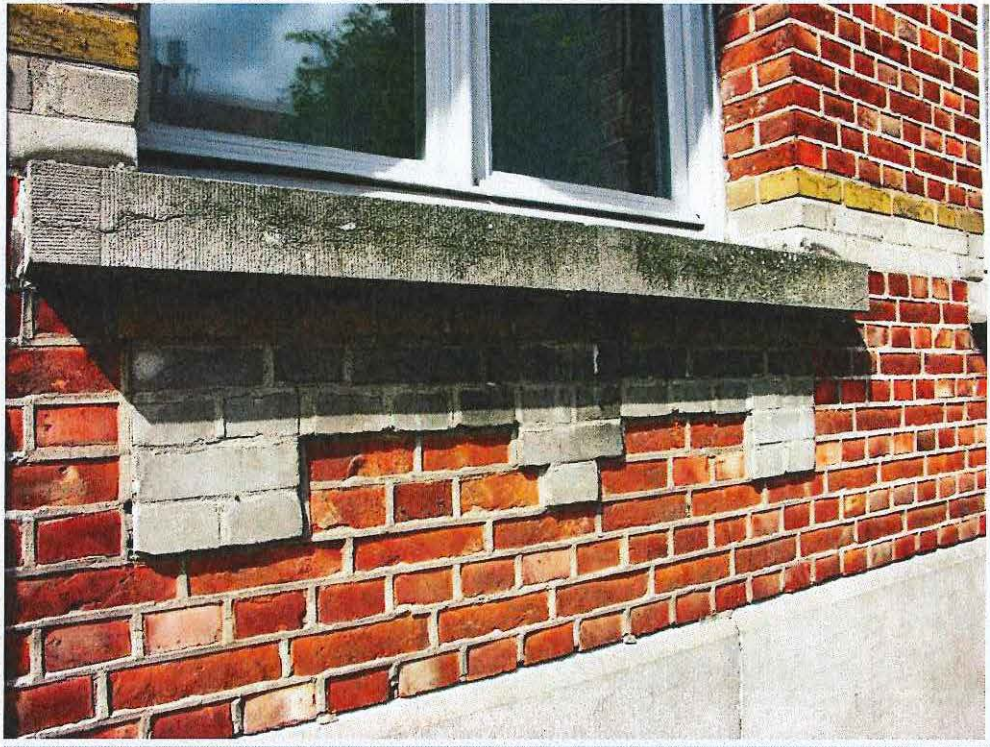
Foto 10: Detail voorgevel met knipvoegwerk-muurbanden en paneeldecoratie in polychroom baksteenmetselwerk
