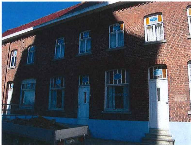
Foto 44: Rozebekeplein 4, gevelpartijen van voormalige winkel-café en woning met gekleurde beglazing in bovenlichten
