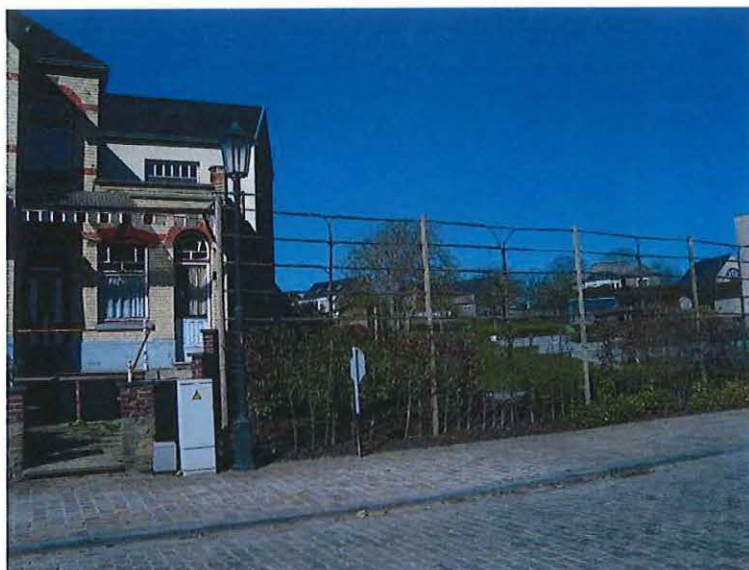
Foto 37: rechtergevel van Villa Rekelberg 2 met naastliggend open tuinperceel bij Rozebekeplein 10
