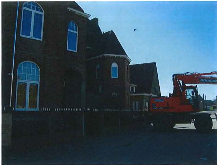
Foto 31: Rozebekeplein 11, voorgevel met voortuintje en hekwerk
