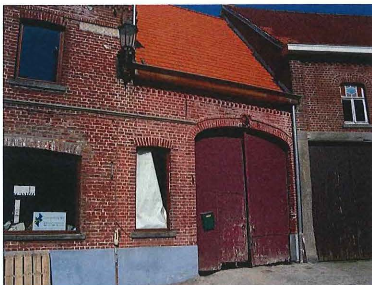
Foto 42: Rozebekeplein 6, lager aanbouwsel met hoevepoort bij vroeger café 'De Klok'
