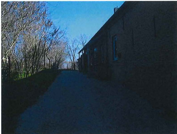
Foto 56: zijgevel Sint-Annastraat 3 met vroegere hoofdvleugel van U-vormige hoevesite
