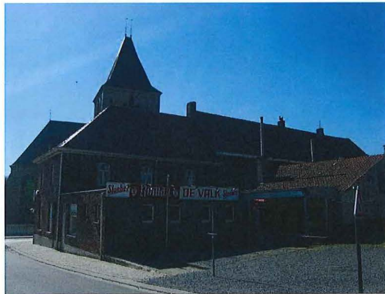
Foto 46: zicht op kerk en achterzijde bebouwing Rozebekeplein 2-4
