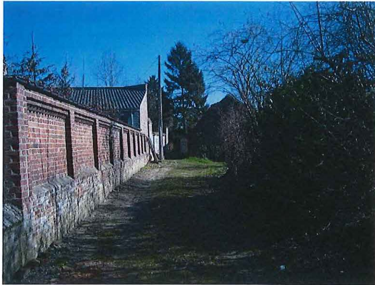
Foto 49: voetweg 13 naast pastoriemuur Rozebekeplein 1
