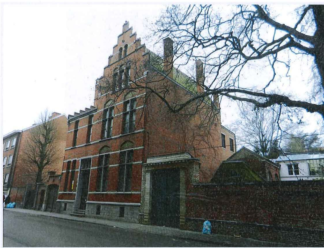
Foto 4 - Noord- en straatgevel van de woning Goffaerts.
