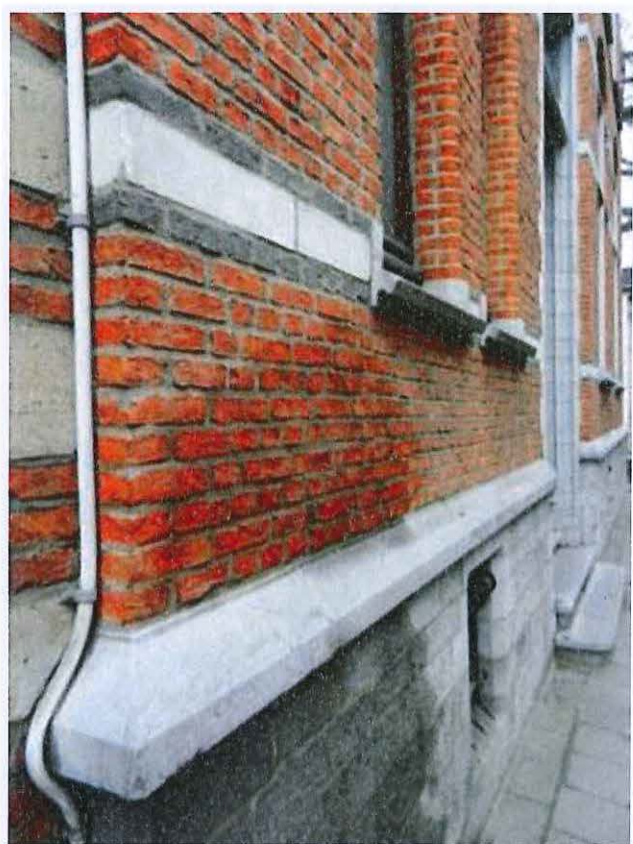
Foto 10 – Straatgevel met hardstenen plint, baksteenmetselwerk en sierbanden in Gobertangesteente en gesmoorde baksteen.
