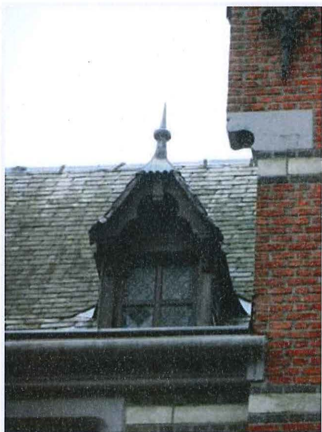
Foto 9 - Dakkapel met windbord in drielobmotief en loden piron.
