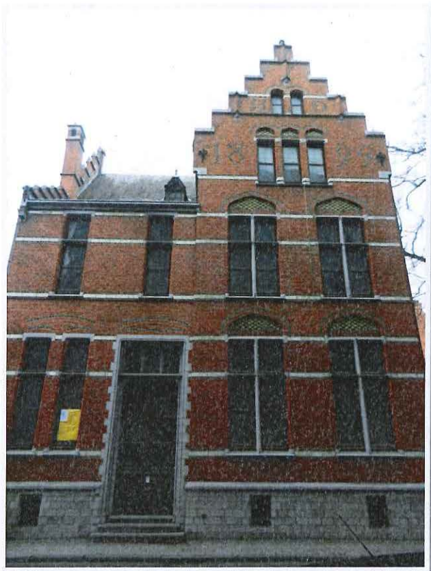
Foto 5 – Straatgevel van de woning.
