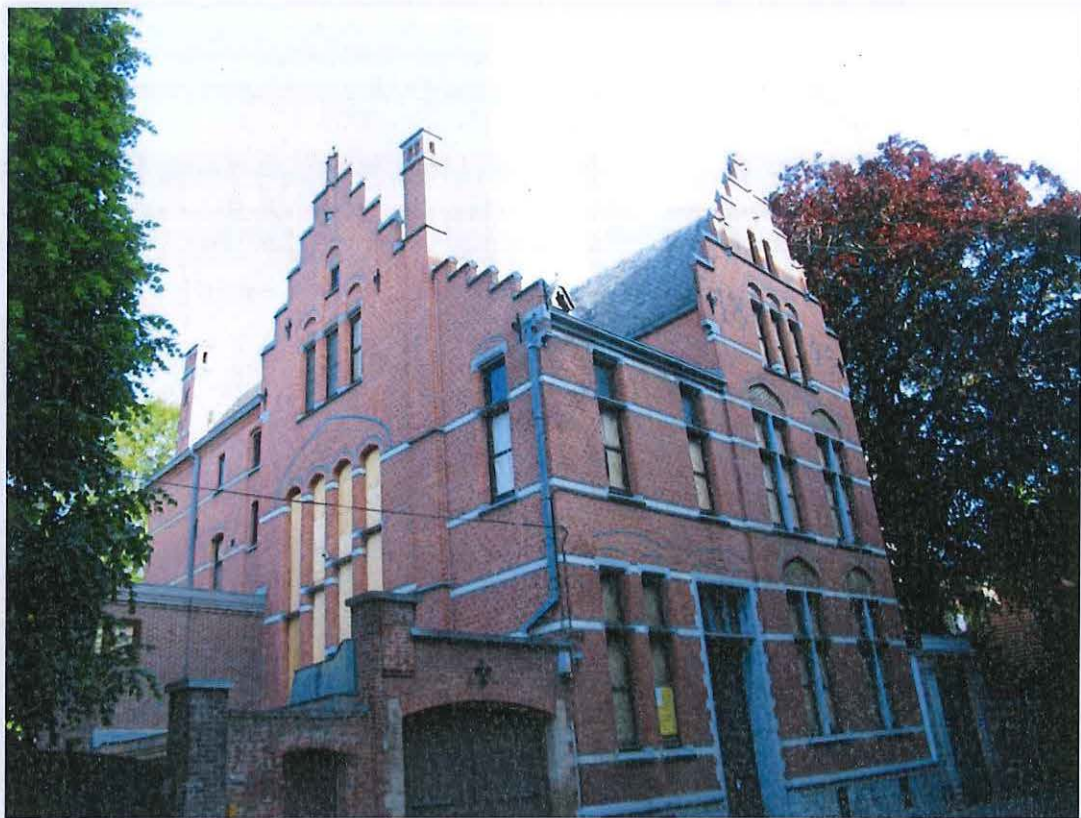
Foto 3 - Straatgevel en zuidelijke tuingevel van de woning Goffaerts.
