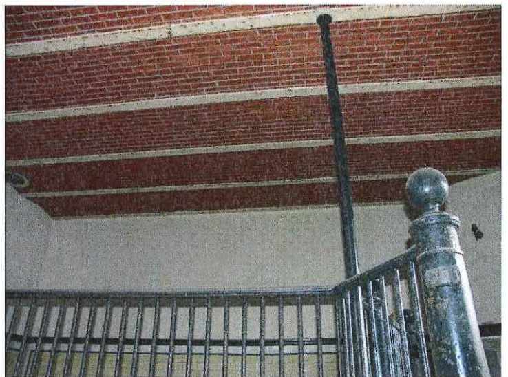
66-67-68-69. Koetshuis: bewaarde paardenboxen met scheidingswand, voederschuiif, bakstenen vloer, voederbakken, betimmering en faiencetegels en troggewelven
