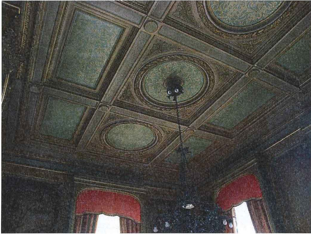
29. Bel-etage: salon hoek Maria-Henriëttalei/Frankrijklei: beschilderd cassettenplafond
