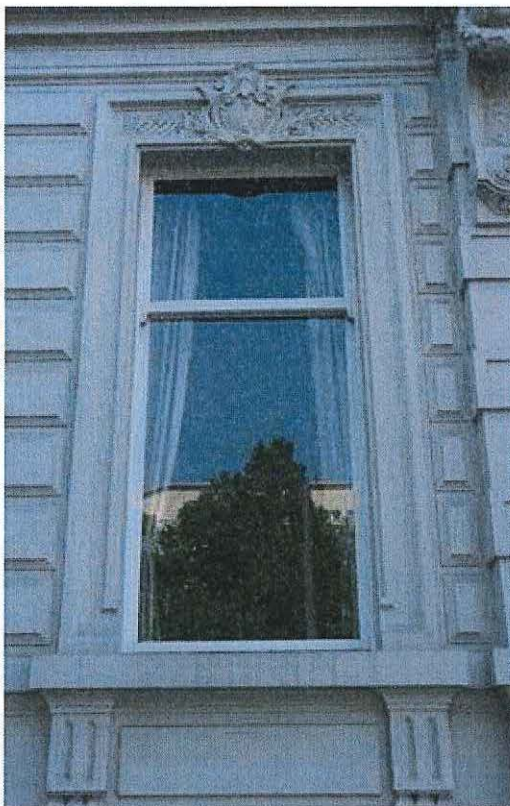
6. Schuifvenster bel-etage met bewaard schrijnwerk
