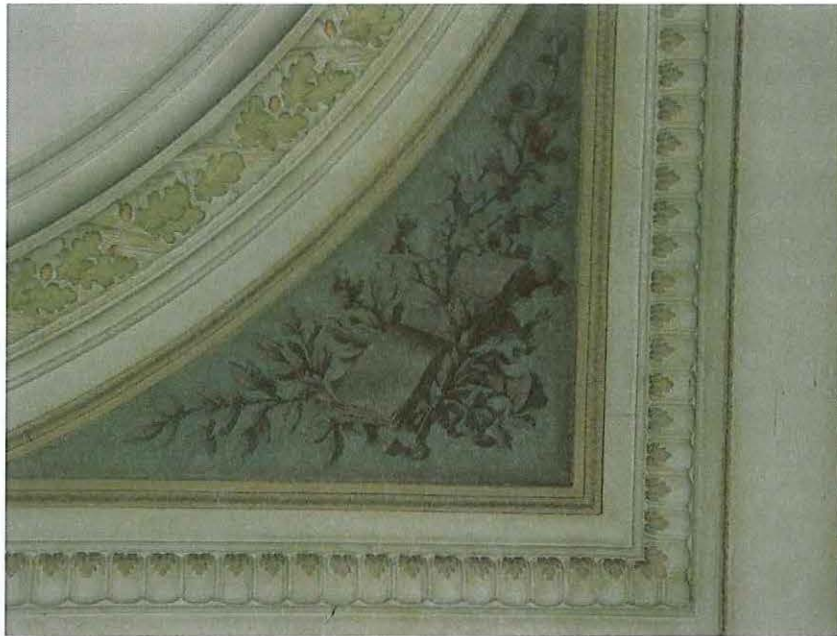
51. Bel-etage: salon zijde binnenplaats: stucplafond met schilderijen van instrumenten in de zwikken
