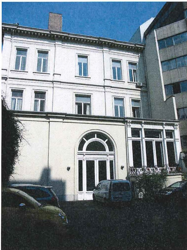
11. Achtergevel zijde binnenplaats
