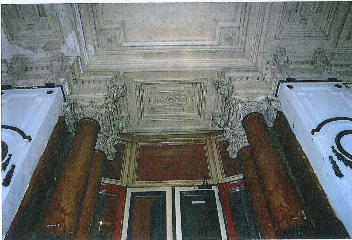
4. Stucwerkplafond en gemarmerde zuilen in de koetsdoorgang richting tochtportaal
