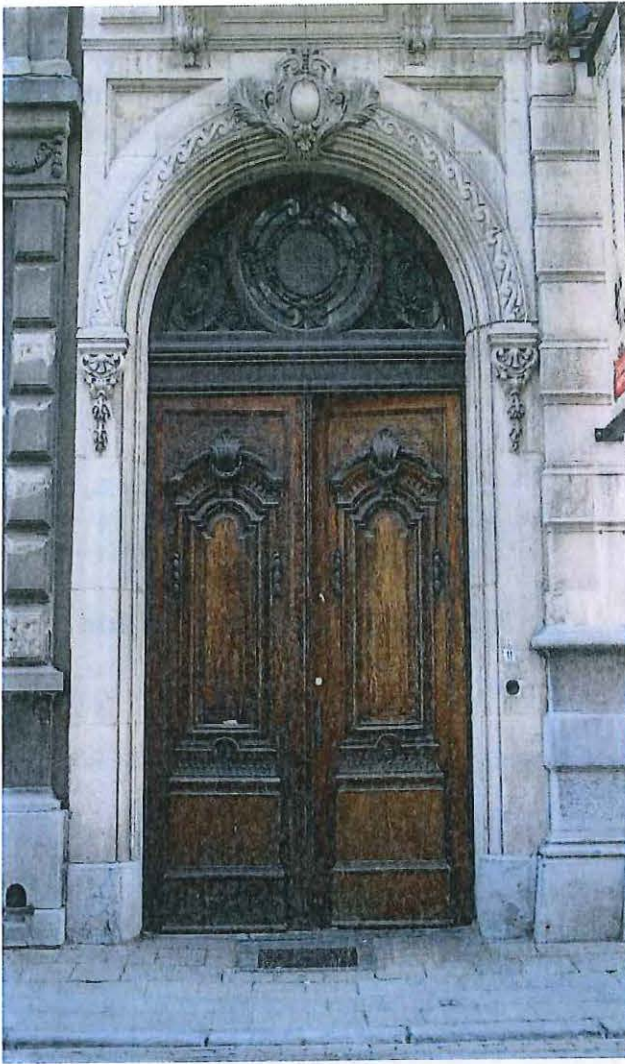
2. Voorgevel – detail rondboogpoort
