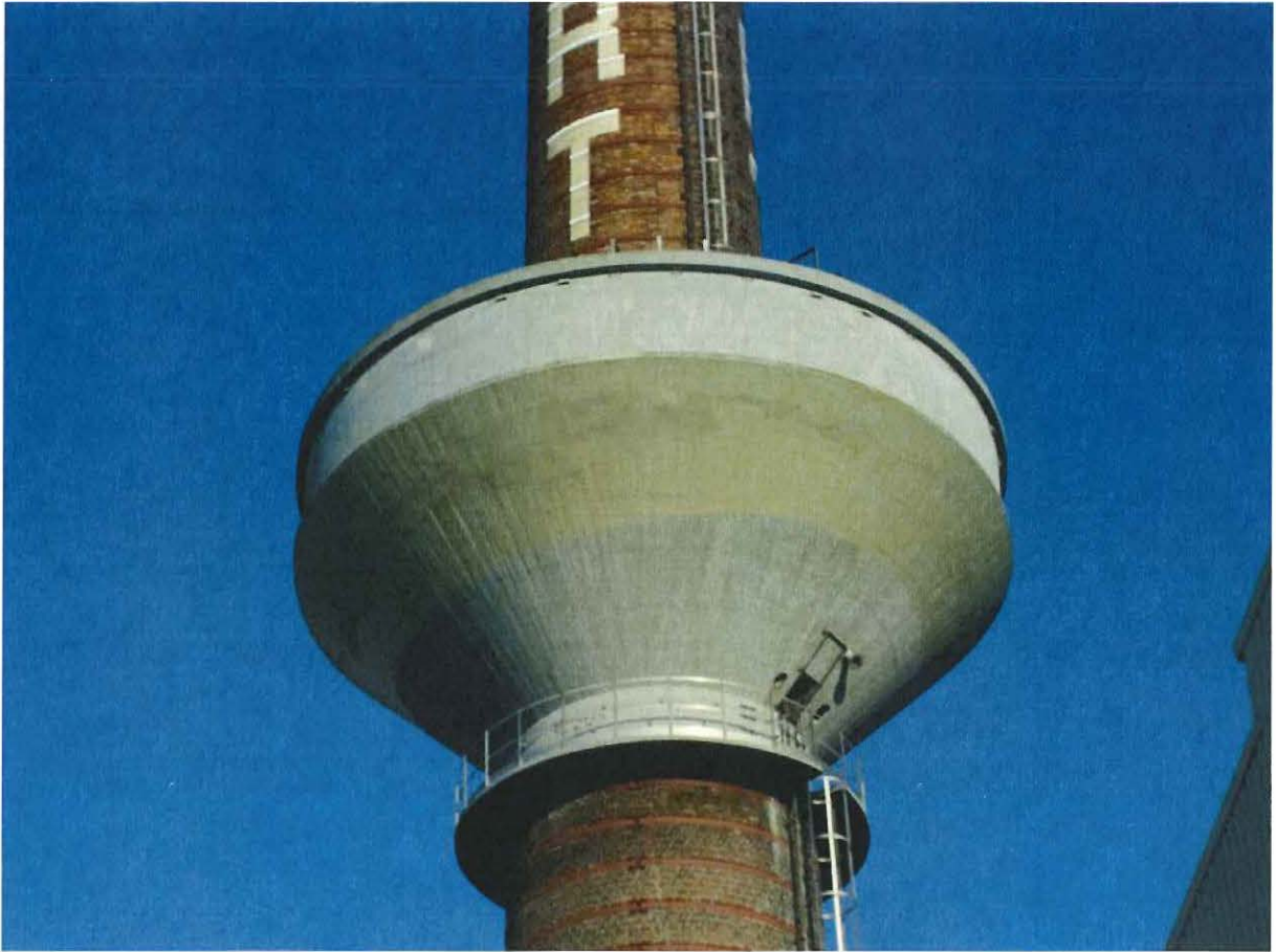
Foto 3 – Het betonnen waterreservoir
