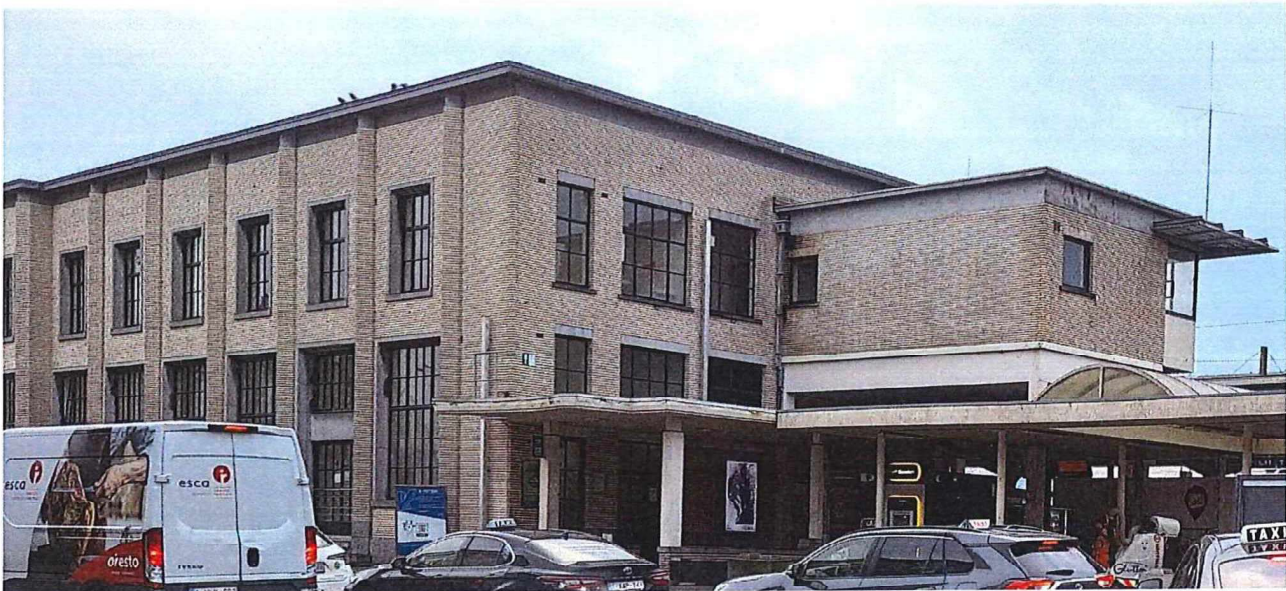
Foto 15: pleingevel en zijgevel met luifel en seinhuis (westzijde).
