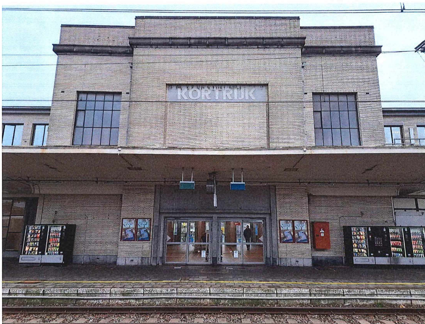
Foto 18: sporgevel (centraal volume met luifel).
