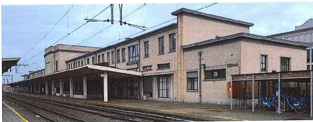
Foto 22: spoorgevel met luifel en oostgevel.
