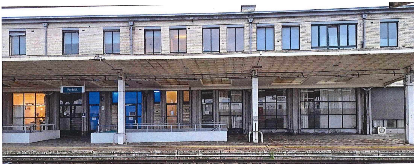
Foto 20: spoorgevel met luifel (oostzijde).
