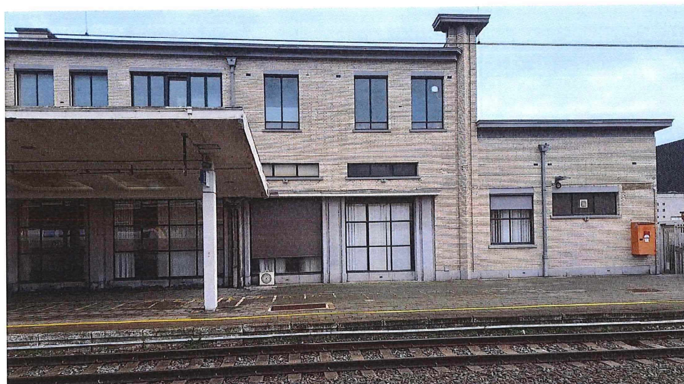
Foto 21: spoorgevel met luifel (oostzijde).
