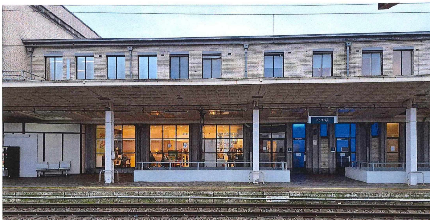
Foto 19: sporgevel met luifel (oostzijde).
