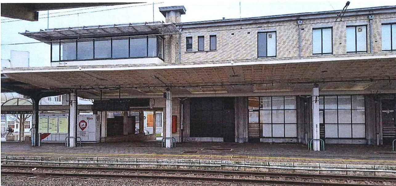
Foto 16: spoorgevel met luifel en seinhuis (westzijde).
