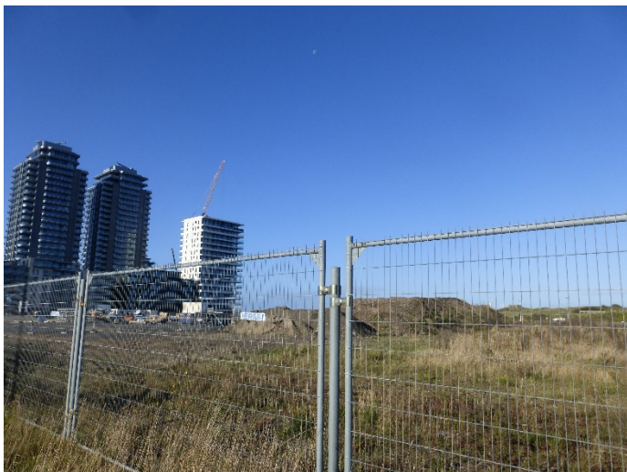
Foto 7: Zicht naar het noordwesten met vooraan dump van grondwerken en werfhekken gezien van op de Fortstraat.
