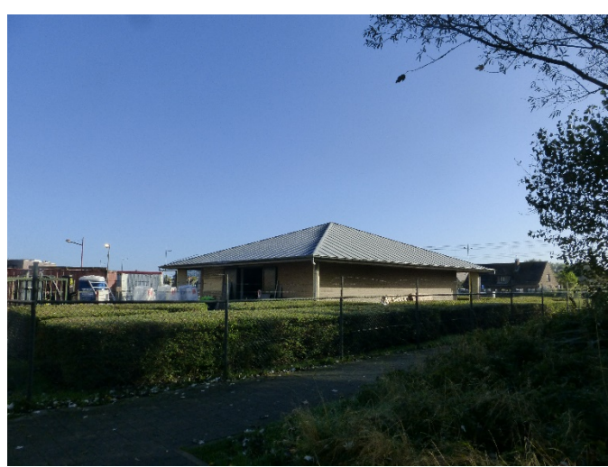
Foto 16: Het nutsgebouw van De Lijn op het kruispunt van de Fortstraat met de Dokter Eduard Moreauxlaan.
