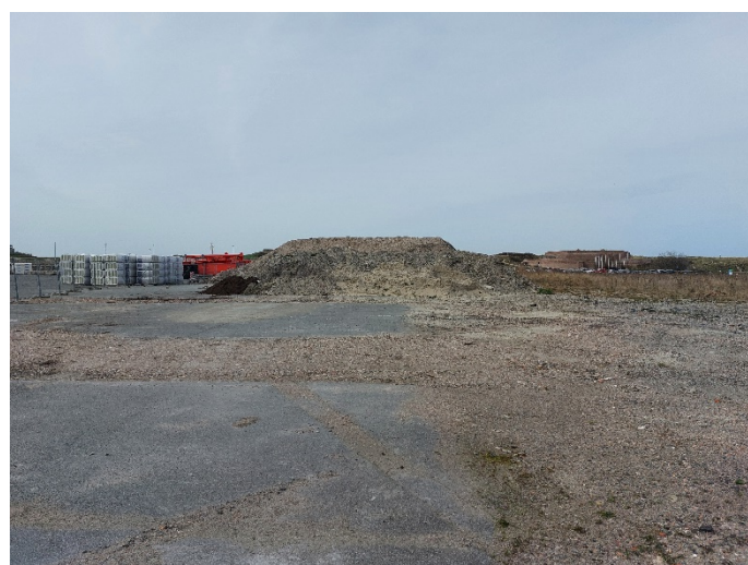
Foto 6: Zicht naar het noorden vanop de Fortstraat met vooraan dump van grondwerken, gezien van op de Fortstraat.
