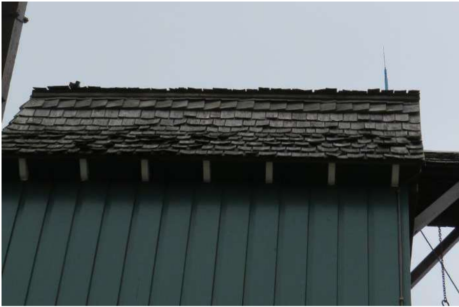
Foto 13 - Hubertmolen. Dakbedekking van de molenkap met eikenhouten schaliën.
