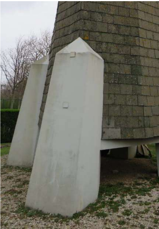
Foto 9 - Hubertmolen. Twee van de vier in beton gegoten teerlingen.
