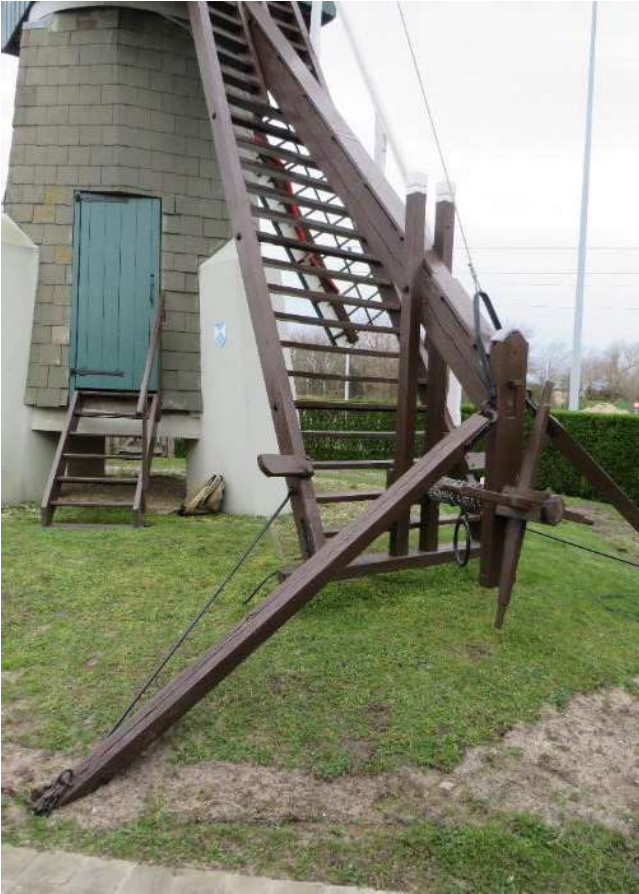
Foto 5 - Hubertmolen. Start met molentrap en kruierwerk.
