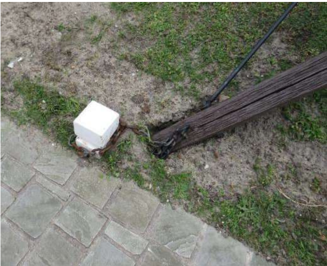
Foto 19 - Hubertmolen. Loopstaak vastgemaakt aan één van de kruipalen.
