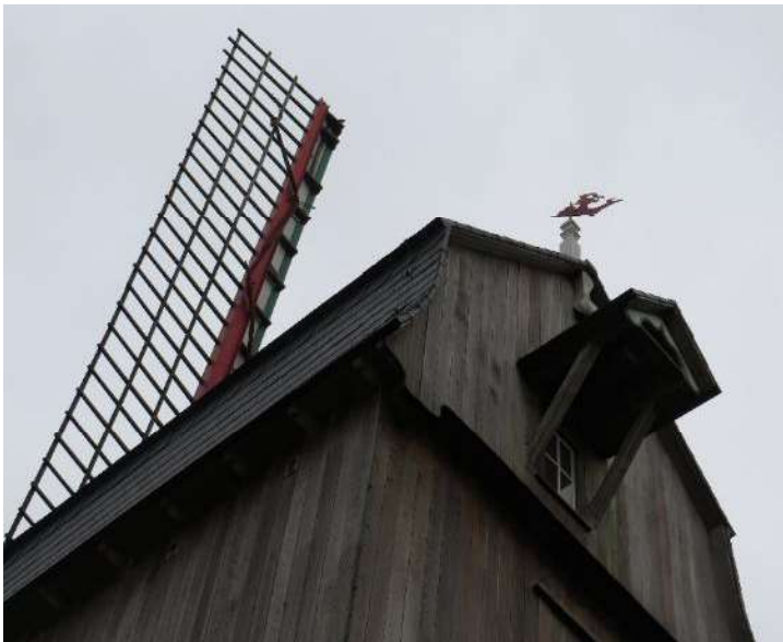
Foto 7 - De Kruisstraatmolen. Molenkap met luikapje en makelaar met windvaan.
