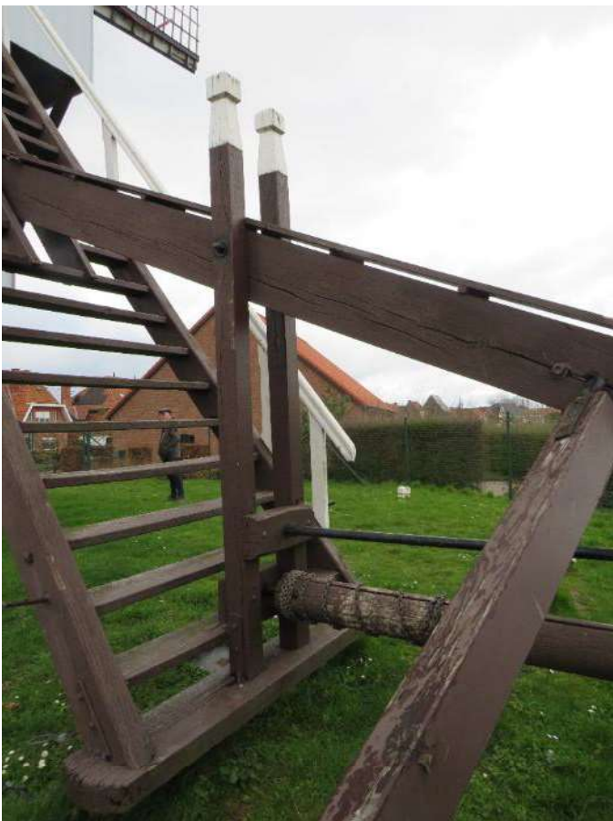
Foto 13 – Molentrap en staartbalk met kruiwerk.
