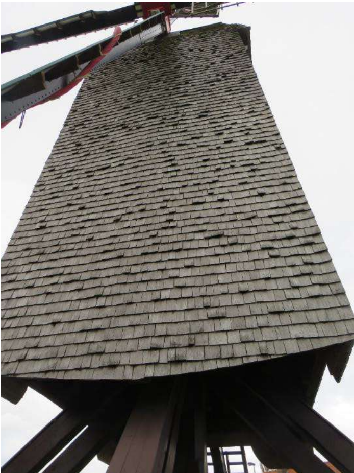
Foto 17 – Met houten schaliën gedekte windzijde.
