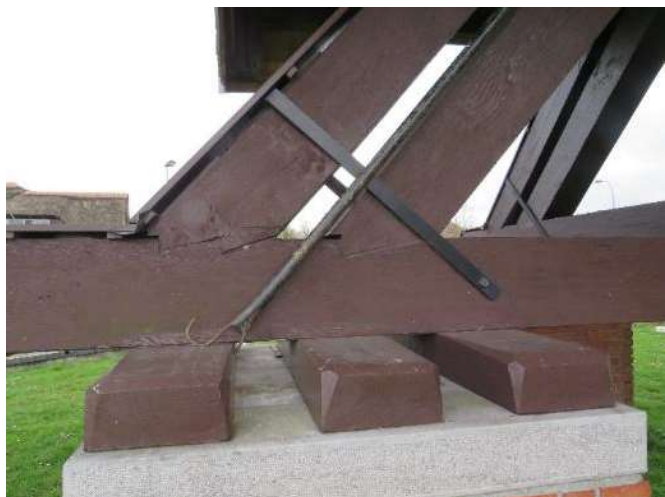
Foto 9 – De lange en korte steekbanden.
