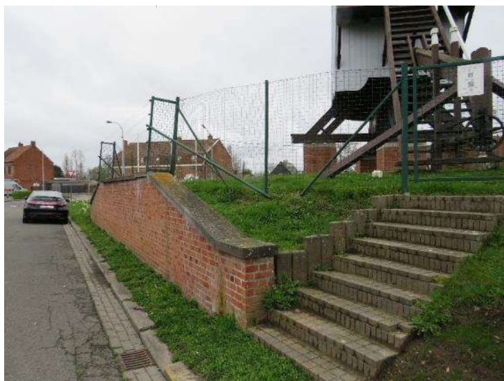
Foto 5 – Keermuur en toegang tot de molenbelt van de Ma Campagnemolen (aan de oostzijde).
