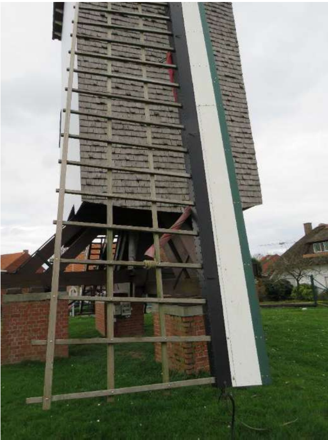
Foto 19 – Hekwerk van het gevluht.
