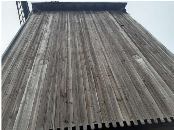
Foto 6: beplanking molenkast (met loergaten en onderaan geschulpt)
