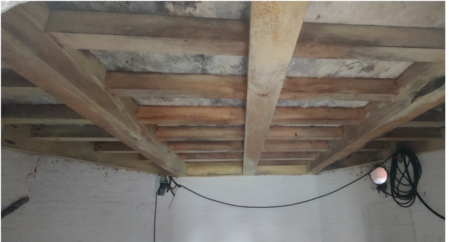
Foto 18: interieur kelder: plafond met eiken balklaag.
