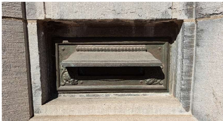
Foto 11. Straatgevel, detail brievensbus rechts van de deur.
