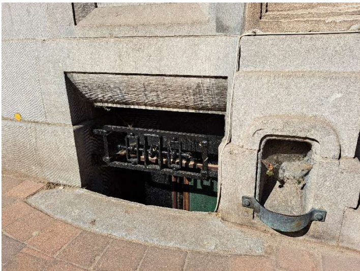
Foto 9. Straatgevel, detail linker keldervenster en voetschraper.
