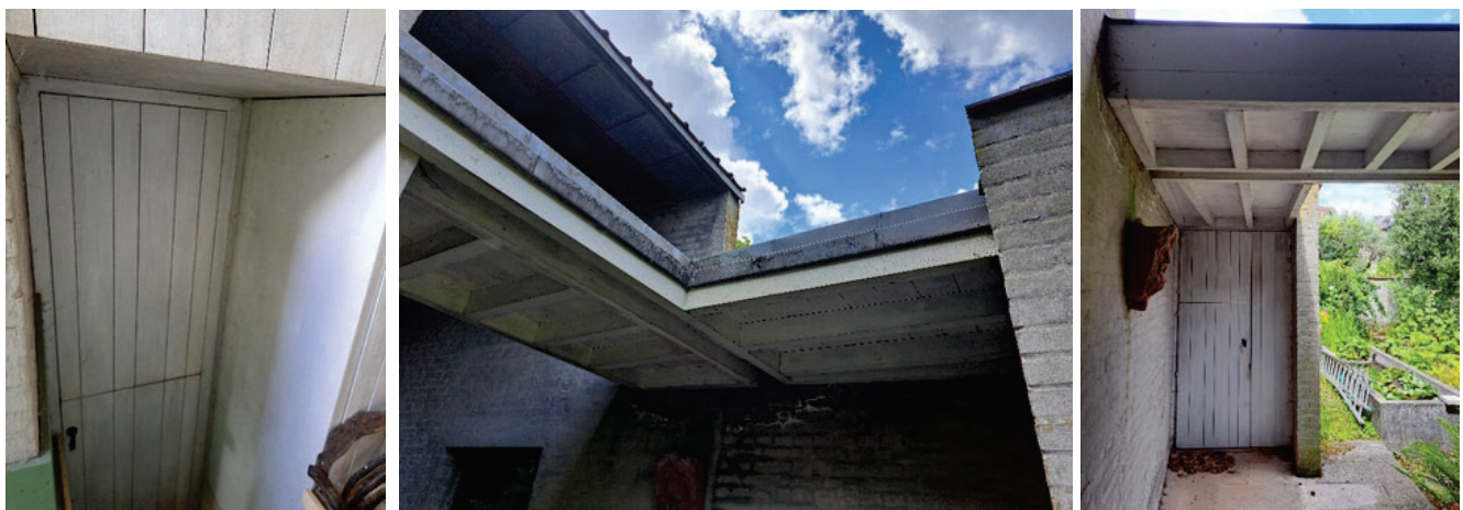
Foto 29-31: achterdeur, galerij en deur van buitentoilet.
