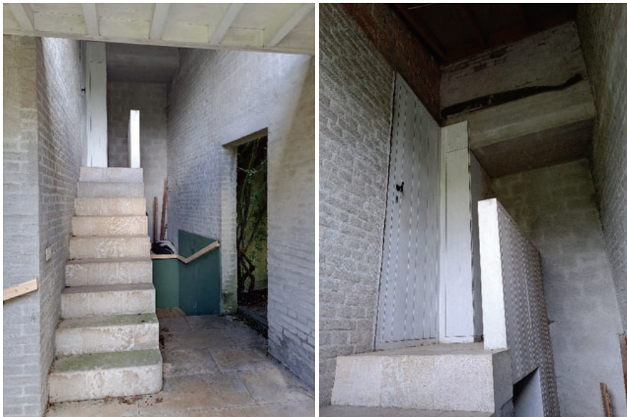
Foto 27-28: buitentrap en deuropening in tuinmuur.
