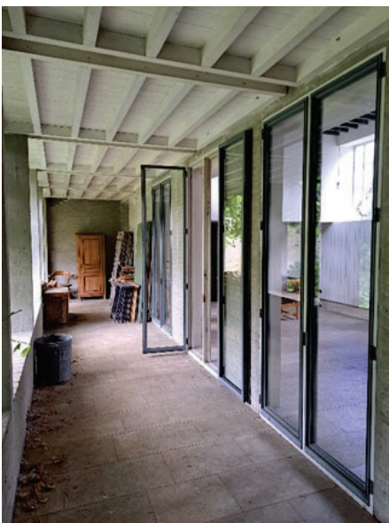
Foto 22-24: galerij en detail van schrijnwerk raamdeur.
