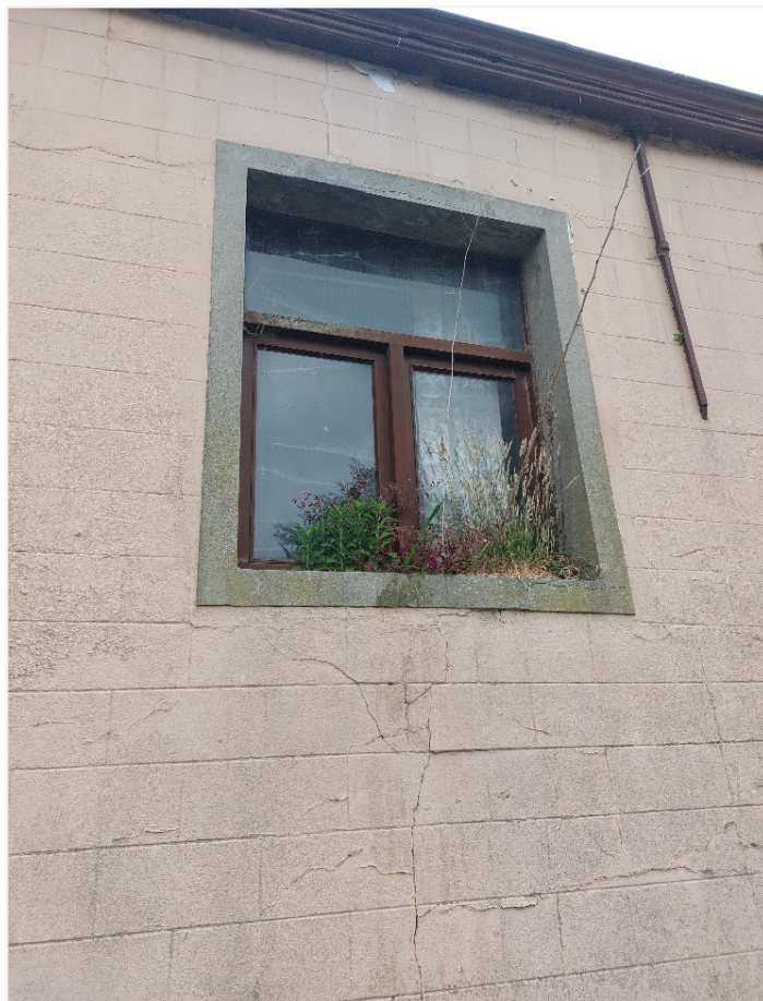
Foto 16: Hoeve, gedateerd 1663, met omgeving. Zicht op opkamervenster erfgevel.
