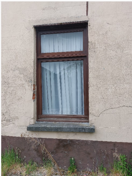
Foto 25: Hoeve, gedateerd 1663, met omgeving. Zicht op achtergevel boerenhuis.
