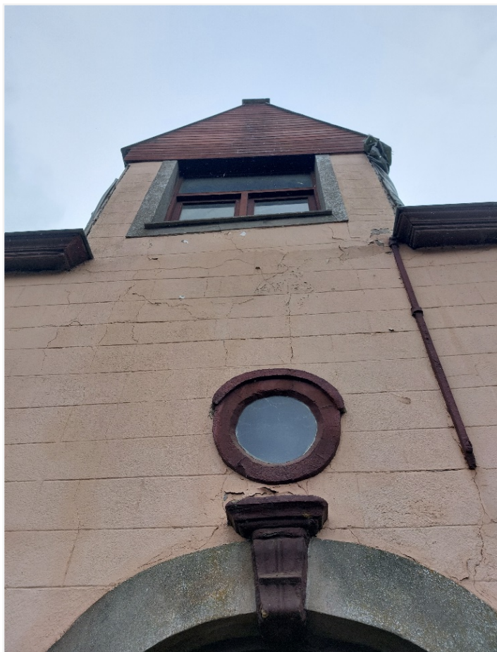
Foto 15: Hoeve, gedateerd 1663, met omgeving. Zicht op voordeur met bovenlicht en dakkapel erfgevel.
