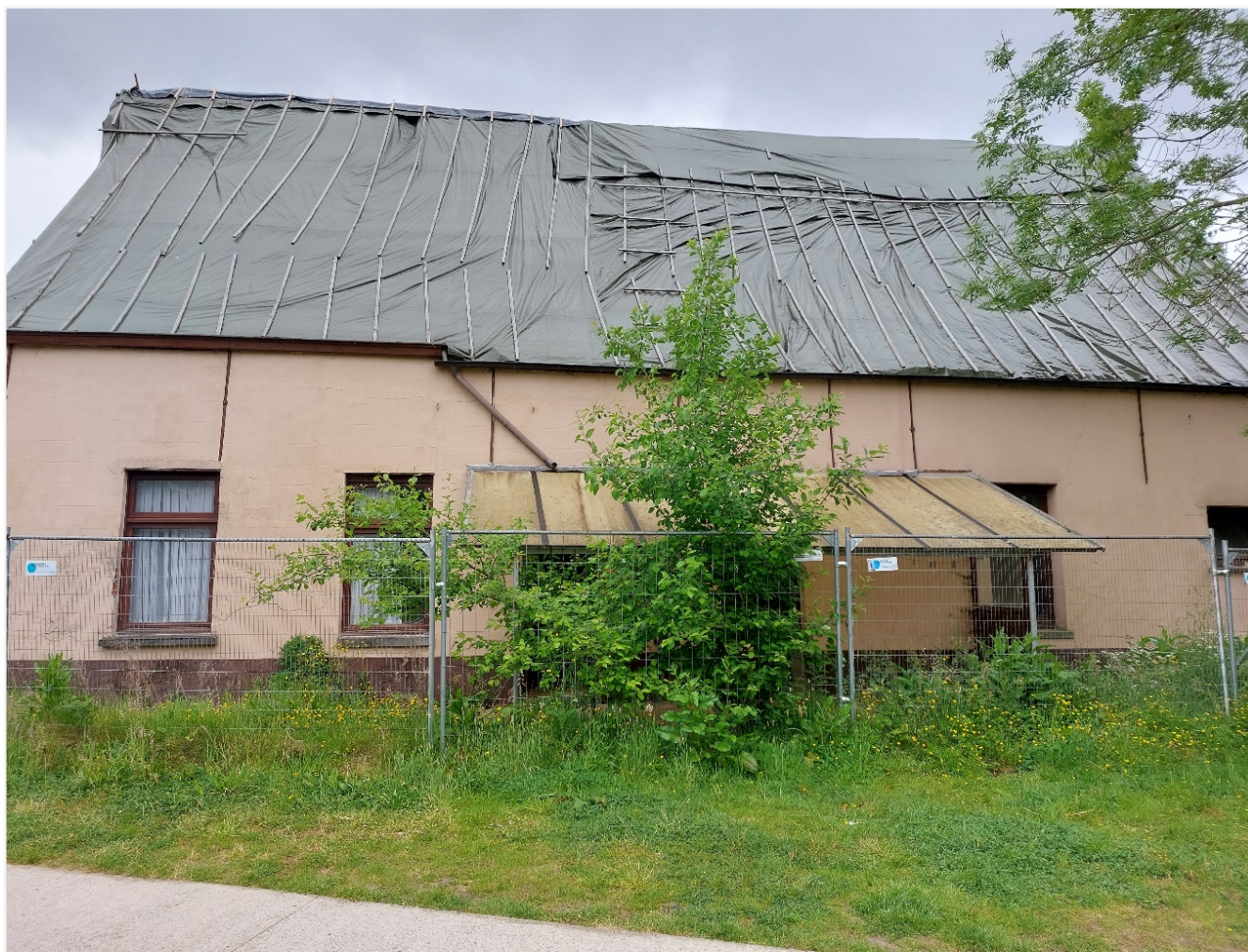
Foto 23: Hoeve, gedateerd 1663, met omgeving. Zicht op achtergevel boerenhuis.
