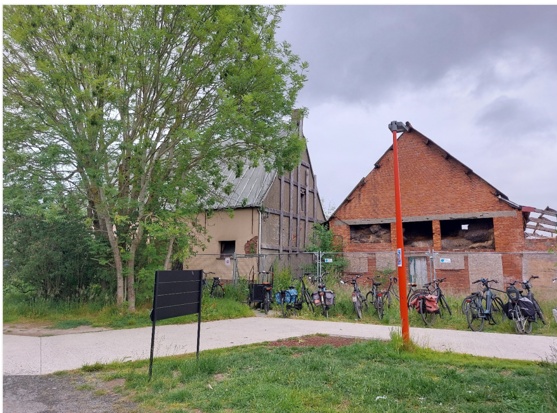
Foto 30: Hoeve, gedateerd 1663, met omgeving. Zicht op achtergevel en op kopgevel van dwarsschuur, toegangspad naar achterliggende school aangelegd op vroeger erf; in knik bevond zich stalletje uit begin 20ste eeuw. (D).
