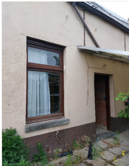
Foto 26: Hoeve, gedateerd 1663, met omgeving. Zicht op achtergevel boerenhuis met achterdeur.
