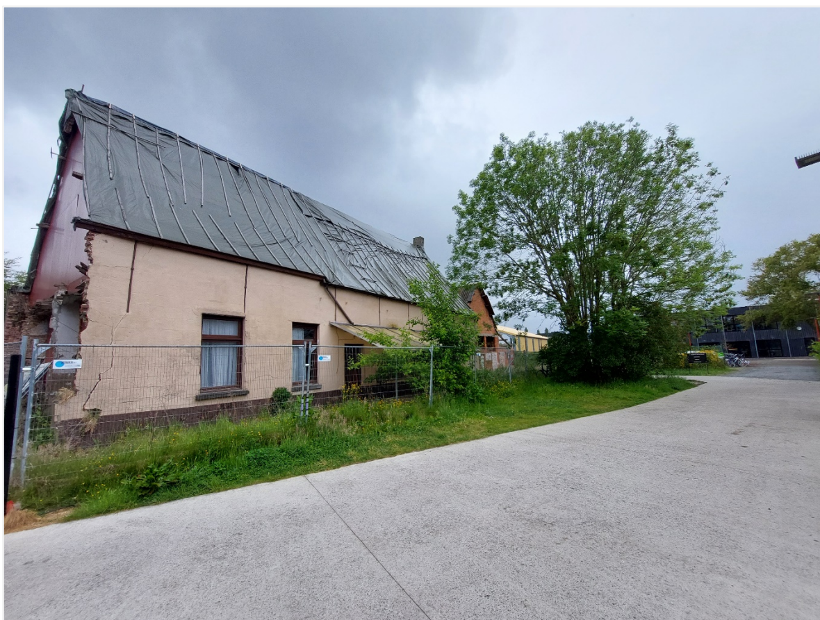
Foto 19: Hoeve, gedateerd 1663, met omgeving. Zicht op achtergevel boerenhuis met toegangsweg naar achterliggende school aangelegd op vroeger erf.
