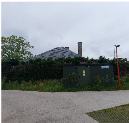
Foto 20: Hoeve, gedateerd 1663, met omgeving. Zicht op haag met Vlyminckshoek 2, toegangspad en elektriciteitscabine (D) op vroeger erf.
