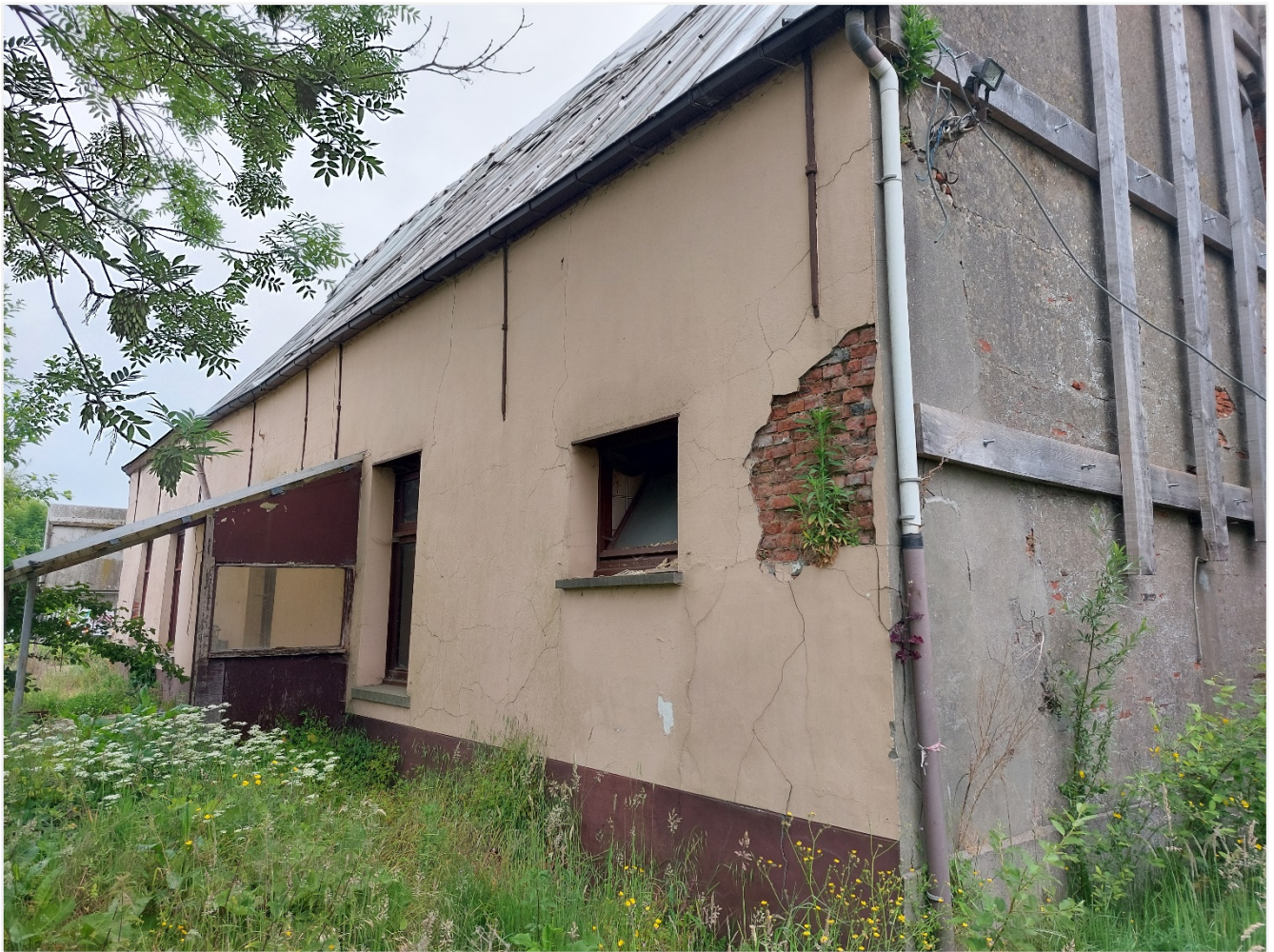
Foto 24: Hoeve, gedateerd 1663, met omgeving. Zicht op achtergevel boerenhuis.
