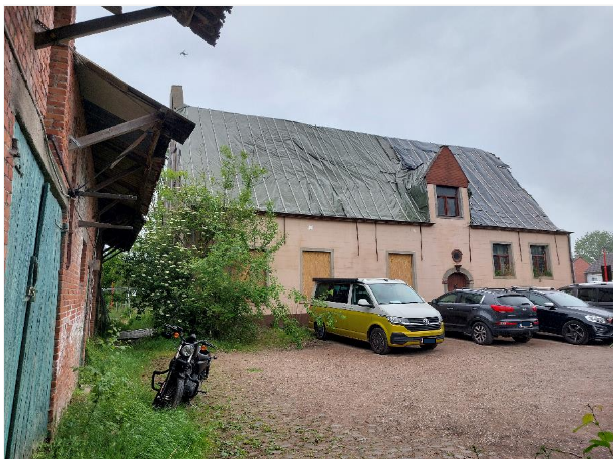
Foto 6: Hoeve, gedateerd 1663, met omgeving. Zicht op boerenhuis met nooddak en erfgevel van dwarsschuur.
