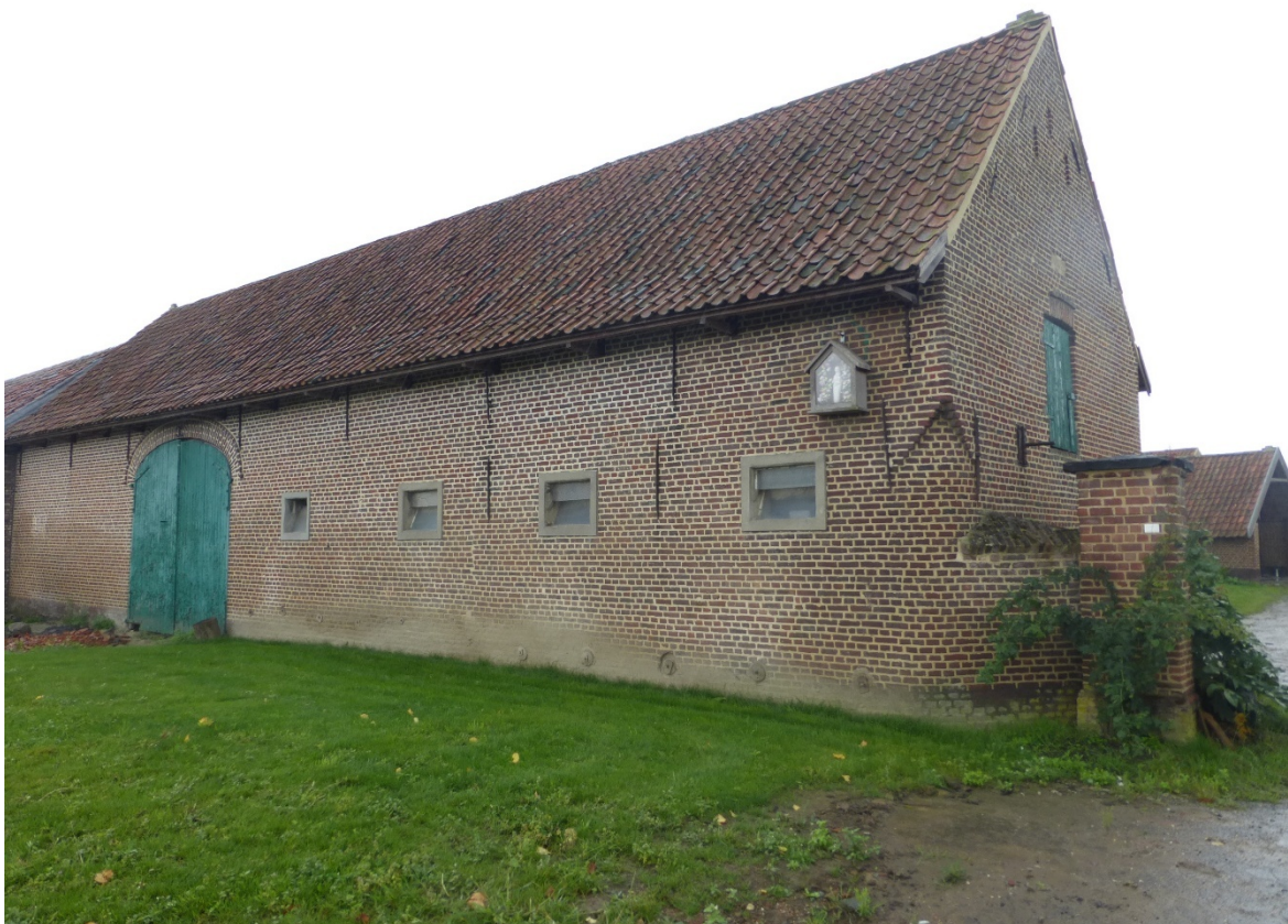
Foto 4. De achtergevel en de zijgevel van de dwarsschuur. Overgang tussen achtergevel en zijgevel met afgeronde hoek.
