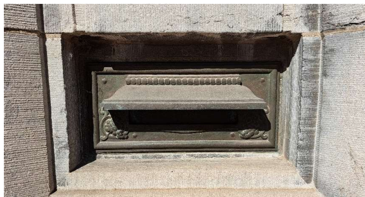
Foto 11. Straatgevel, detail brievensbus rechts van de deur.
