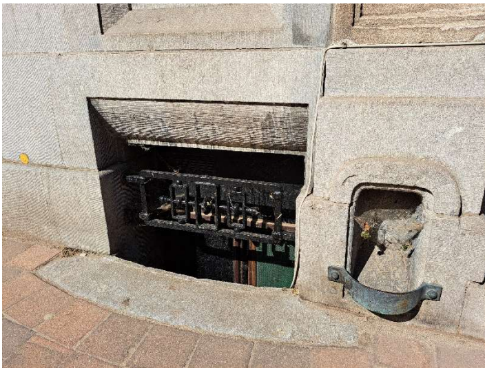
Foto 9. Straatgevel, detail linker keldervenster en voetschraper.
