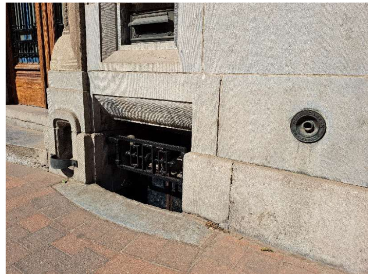
Foto 10. Straatgevel, detail rechter keldervenster, voetschraper en wateraansluiting.
