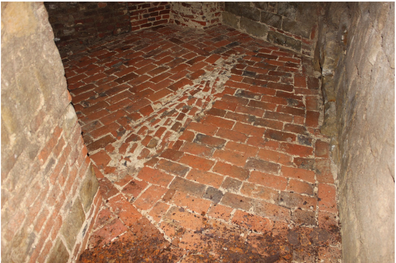
Foto 11 : oorspronkelijke bakstenen vloer van de noordoostelijke schietkamer van de bovenverdieping van het rondeel.
