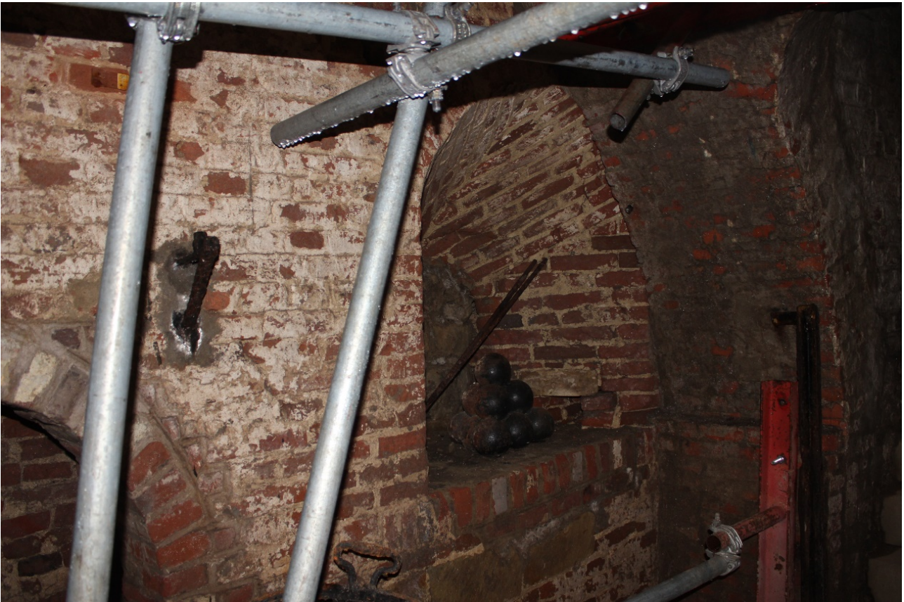
Foto 20: zuidelijke wand van de grote zaal ter hoogte van de bovenverdieping van het ronddeel, met rookkanaal en kanongat.
