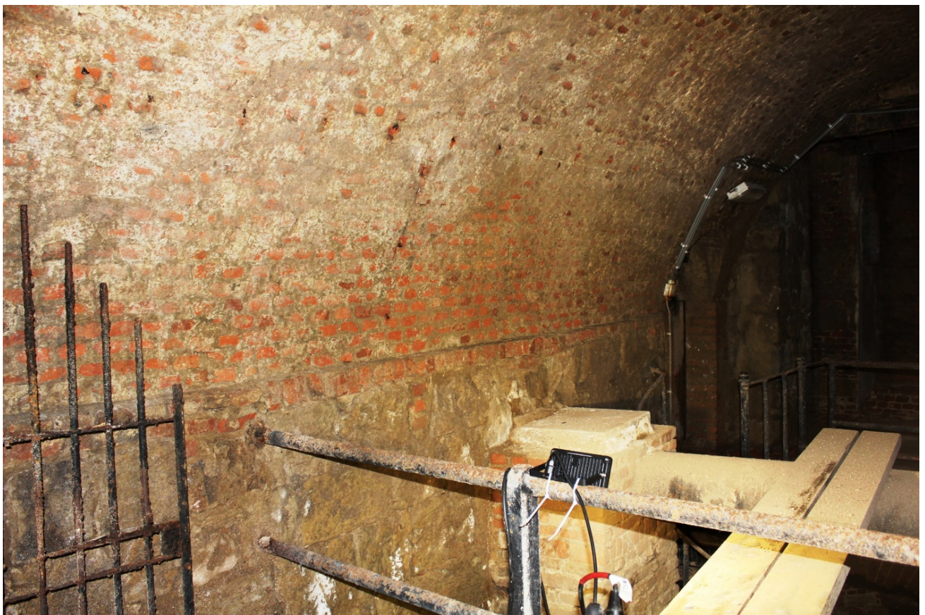
Foto 2: de grote zaal met de oostelijke wand van het poortgebouw, ter hoogte van de bovenverdieping en gezien vanuit het zuiden. Onder het 19de-eeuwse tongewelf in baksteen is het metselwerk in Lincint tufsteen uit de 12de eeuw zichtbaar.
