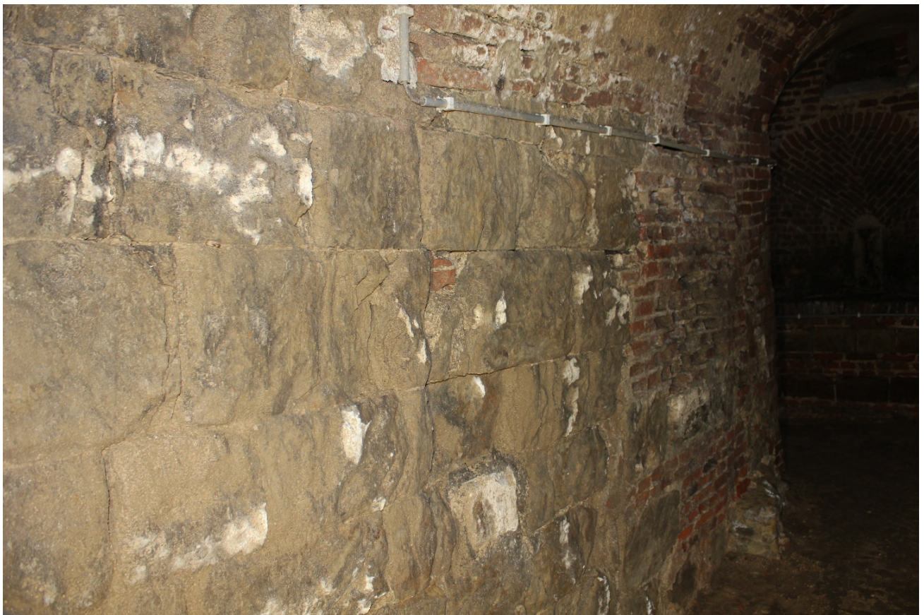
Foto 6: de grote zaal met de westelijke wand van de voorburch, ter hoogte van de benedenverdieping en gezien vanuit het noorden. Vervolg van het metselwerk in Lincant tufsteen uit de 12de eeuw.
