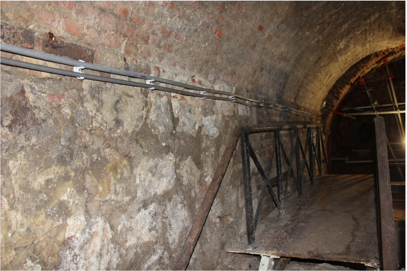
Foto 3: de grote zaal met de westelijke wand van de voorburcht, ter hoogte van de bovenverdieping en gezien vanuit het noorden, met metselwerk in Lincent tufsteen uit de 12de eeuw.
