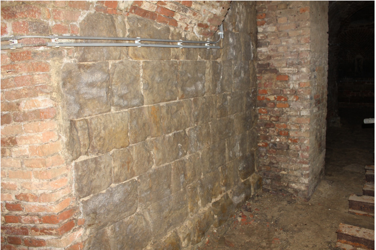
Foto 5: de grote zaal met de westelijke wand van de voorburch, ter hoogte van de benedenverdieping en gezien vanuit het noorden. Op de voorgrond het metselwerk in Lincant tufsteen uit de 12de eeuw.
