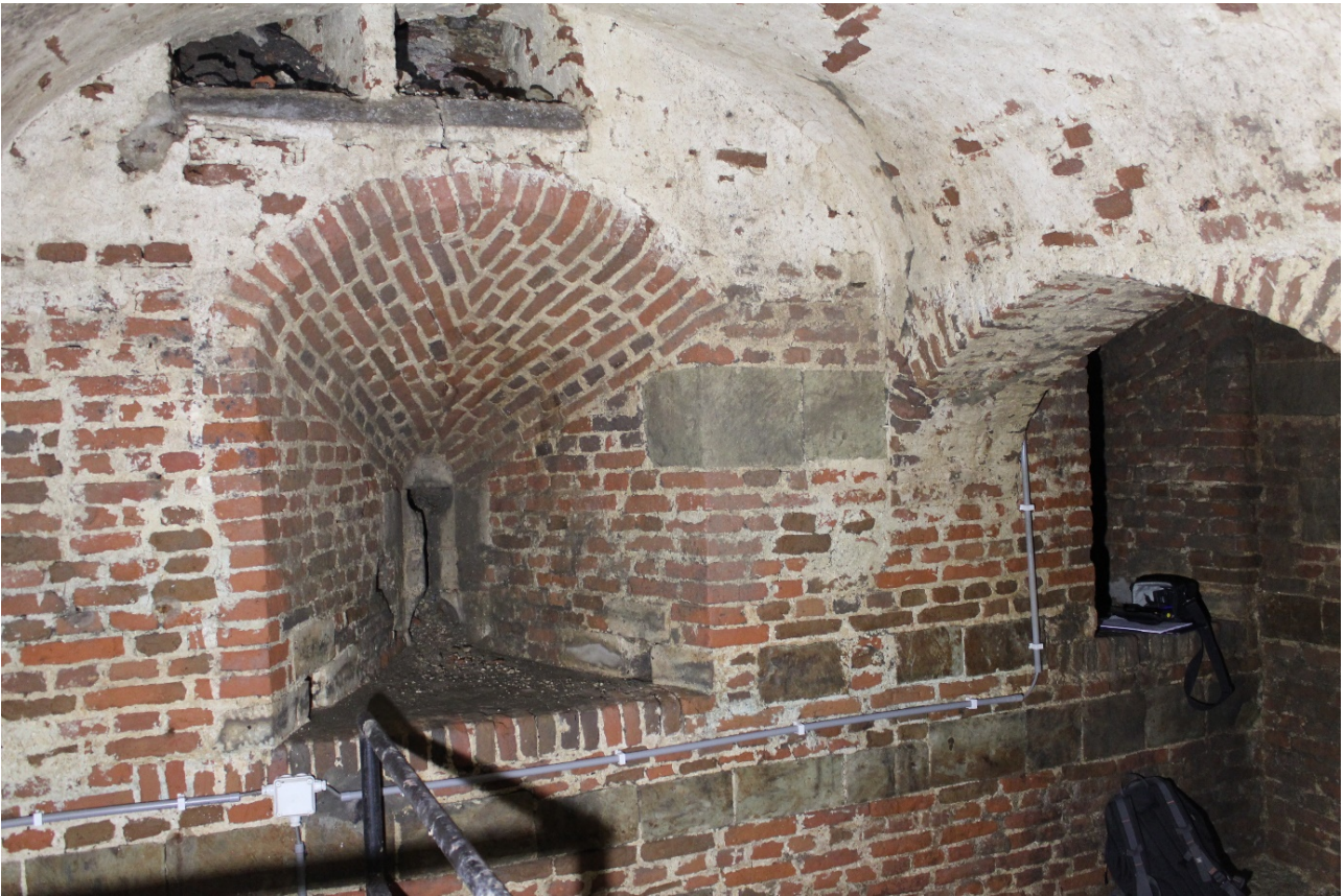
Foto 36: twee kanongaten en een rookkanaal in de zuidelijke wand van de grote zaal in de benedenverdieping van het rondel.
