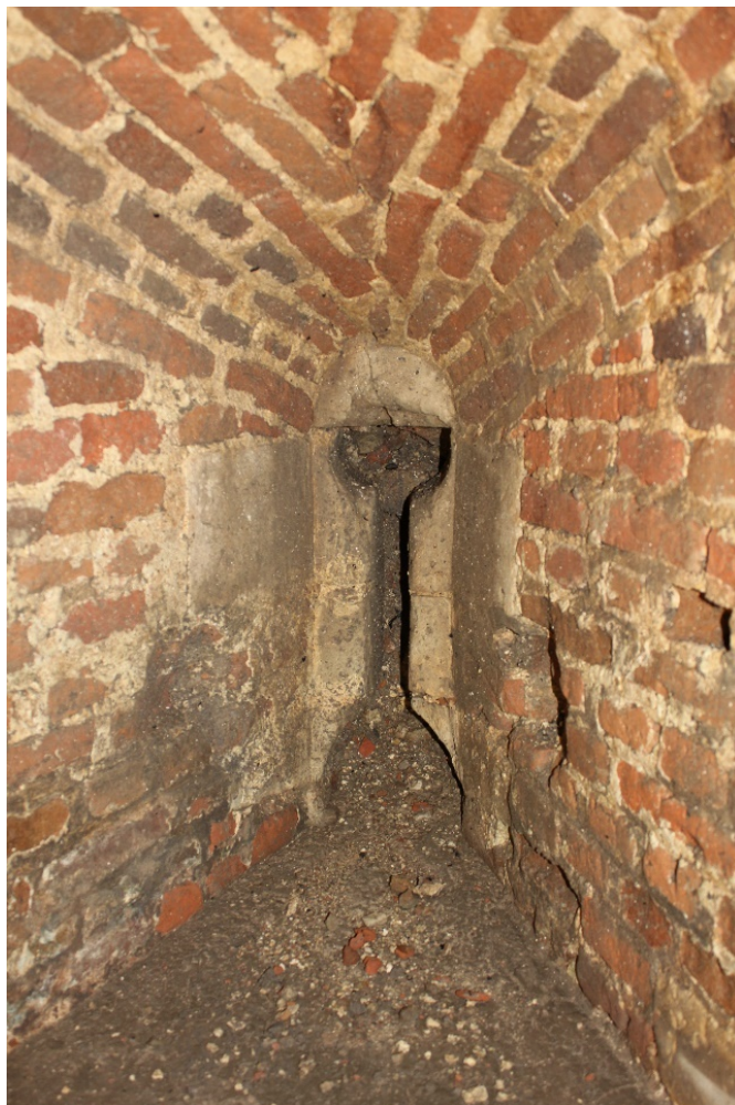
Foto 39: natuurstenen schietspleet van het kanongaten in de zuidelijke wand van de grote zaal in de benedenverdieping van het rondeel.
