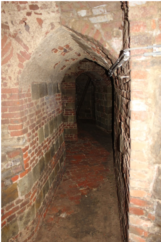
Foto 25 (links): gang naar de noordoostelijke schietkamer van de benedenverdieping van het rondel. Zicht op de noordelijke wand met speklagen in Lincen tufsteen en baksteen.
