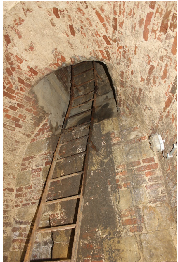
Foto 30 (links): kanongat in de tweede noordoostelijke schietkamer van de benedenverdieping van het rondeel. Met gedicht rookkanaal.
