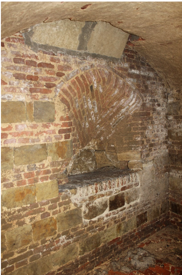
Foto 30 (links): kanongat in de tweede noordoostelijke schietkamer van de benedenverdieping van het rondeel. Met gedicht rookkanaal.
