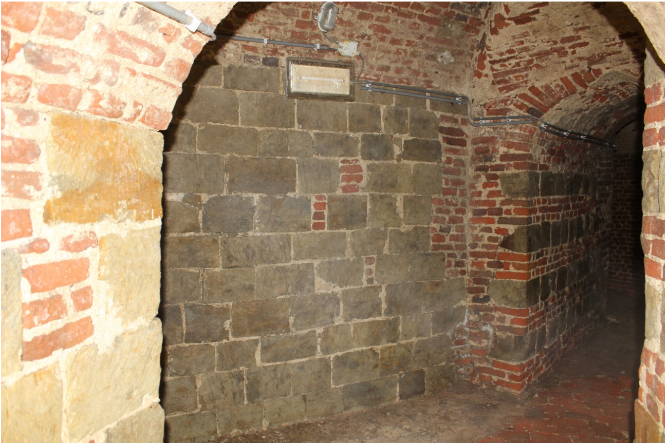
Foto 32: zuidelijke wand in Lincient tufsteen van de eerste noordoostelijke schietkamer van de benedenverdieping van het rondeel.
