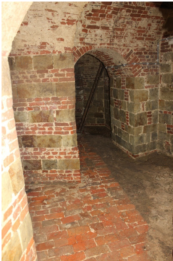
Foto 27 (links): eerste noordoostelijke schietkamer van de benedenverdieping van het rondel, met bewaarde bakstenen vloer.
