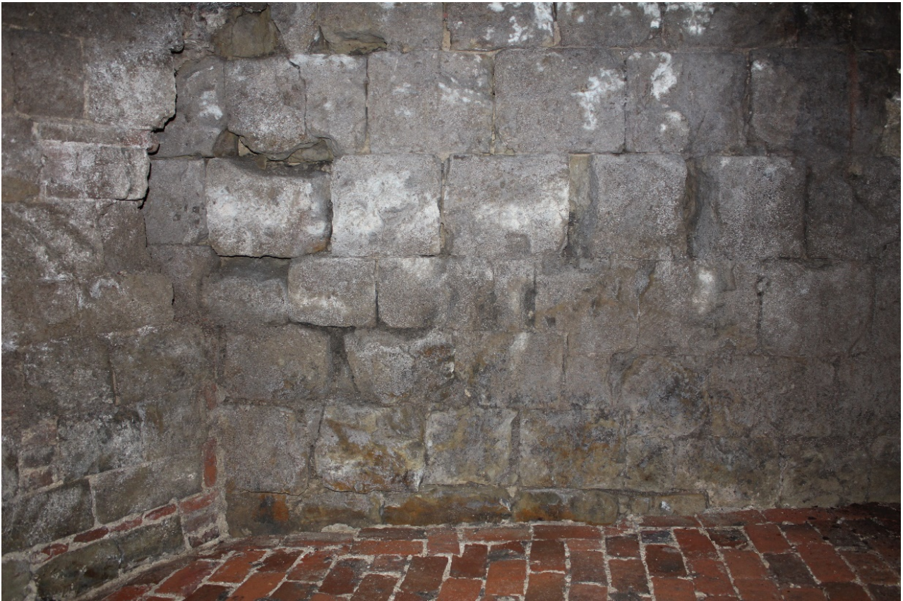
Foto 14: zuidoostelijke muur in Lincence tufsteen en bakstenen vloer van de noordoostelijke schietkamer van de bovenverdieping van het rondeel.
