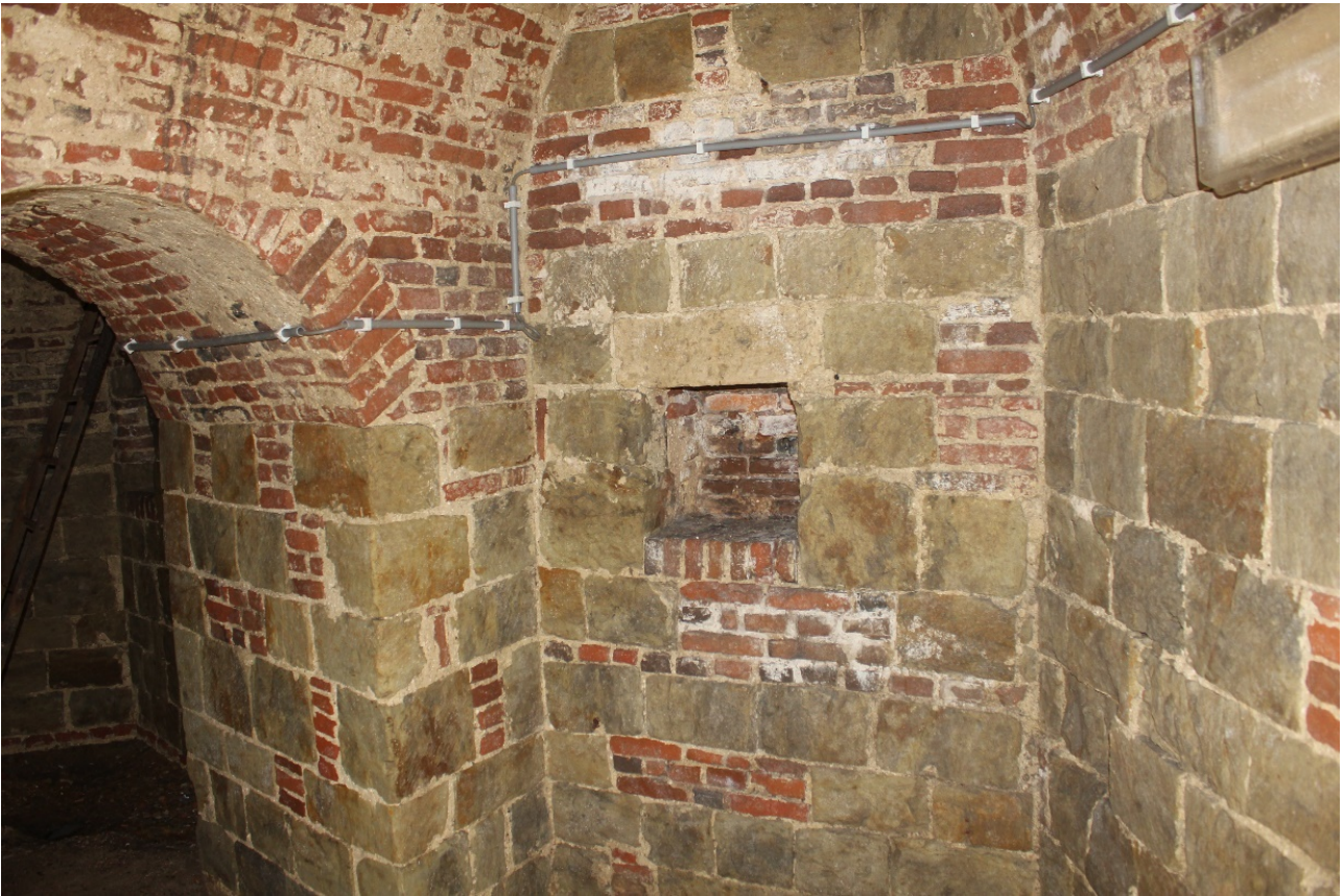
Foto 29: zuidoostelijke wand van de tweede noordoostelijke schietkamer van de benedenverdieping van het rondeel. Met schietgat.
