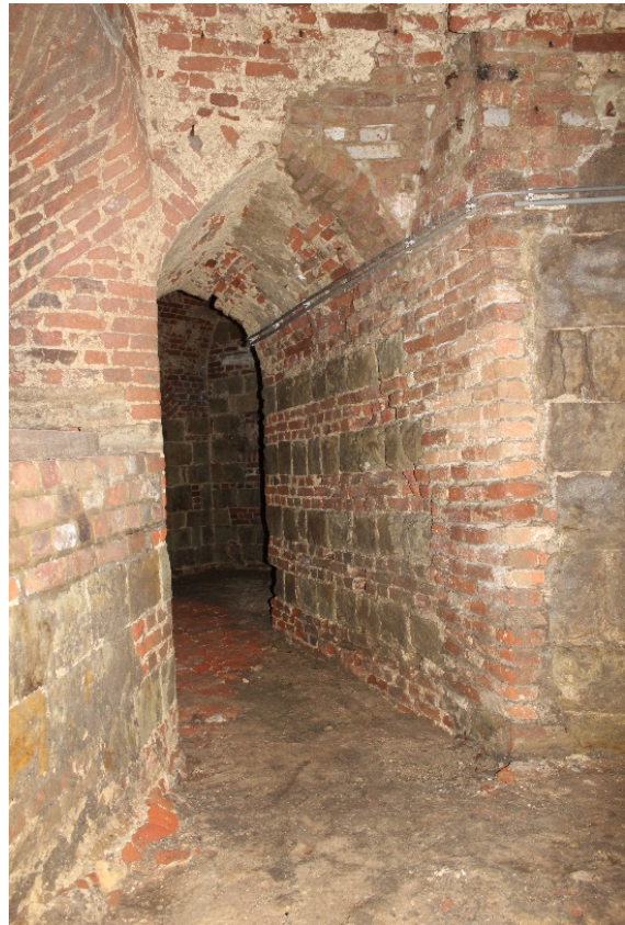
Foto 25 (links): gang naar de noordoostelijke schietkamer van de benedenverdieping van het rondel. Zicht op de noordelijke wand met speklagen in Lincen tufsteen en baksteen.
