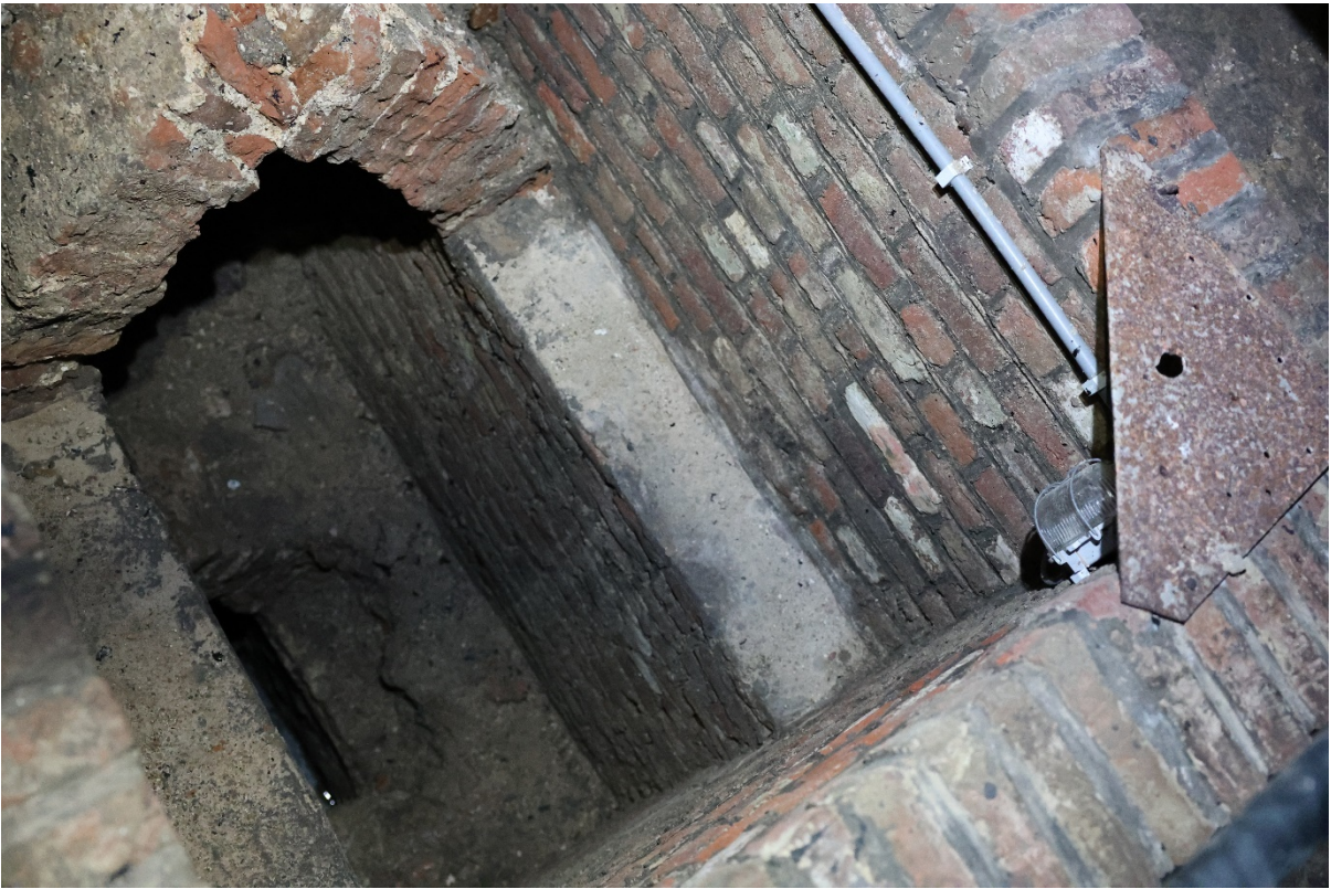
Foto 38: zicht op de kanalisaties onder de grote zaal (benedenverdieping).
