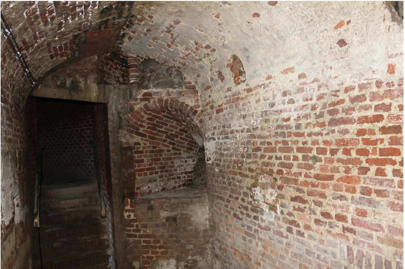
Foto 16: de zuidoostelijke schietkamer van de bovenverdieping van het rondeel, gezien in zuidoostelijke richting. Naast de doorgang naar de huidige toegangsruimtes bevinden zich een kanongat en een rookkanaal.
