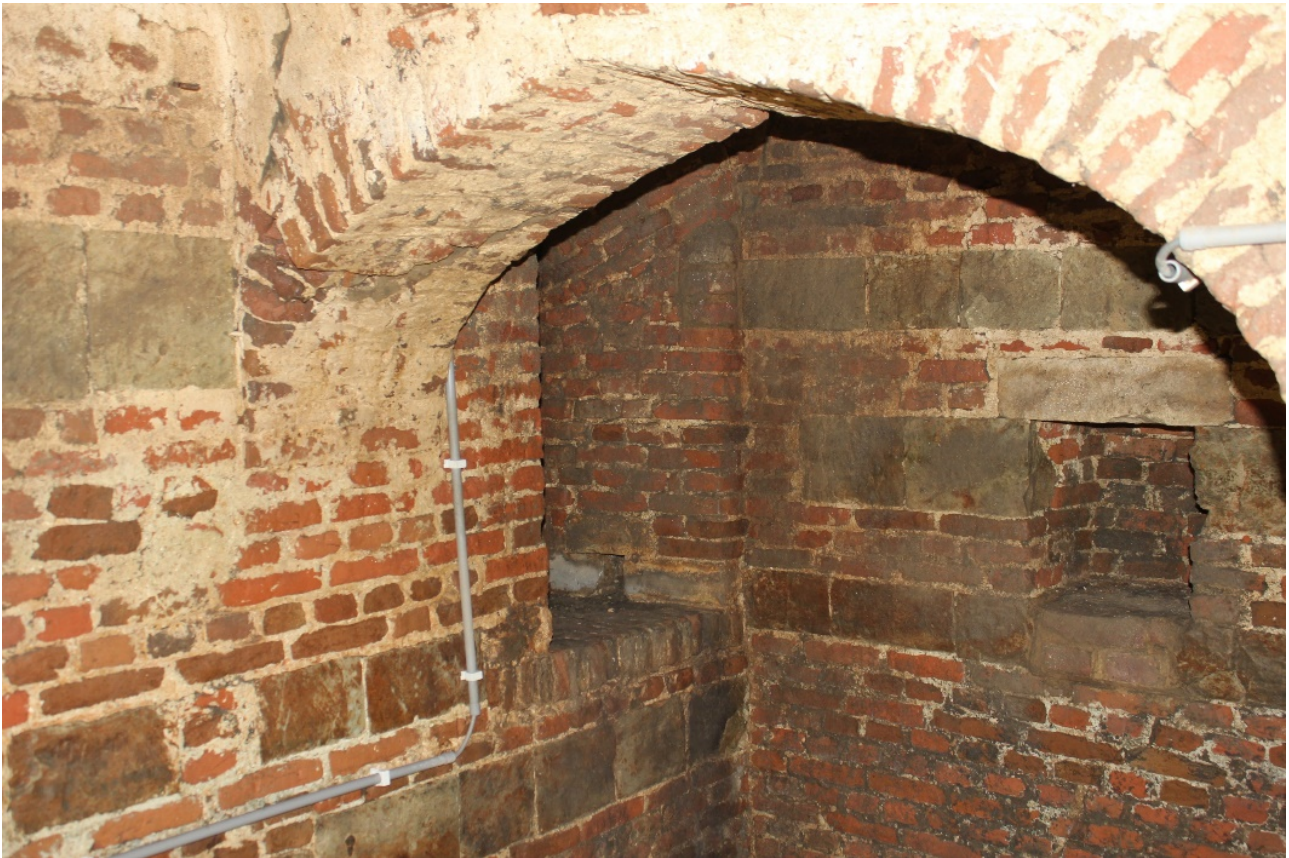
Foto 40: zuidwestelijke schietkamer van de benedenverdieping van het rondeel. met kanongat (links) en schietgat (rechts).
