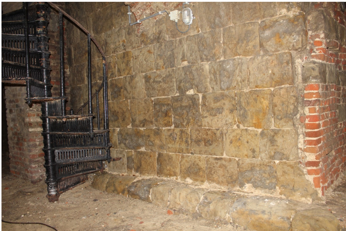
Foto 8: de grote zaal met de oostelijke wand van het poortgebouw, ter hoogte van de benedenverdieping en gezien vanuit het noorden. De onderste laag Lincenstufsteen markeert wellicht het begin van de fundering van het poortgebouw uit de 12de eeuw. Rechts is de bouwnaad zichtbaar tussen het metselwerk in Lincenstufsteen uit de 12de eeuw en het baksteenmetselwerk van het rondeel uit het begin van de 16de eeuw.
