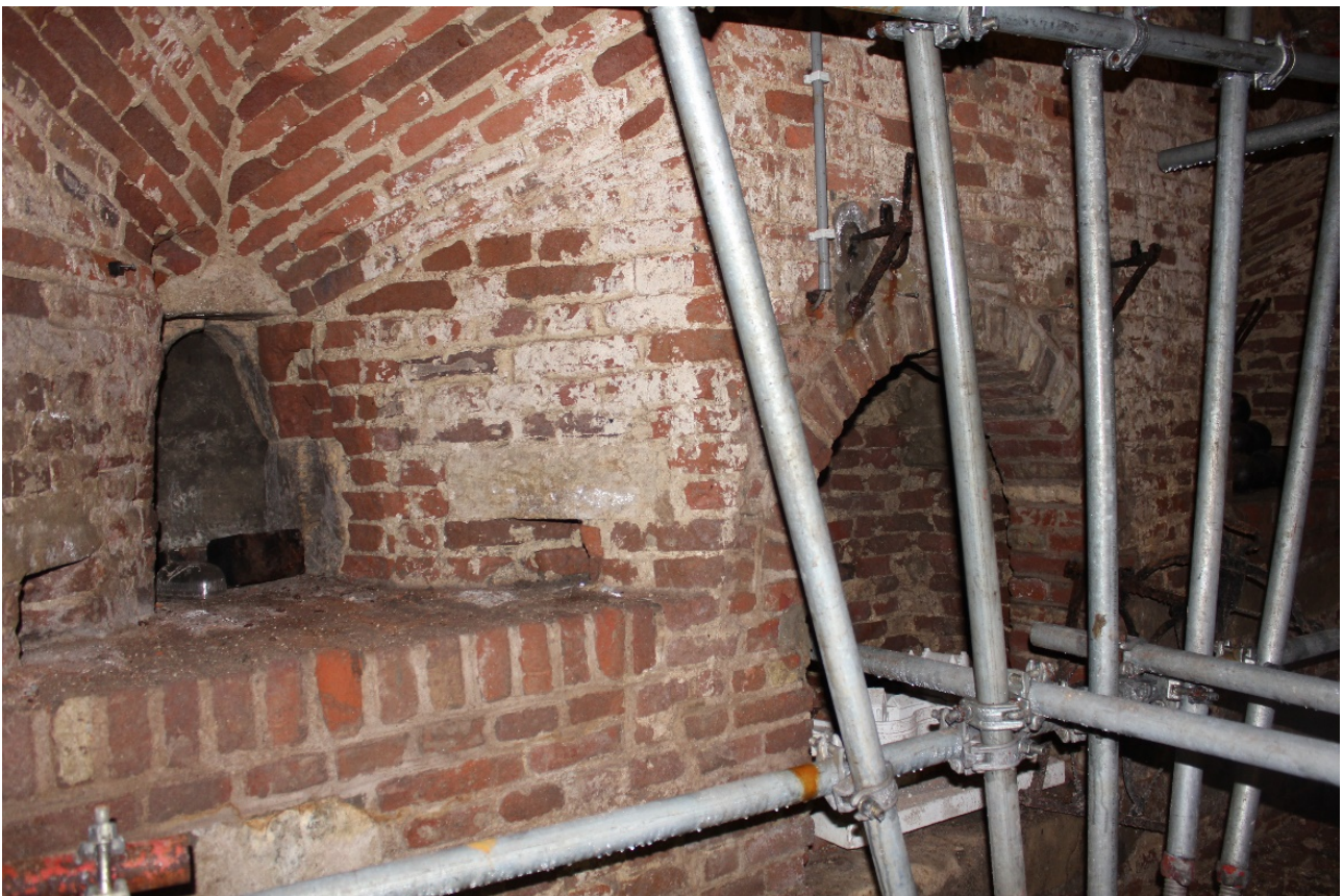
Foto 19: zuidelijke wand van de grote zaal ter hoogte van de bovenverdieping van het rondel, met kanongat en rookkanaal.
