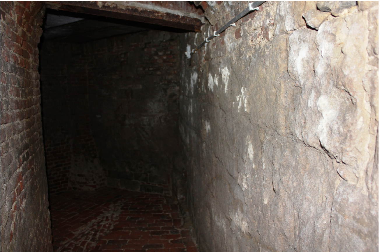
Foto 12: gang naar de noordoostelijke schietkamer van de bovenverdieping van het rondeel. Aan de linkerzijde muur in baksteen, aan de rechterzijde in Lincen tufsteen.
