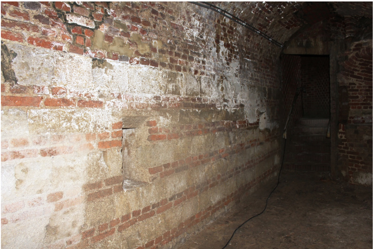
Foto 15: noordoostelijke muur van de zuidoostelijke schietkamer van de bovenverdieping van het rondeel. Speklagen in Lincence tufsteen en baksteen, en twee schietgaten.
