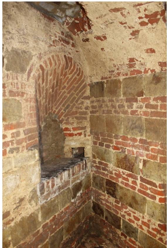
Foto 27 (links): eerste noordoostelijke schietkamer van de benedenverdieping van het rondel, met bewaarde bakstenen vloer.
