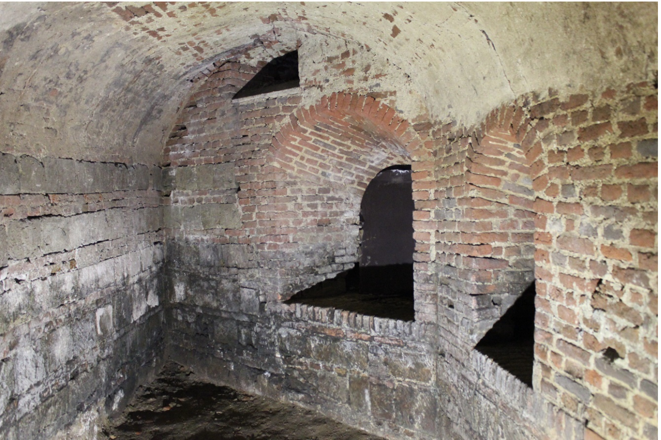
Foto 34: twee kanongaten en een rookkanaal in het zuidelijke uiteinde van de zuidoostelijke schietkamer van de benedenverdieping van het ronddeel.
