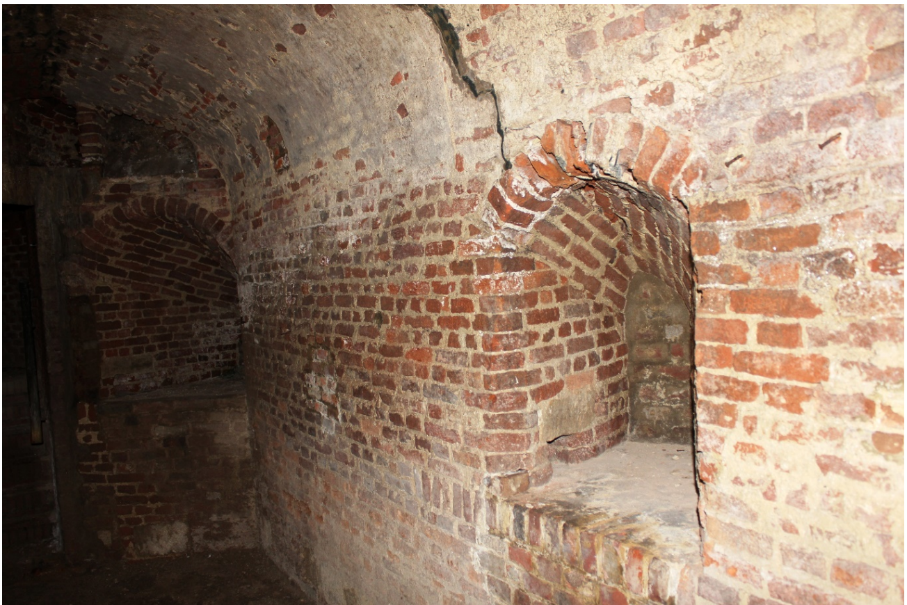
Foto 17: de zuidoostelijke schietkamer van de bovenverdieping van het rondeel, met kanongat in de zuidwestelijke muur.
