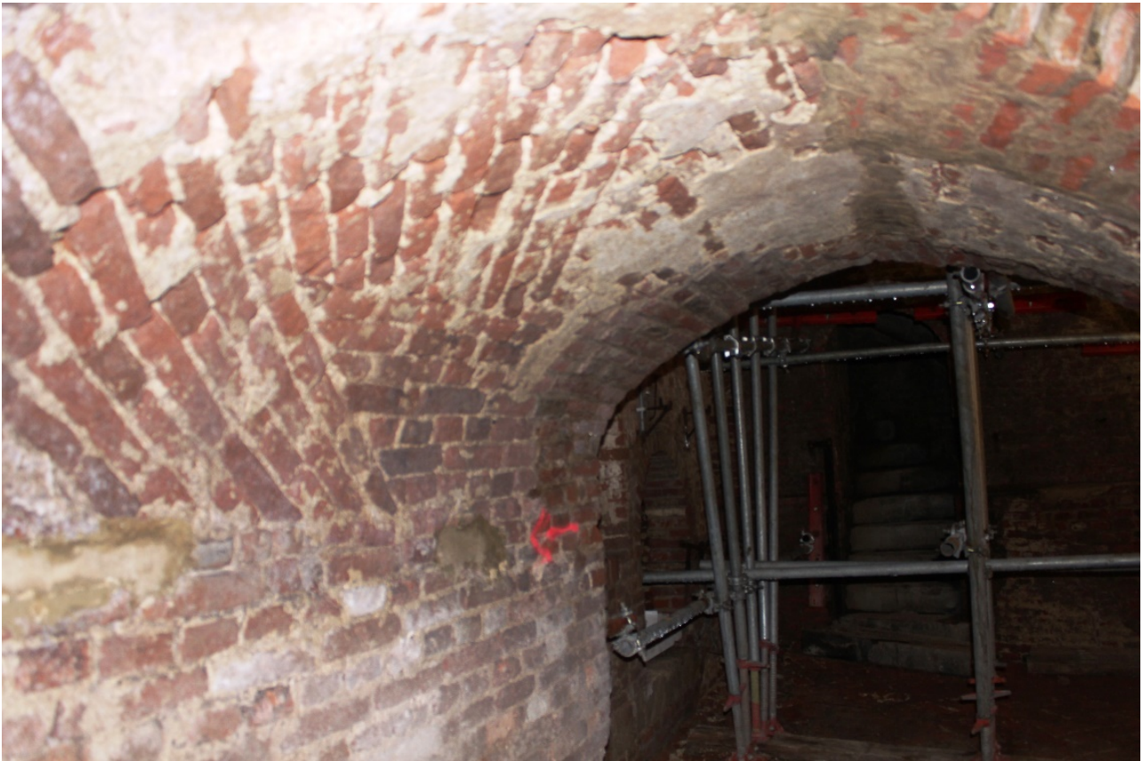
Foto 18: overwelfde gang van de zuidoostelijke schietkamer naar de grote zaal, ter hoogte van de bovenverdieping van het rondel.
