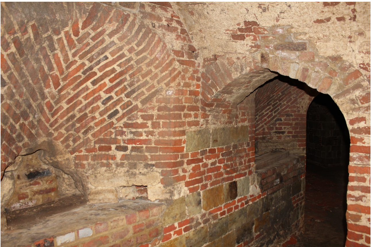
Foto 24 : kanongaten in de noordelijke gang van de benedenverdieping van het rondeel, langs de grote zaal en gezien naar het oosten.
