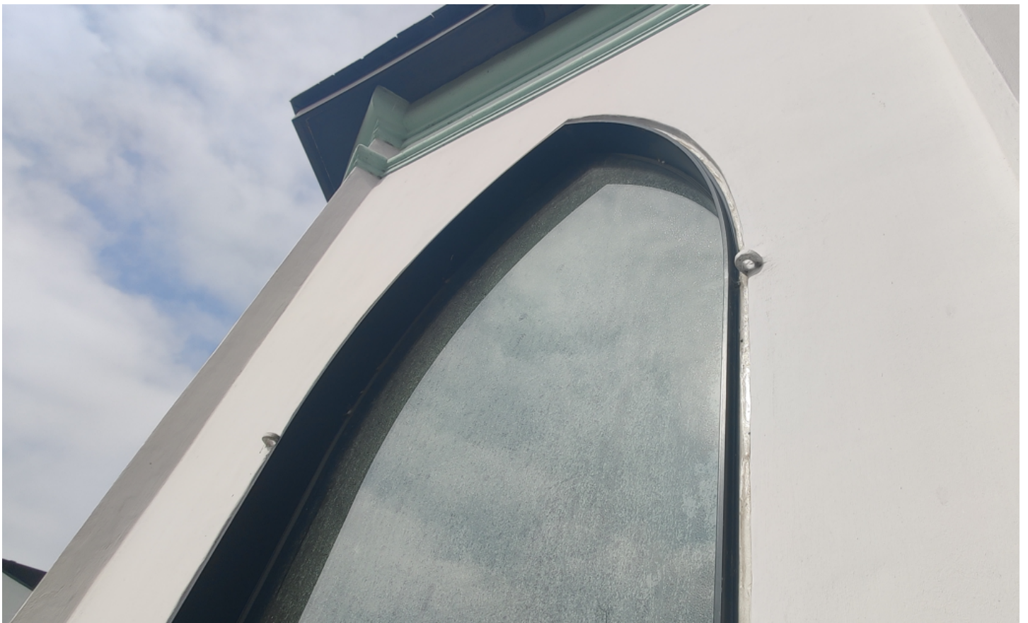
Foto 6: tuinpaviljoen: detail van bepleisterde buitengevel: venster met stalen schrijnwerk en nieuwe beglazing.
