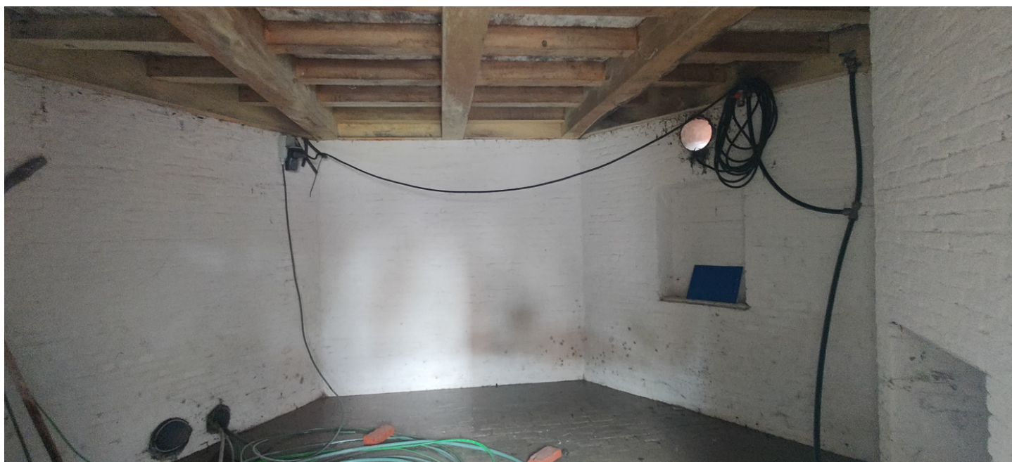
Foto 17: kelder met bakstenen wanden en dito vloer, haardelement en nis.
