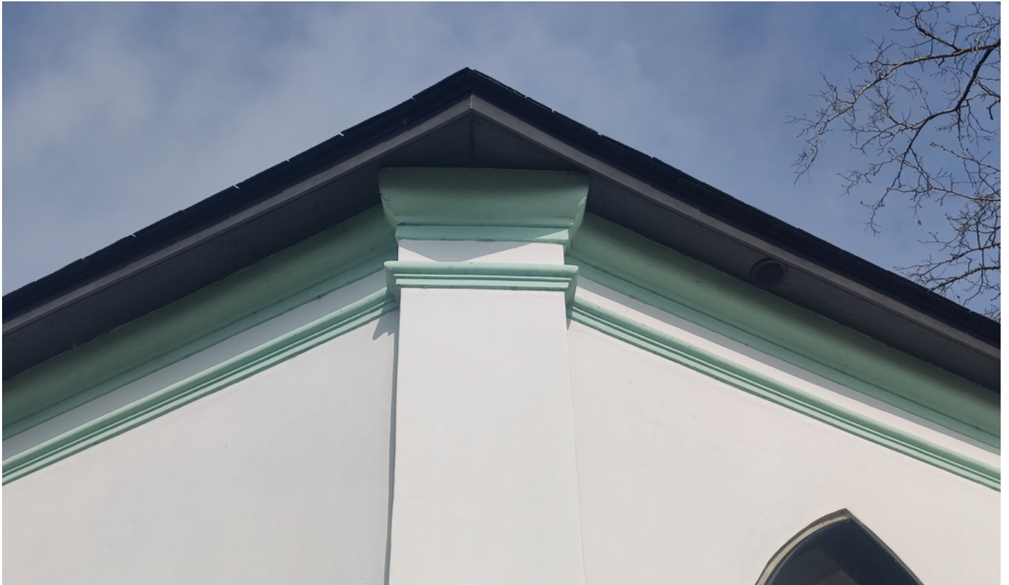
Foto 5: tuinpaviljoen: detail van bepleisterde buitengevel met pilastermotief en lijstwerk.
