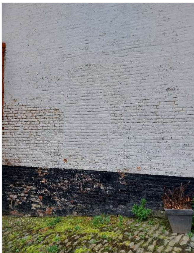
Foto 76: Langsschuur – bewaarde erfgevel met gedichte deur/poort.
