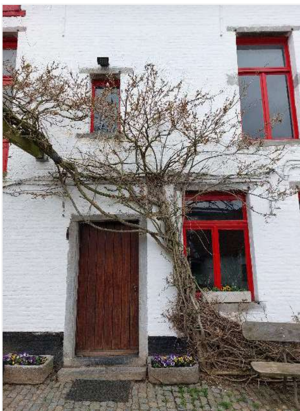
Foto 51: 18de-eeuws boerenburgerhuis – erfdeur gevat in hardstenen omlijsting – rechthoekige vensters met hardstenen dorpels en negblokken – blauwereggen.
