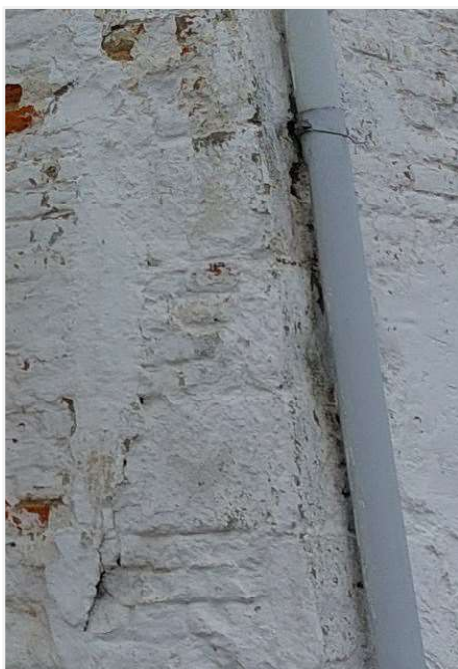
Foto 29: Oostelijke zijpuntgevel van 17de-eeuws boerenhuis met hoekketting van bak- en natuursteen.
