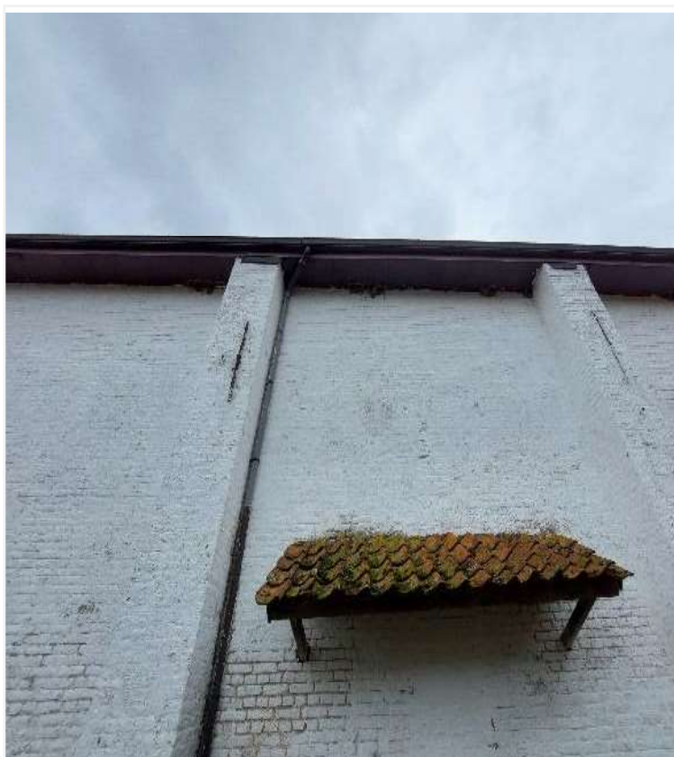
Foto 75: Langsschuur - bewaarde erfgevel van 1793 met verankerde zware lisenen (detail).
