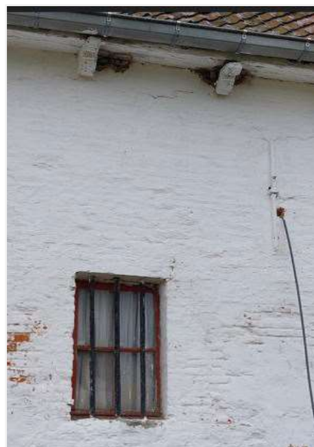
Foto 31: Detail dakoverstek waarvan houten dakvoet op fraai geprofileerde consolenrij of klosjes - anker met krul.
