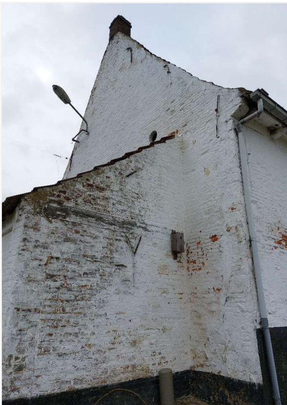
Foto 27: Zijpuntgevel van 17de-eeuws boerenhuis met lagere aanbouw onder lessenaarsdak met bakoven.
