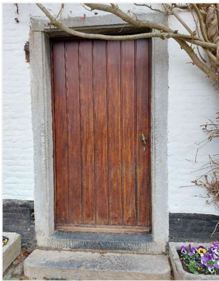
Foto 53: 18de-eeuws boerenburgerhuis – erfdeur gevat in hardstenen omlijsting aan afgerond hardstenen bordes.
