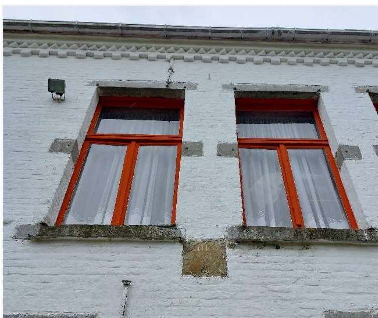
Foto 20: Bovenverdieping deurtravee met datumsteen tussen twee gekoppelde bovenvensters met blauw hardstenen onder- en bovendorpel en hoekblokken – luikog en bovenaan aflijnende baksteenfries.
