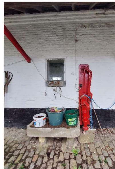
Foto 69: Stalvleugel gedateerd 1805 – pomp naar verluidt naar waterput - aflijnende getrapte baksteenlijst
