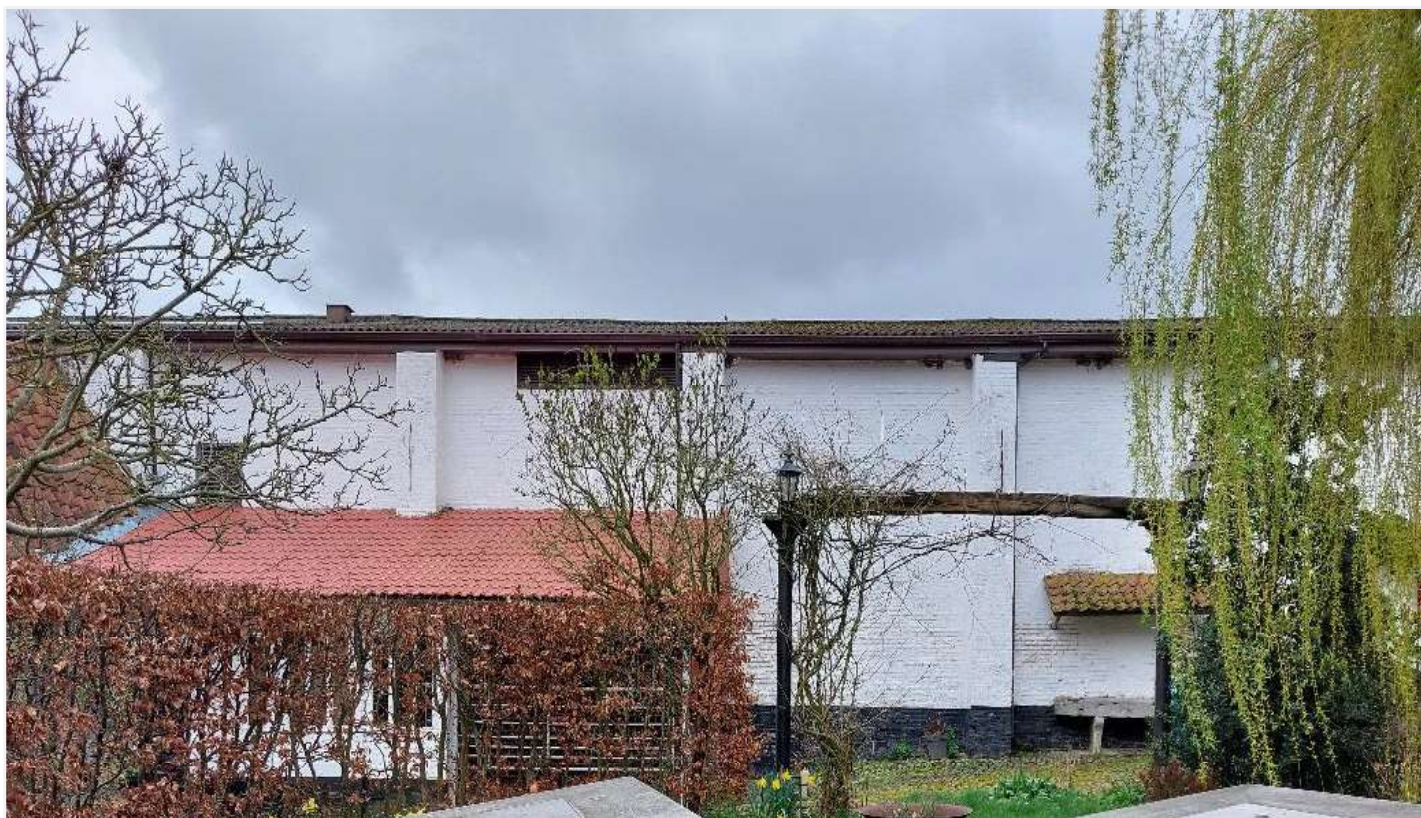
Foto 74: Langsschuur ten zuiden van erf – bewaarde erfgevel van schuur van 1793 met verankerde lisenen.
