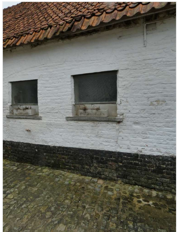
Foto 82: Vroegere remise met gedichte bogen – gevelanker.
