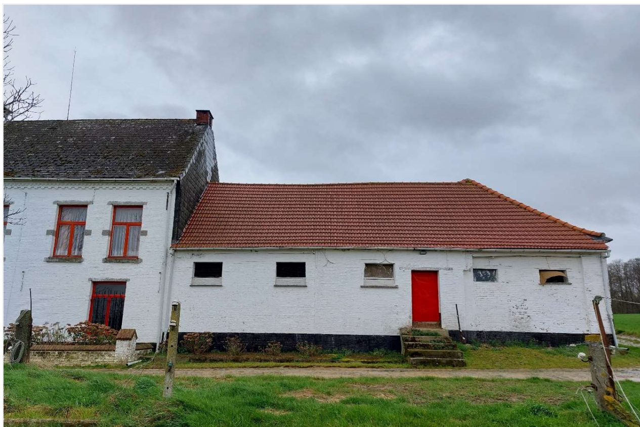
Foto 15: Bouwvolume is samenstel van gedichte stal van de heer (links) en haakse stalvleugel van 1805 (rechts) onder snijdende zadeldaken.
