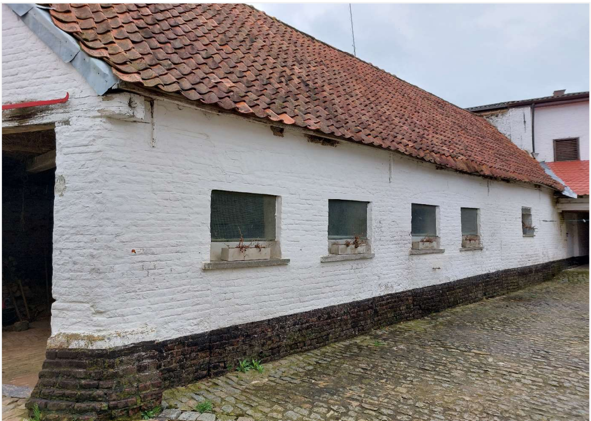
Foto 80: Vroegere remise onder afgewolfd zadeldak (ten oosten) – rechthoekige vensters geplaatst bij de omvorming van de remise tot stal in de 2de helft van de 20ste eeuw – thans terug gebruikt als remise - uitwaaiierende getrapte gevelhoek als versterking van de muur die ook fungeerde als schampconstructie om schade ten gevolge van aanrijdingen te vermijden..
