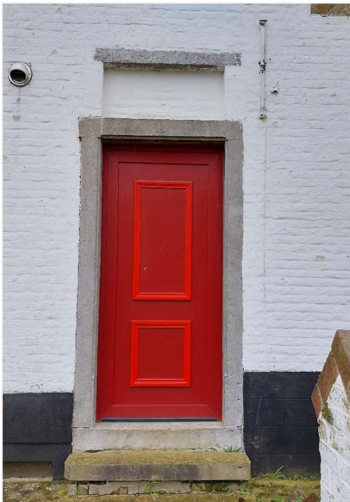
Foto 18: Voormalige inkom, gevat in blauw hardstenen omlijsting aan bordes van een trede en met blind bovenlicht.
