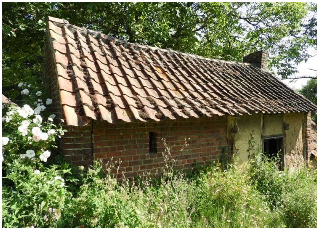
Foto 44: Zicht op de zuidelijke langsgevel van het bakhuis en het ten westen aansluitende stalletje onder doorgetrokken zadeldak. De roodbakstenen muur van het stalletje is hier enkel opengewerkt door een asemgat. Rechts sluit de zuidelijke vakwerkwand van het bakhuis aan (14 juni 2023)
