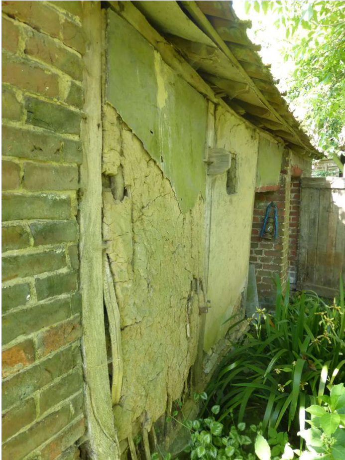
Foto 41: Zicht op de naar de woning gerichte noordgevel van het bakhuis. Stijl- en regelwerk met leemvullingen. De houten balk- of muurankers in de stijlen geven in het exterieur aan waar de ankerbalken zich in het interieur bevinden. Deze gevel van het bakhuis is opengewerkt door een deur en een kijkgat (14 juni 2023)
