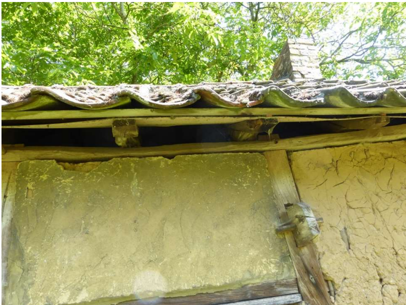
Foto 47: Zuidelijke langsgevel van het bakhuis. Stijl- en regelwerk met leemvullingen. Detail van houten balk- of muurankers in de stijl rechts van het venster (14 juni 2023)
