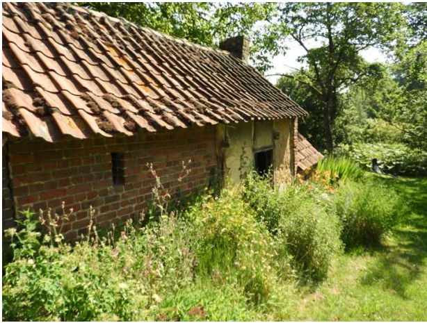
Foto 43: Zicht op de zuidelijke langsgevel van het bakhuis en het ten westen aansluitende stalletje onder doorgetrokken zadeldak. De roodbakstenen muur van het stalletje is hier enkel opengewerkt door een asemgat. Rechts sluit de zuidelijke vakwerkwand van het bakhuis aan. Daarachter zicht op het bakovengebouwtje onder lager zadeldak (14 juni 2023)
