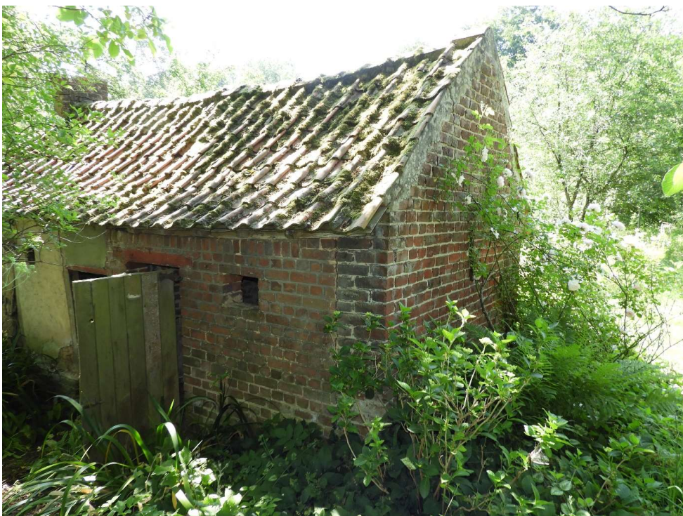
Foto 42: Zicht op de noordgevel (met houten deur en stalvenster) en de blinde zijgevel van het varkensstalletje. Dit stalletje steekt onder een doorgetrokken zadeldak. De recentere bakstenen langsgevels van dit stalletje vervangen vermoedelijk vroegere vakwerkwanden. Naast de rode mechanische baksteen wijzen daar ook de kopse afboording en de verticale, niet-gehechte bouwnaad met de smalle zijkanten van de zijgevel op. De zijgevel in donkerrode, handgevormde baksteen behoort tot de oorspronkelijke constructie (14 juni 2023)
