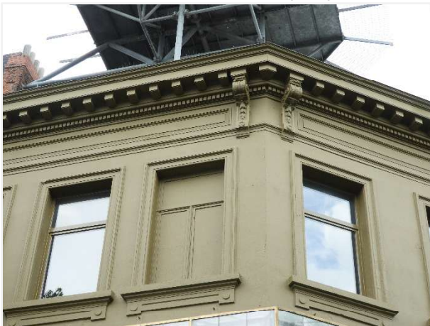
Foto 3: Tweede verdieping eind-19de-eeuwse gevelafwerking (Biekorfstraat).
