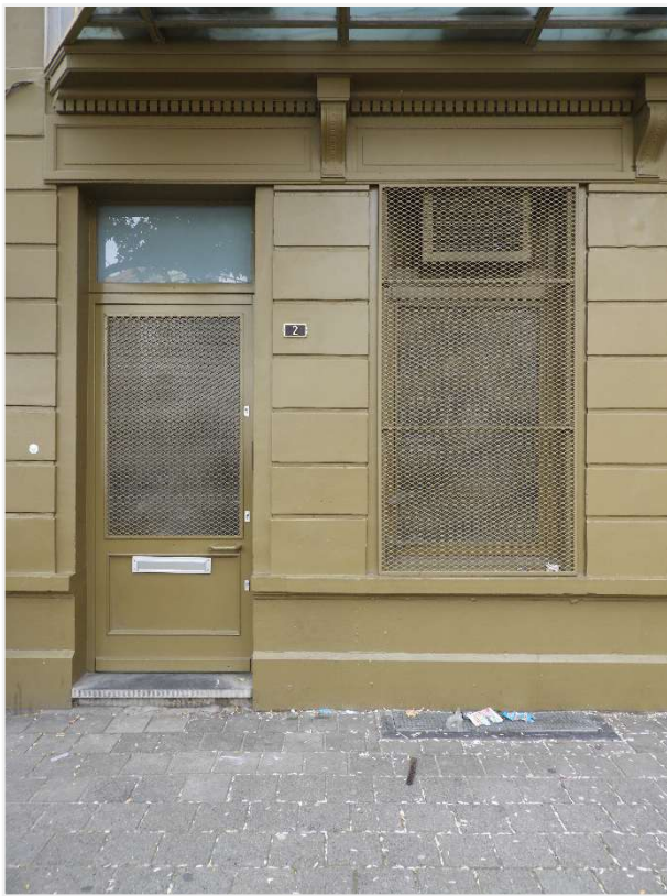
Foto 8: Begane grond, met verplaatste voordeur (Biekorfstraat).
