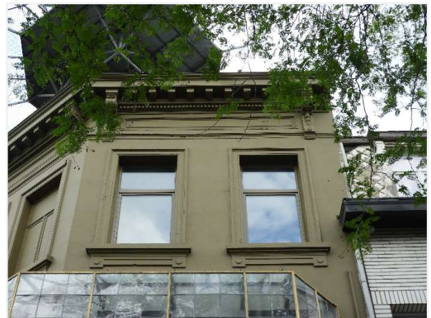
Foto 4: Tweede verdieping eind-19de-eeuwse gevelafwerking (Trapstraat).
