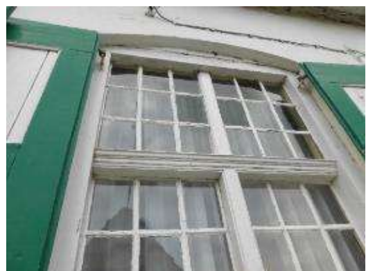
Foto 17: de voordeur met bovenlicht van het hooghuis is gevat in een houten, geprofileerd kozijn. Boven het geprofileerde kalf steekt het tweeledige bovenlicht met kleine roedeverdeling (2 vakken in de breedte, 3 in de hoogte) en diefijzers (plaatsbezoek Onroerend Erfgoed 23.06.2023).
