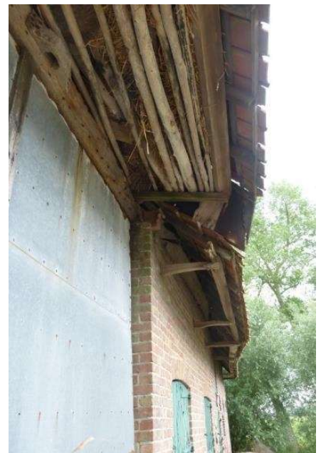
Foto's 46-47: de hoge schuurpoort onder een hogere dakoverstek, geflankeerd door telkens drie houten, tweeledige staldeuren. De zijkant van de hogere dakoverstek (poort) bewaart een plankenbeschieting. Dakoverstek op houten klossen. De schuurpoort heeft een klein deurtje of klinket. Rechts: detail houten sluitsysteem van de poort en dakoverstek op houten klossen (plaatsbezoek Onroerend Erfgoed 23.06.2023).
