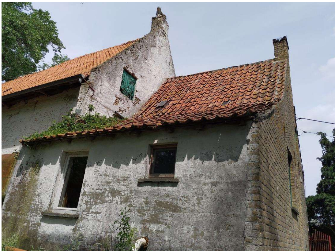
Foto 29: het gebouwtje onder lessenaarsdak, aangebouwd tegen de achtergevel van het laaghuis, werd rond 1980 vernieuwd. Boven het keukendak, de oorspronkelijke zuidelijke zijgevel van het hooghuis met aandak en vlechtingen, en houten laadluik (plaatsbezoek Onroerend Erfgoed 23.06.2023).
