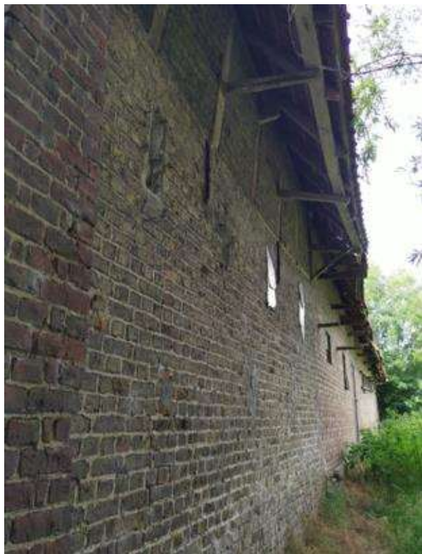
Foto 53: de linker (zuidelijke) traveeën van de achtergevel zijn gemetseld in recentere, gele baksteen en opengewerkt met asemgaten. Onder de dakoverstek is stijl- en regelwerk (vakwerk) met invulling van baksteen bewaard. De klossen van de dakoverstek sluiten aan op de stijlen (plaatsbezoek Onroerend Erfgoed 23.06.2023).
