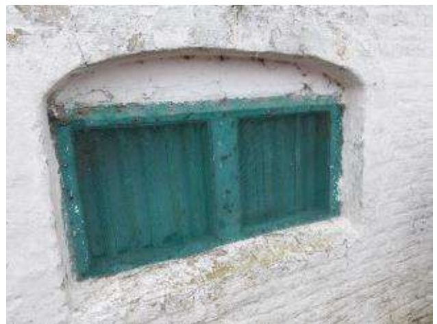
Foto 24: het rechthoekige keldervenster in de naar het neerhof gerichte gevel (hooghuis) is gevat in een steekboognis. Groengeschilderd enkel kozijnvenster met diefijzers en binnenluiken (plaatsbezoek Onroerend Erfgoed 17.01.2024).
