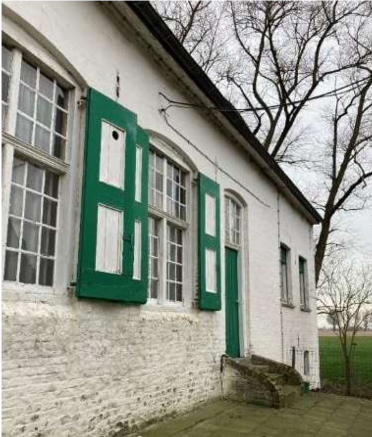
Foto 15: groen- en witgeschilderd houtwerk in de naar het neerhof gerichte gevel (hooghuis). Links van de deur zijn de rechthoekige vensters gevat in steekboognissen. De houten kruiskozijnen met kleine roedeverdeling en luiken gaan terug op de 18de eeuw. Boven de verlaagde opkamervensters zijn sporen van steekbogen bewaard (plaatsbezoek Onroerend Erfgoed 17.01.2024).
