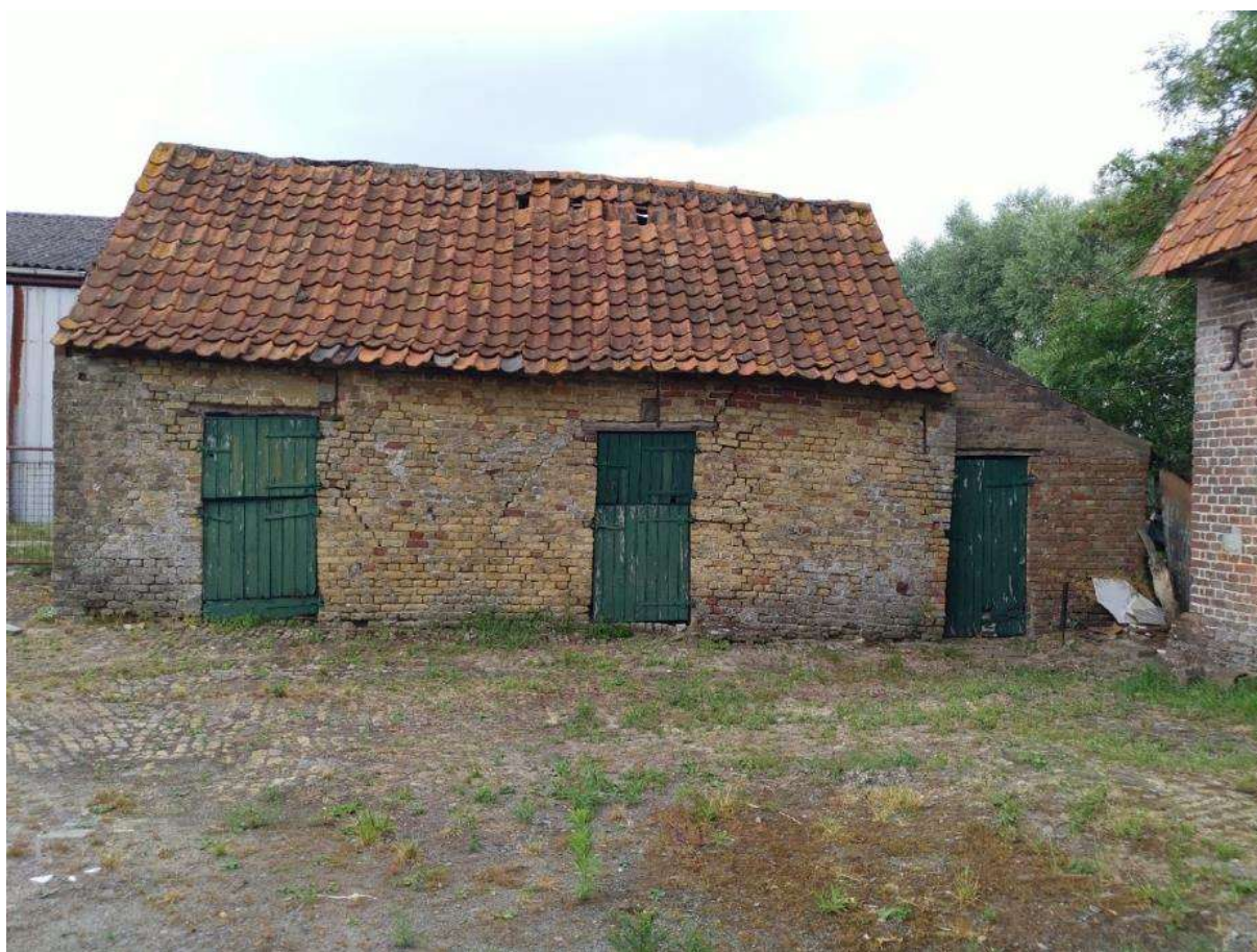
Foto 63: de jaarlingenstal op het neerhof heeft twee houten, tweeledige staldeuren onder houten latei. Rechts is een stalletje onder lessenaarsdak aangebouwd. Erfverharding van bakstenen op hun kant, onder meer voor weggetjes over het neerhof (deels met aarde overdekt) (plaatsbezoek Onroerend Erfgoed 23.06.2023).
