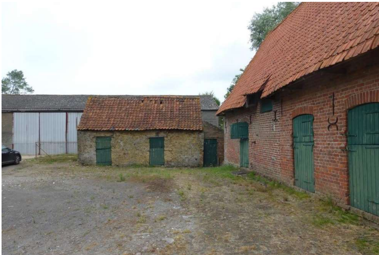
Foto 62: de jaarlingenstal op het neerhof is haaks op de dwarsschuur ingeplant. Overwegend gele baksteenbouw. Het zadeldak is gedekt met rode Vlaamse pannen (plaatsbezoek Onroerend Erfgoed 23.06.2023).
