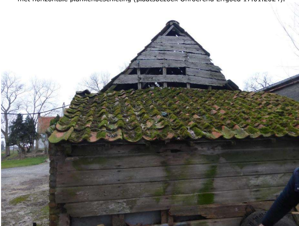
Foto 65: de oostelijke zijgevel van de jaarlingenstal op het neerhof bewaart in het gevelveld stijl- en regelwerk met horizontale plankenbeschiëting. Ook het aangebouwd stalletje onder lessenaarsdak (rode Vlaamse pannen) heeft een zijgevel in stijl- en regelwerk met plankenbeschiëting (plaatsbezoek Onroerend Erfgoed 17.01.2024).
