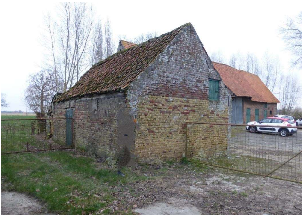
Foto 67: achtergevel en zijgevel van de jaarlingenstal op het neerhof. In de westelijke zijgevel valt het kleurverschil van de baksteen op: beneden oude gele baksteen - gevelveld in rode baksteen met houten luikje (kozijnconstructie). De rode baksteen vervangt mogelijk stijl- en regelwerk met plankenbeschieting zoals bewaard bij de oostelijke zijgevel (plaatsbezoek Onroerend Erfgoed 17.01.2024).
