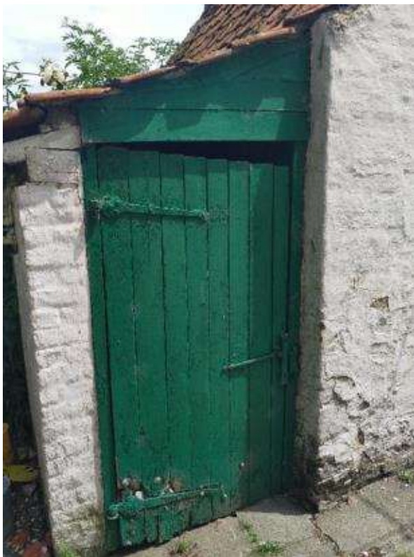
Foto 39: tegen het bakhuis leunt het buitentoilet onder lessenaarsdak aan. Groengeschilderde houten deur met smeedijzeren hang- en sluitwerk . Boven de deur, houten, horizontale beplanking (plaatsbezoek Onroerend Erfgoed 23.06.2023).
