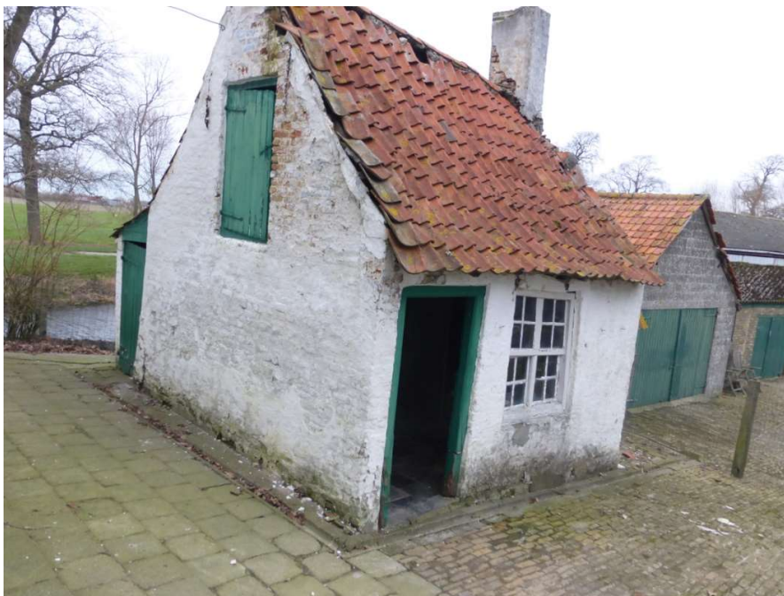
Foto 37: zijgevel van de werkruimte (bakhuis) met groengeschilderd houten laadvenster in het gevelveld (kozijnconstructie). Erfverharding van bakstenen op hun kant. Zicht op de walgracht (plaatsbezoek Onroerend Erfgoed 31.01.2024).
