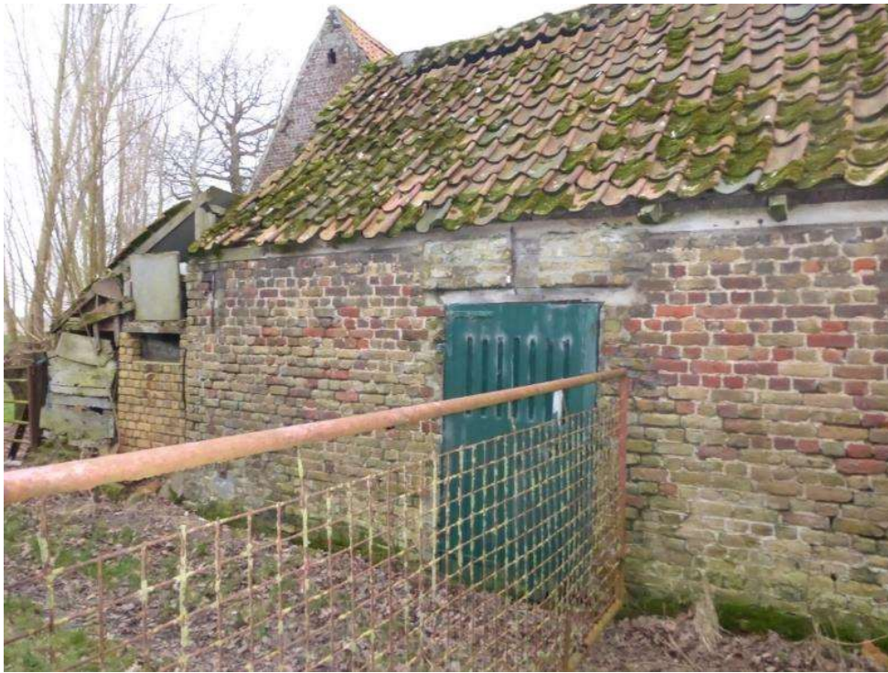
Foto 66: jaarlingenstal op het neerhof, achtergevel. Houten staldeur onder houten latei. Aangebouwd stalletje onder lessenaarsdak met deels bewaarde plankenbeschieting. Ook de roodbakstenen zijgevel van de schuur met uilengat komt in beeld (plaatsbezoek Onroerend Erfgoed 17.01.2024).
