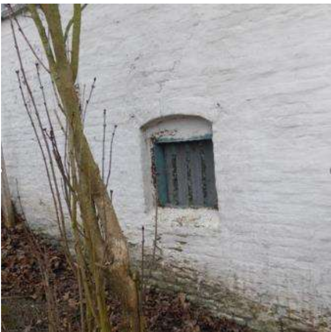
Foto 24: het rechthoekige keldervenster in de naar het neerhof gerichte gevel (hooghuis) is gevat in een steekboognis. Groengeschilderd enkel kozijnvenster met diefijzers en binnenluiken (plaatsbezoek Onroerend Erfgoed 17.01.2024).
