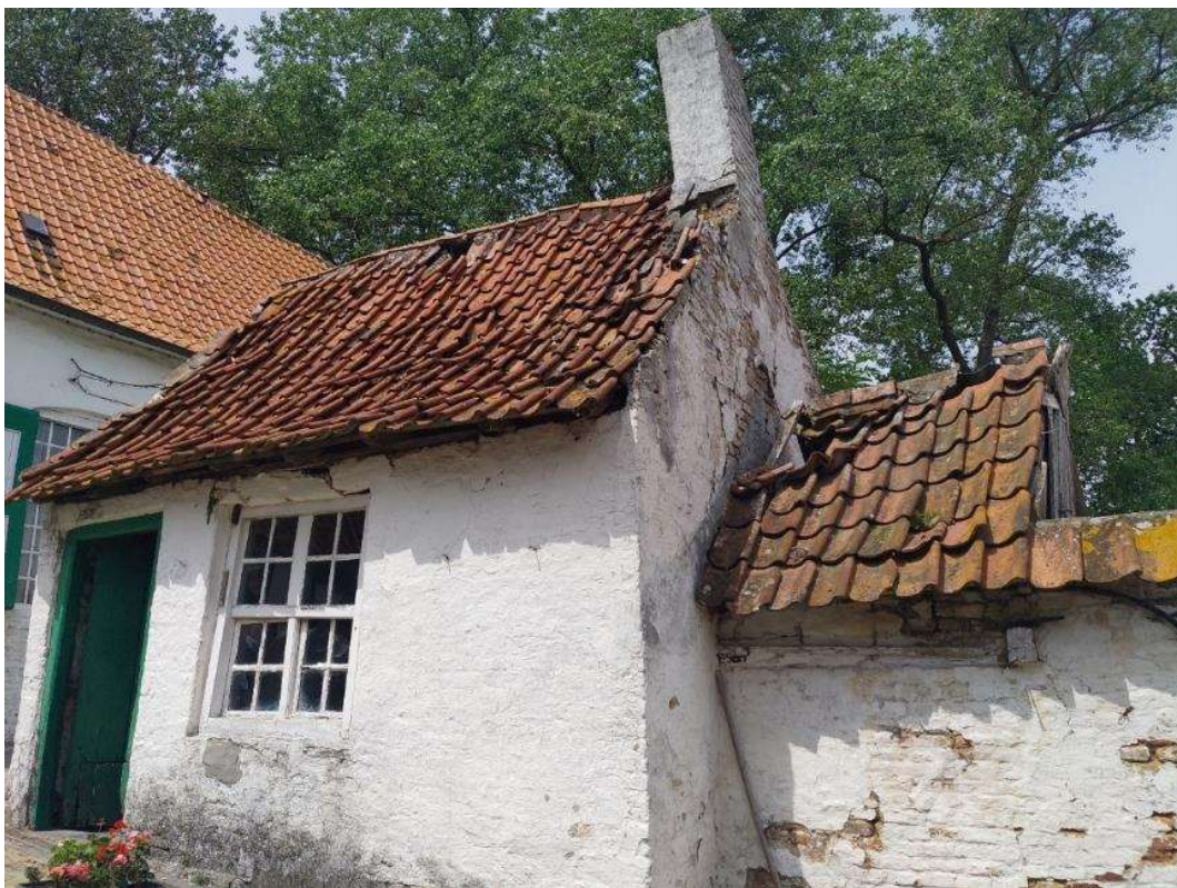
Foto 35: het bakhuis van het tweeledige type (zuidzijde) – links de hogere werkruimte – rechts het lagere bakovengebouwtje, op smallere plattegrond – zadeldaken met rode Vlaamse pannen (plaatsbezoek Onroerend Erfgoed 23.06.2023).
