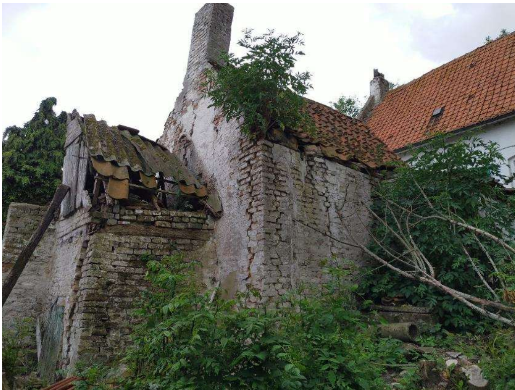
Foto 43: bakhuis van het tweeledige type (noordzijde) – links de hogere werkruimte – rechts het lagere bakovengebouwtje, op smallere plattegrond – zadeldaken met rode Vlaamse pannen (plaatsbezoek Onroerend Erfgoed 23.06.2023).
