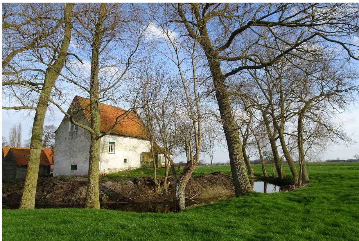
Foto 1: algemeen zicht op de omgrachte hoeve met huisweides (plaatsbezoek Onroerend Erfgoed 20.03.2024).
