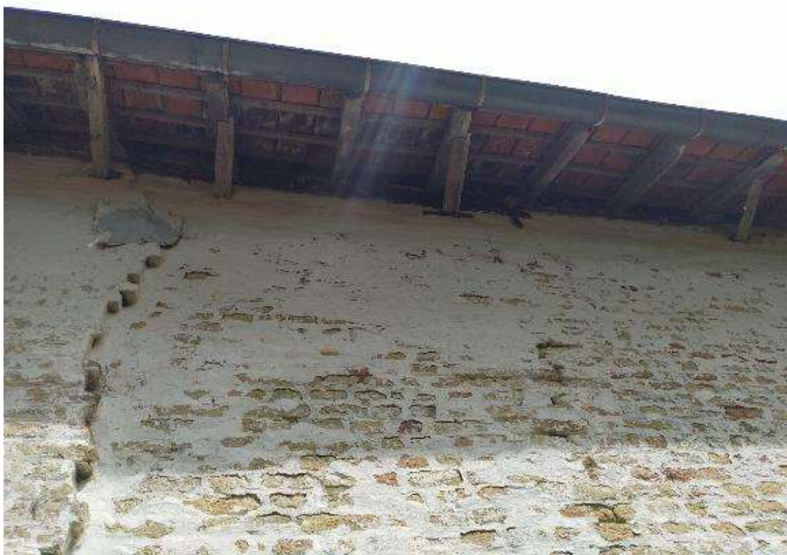
Foto 32: dakoverstek met houten klossen boven de gesloten achtergevel van het huis. Bouwspoor (plaatsbezoek Onroerend Erfgoed 23.06.2023).
