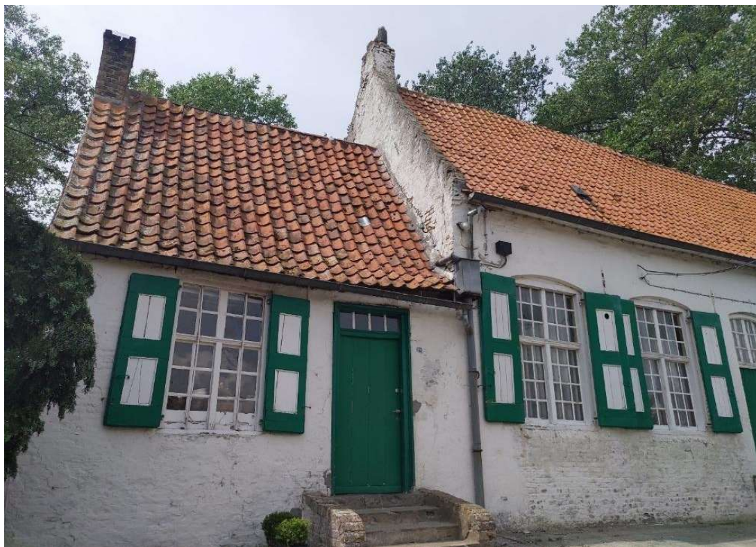
Foto 14: het witgeschilderd kruiskozijn met diefijzers en kleine roedeverdeling in de oostgevel van het laaghuis is voorzien van luiken. De deur met bovenlicht is gevat in een houten omlijsting (deurdorpel in kalksteen). De linker zijgevel van het hooghuis is afgewerkt met een aandak met vlechtingen en voorzien van een schoorsteen. Het zadeldak van het laaghuis is gedekt met rode Vlaamse pannen, dat van het hooghuis met recentere mechanische pannen (plaatsbezoek Onroerend Erfgoed 23.06.2023).
