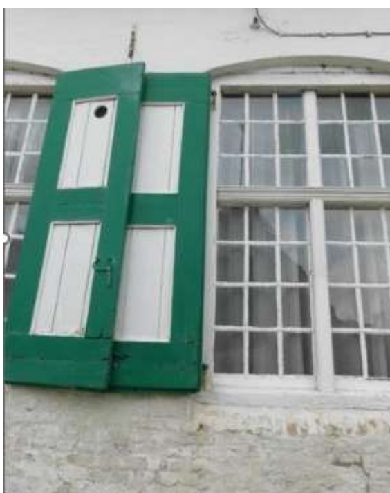
Foto 20: bij de kruisvensters van het hooghuis zijn zowel de benedenvakken (3 vakken in de breedte, 4 in de hoogte) met schuifvensters als de bovenlichten voorzien van kleine roedeverdelingen (3 x 3 vakken). De hoge opgeklampte luiken zijn groen- en witgeschilderd (plaatsbezoek Onroerend Erfgoed 23.06.2023).
