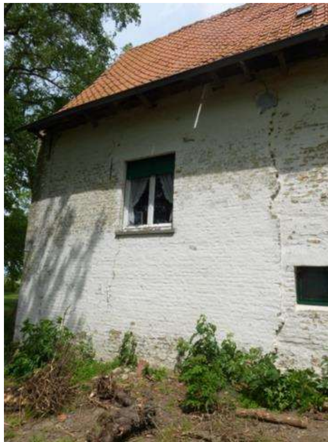
Foto 31: de gesloten achtergevel van het huis – gekarteld bouwspoor tussen opkamer en lager huisgedeelte. Het rechthoekige venster onder betonnen latei (zonder erfgoedwaarde) in de opkamer is recenter ingebracht (plaatsbezoek Onroerend Erfgoed 23.06.2023).
