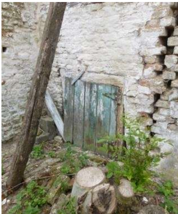
Foto 41: het lagere bakovengebouwtje waarin de oven ingebouwd is. Onderaan geeft een houten luikje toegang tot een droogruimte voor houtbussels: houten luik met smeedijzeren hang- en sluitwerk (kozijnconstructie) opslagruimte (plaatsbezoek Onroerend Erfgoed 23.06.2023).
