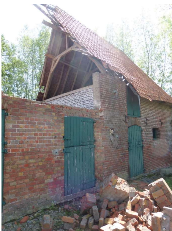
Foto 60: de dwarsschuur na de gedeeltelijke instorting van 3 april 2024. Vooral het middendeel ter hoogte van des schuurdoorrit liep veel schade op (plaatsbezoek Onroerend Erfgoed 17.05.2024). Foto 61: de dwarsschuur na de gedeeltelijke instorting van 3 april 2024. De traveeën met het oudste metselwerk, ook de zijgevels, blven bewaard (plaatsbezoek Onroerend Erfgoed 17.05.2024).
