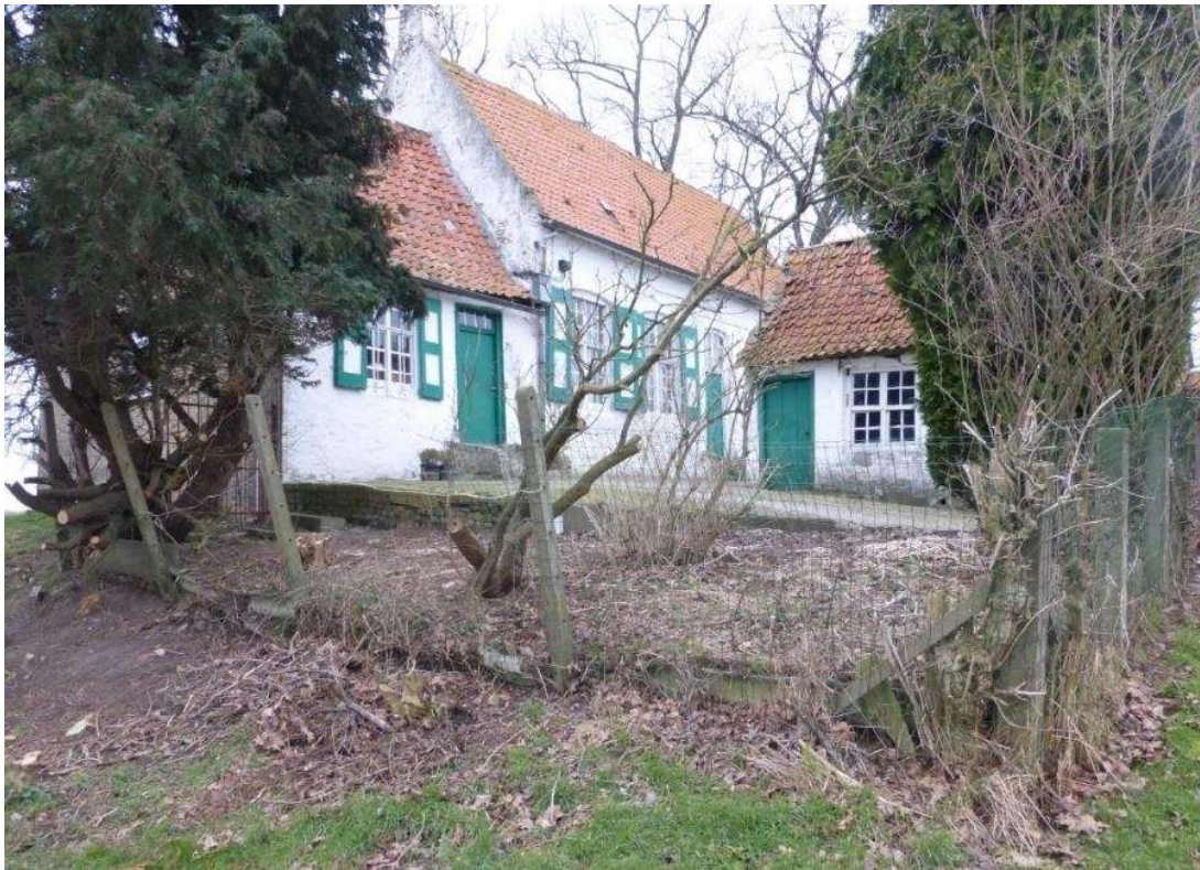
Foto 13: bij het hooghuis op het opgehoogde opperhof leunt links het laaghuis met keuken aan. De helling van het opperhof wordt geaccentueerd door het bakhuis. De deur van het bakhuis is naar het keukengebouw gericht (plaatsbezoek Onroerend Erfgoed 17.01.2024).
