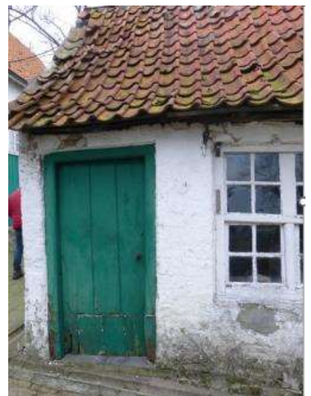
Foto 37: zijgevel van de werkruimte (bakhuis) met groengeschilderd houten laadvenster in het gevelveld (kozijnconstructie). Erfverharding van bakstenen op hun kant. Zicht op de walgracht (plaatsbezoek Onroerend Erfgoed 31.01.2024).
