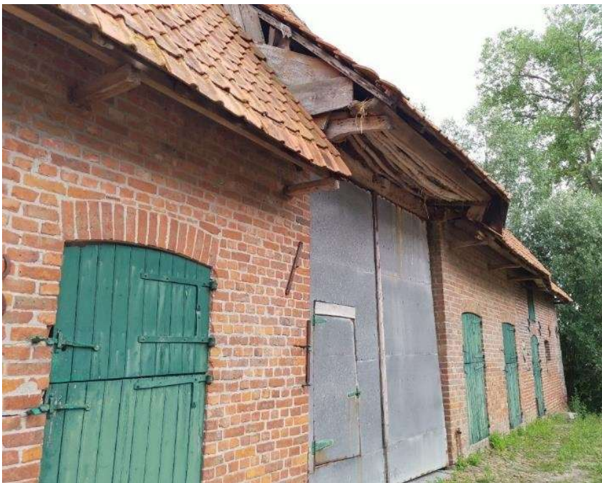
Foto's 46-47: de hoge schuurpoort onder een hogere dakoverstek, geflankeerd door telkens drie houten, tweeledige staldeuren. De zijkant van de hogere dakoverstek (poort) bewaart een plankenbeschieting. Dakoverstek op houten klossen. De schuurpoort heeft een klein deurtje of klinket. Rechts: detail houten sluitsysteem van de poort en dakoverstek op houten klossen (plaatsbezoek Onroerend Erfgoed 23.06.2023).
