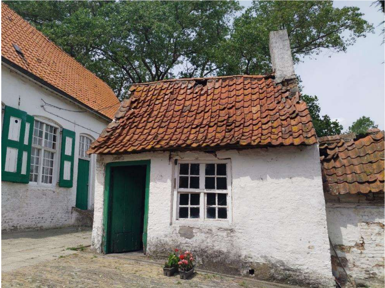
Foto 36: het bakhuis is dicht tegen de voorgevel van het huis gebouwd. De voet ervan geeft duidelijk de hellingsgraad van het opperhof aan – erfverharding van gele bakstenen op hun kant (plaatsbezoek Onroerend Erfgoed 23.06.2023).
