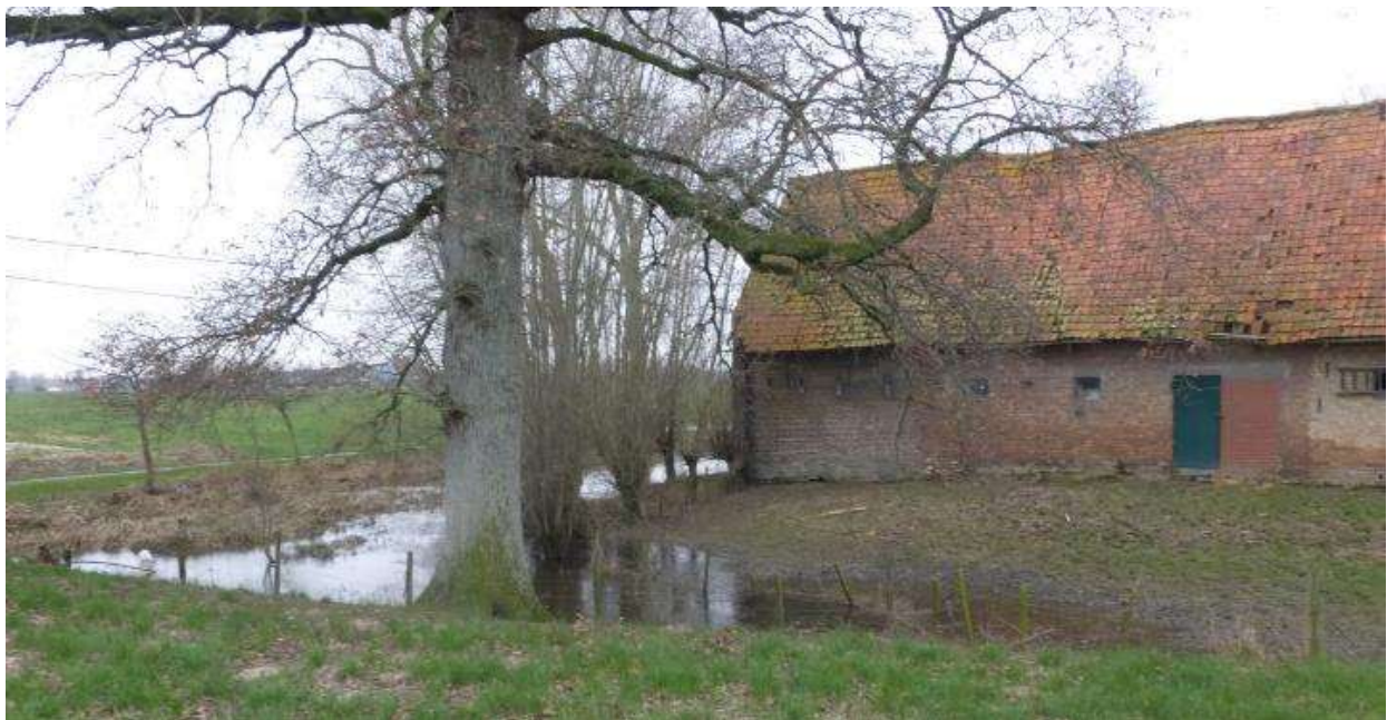
Foto 58: waarschijnlijk resulteren de langsgevels van de schuur, ook aan de achterzijde, uit de gefaseerde versterking van een vakwerkbouw, met diverse types metselwerk tot gevolg. Centraal geeft een deels dichtgemetselde muuropening nog de lage en smalle schuurpoort aan (plaatsbezoek Onroerend Erfgoed 17.01.2024).
