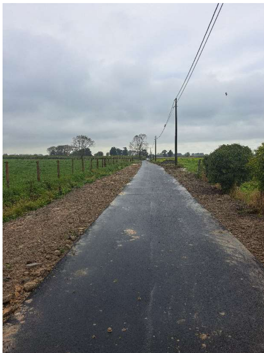
Foto 10: de lange erfoprit ter hoogte van de Izenbergestraat, na asfalteringswerken oktober 2024 (plaatsbezoek Onroerend Erfgoed 14.10.2024).
