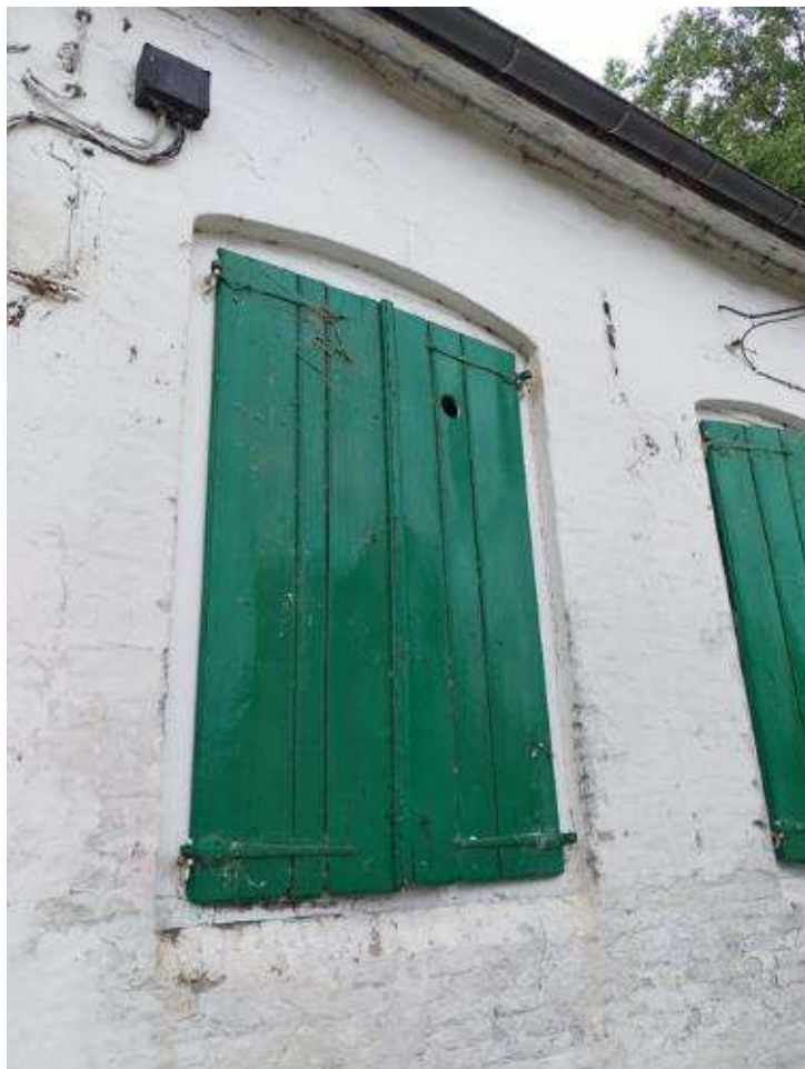
Foto 19: groengeschilderde, opgeklampte luiken met bewaard smeedijzeren hang- en sluitwerk in gesloten toestand (hooghuis). Kenmerkend voor kozijnconstructies steken de luikduimen in het houtwerk. In het rechter luik van het linker venster steekt bovenaan een rond spiongat (plaatsbezoek Onroerend Erfgoed 23.06.2023).
