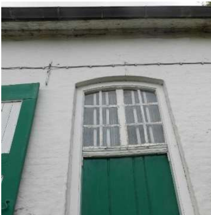
Foto 17: de voordeur met bovenlicht van het hooghuis is gevat in een houten, geprofileerd kozijn. Boven het geprofileerde kalf steekt het tweeledige bovenlicht met kleine roedeverdeling (2 vakken in de breedte, 3 in de hoogte) en diefijzers (plaatsbezoek Onroerend Erfgoed 23.06.2023).
