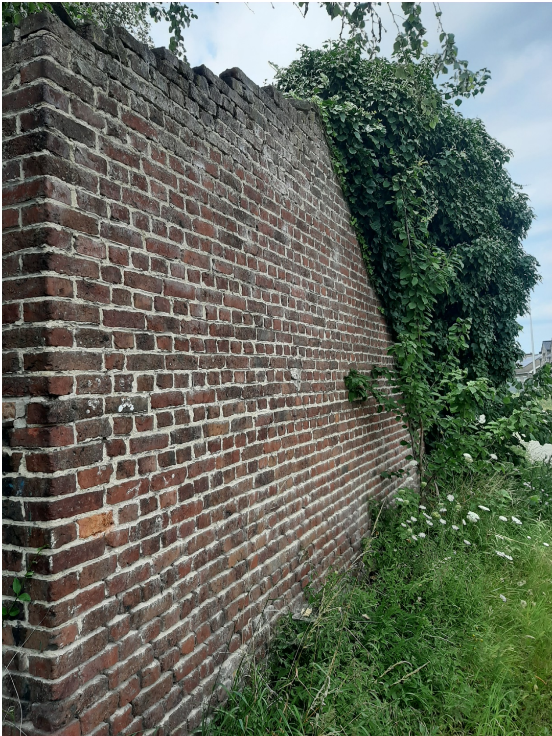
Foto 4: Detailfoto van de resterende gevel van het noordelijk volume van de vakwerkhoeve.
