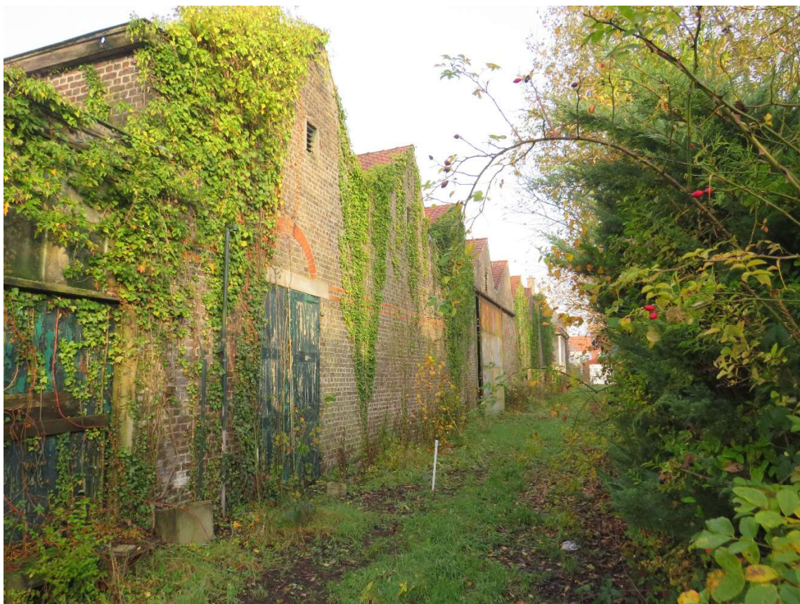
Foto 2 – Zicht vanuit het zuiden op de oostgevel van de ververij van de voormalige fabriek Textiles d'Eecloo © 2023 - Onroerend Erfgoed.
