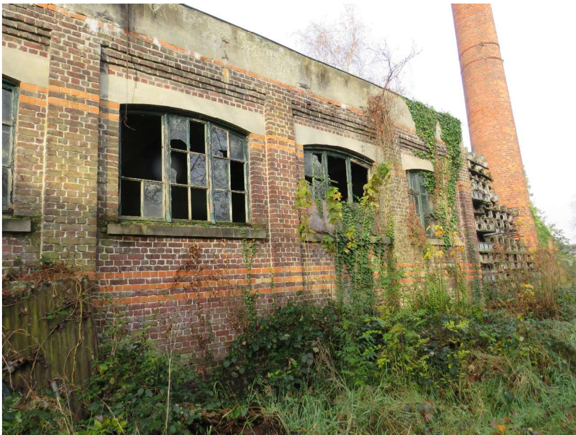
Foto 8 – Zicht vanuit het zuidoosten op de oostgevel van het ketelhuis en de fabriekschouw van de voormalige fabriek Textiles d’Eecloo © 2023 - Onroerend Erfgoed.
