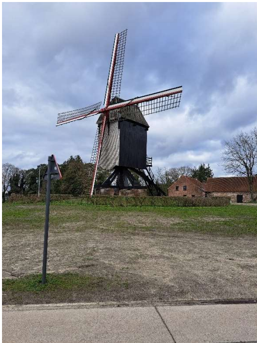
Foto 9: molen vanaf zuiden (Achiel Cleynhenslaan)
