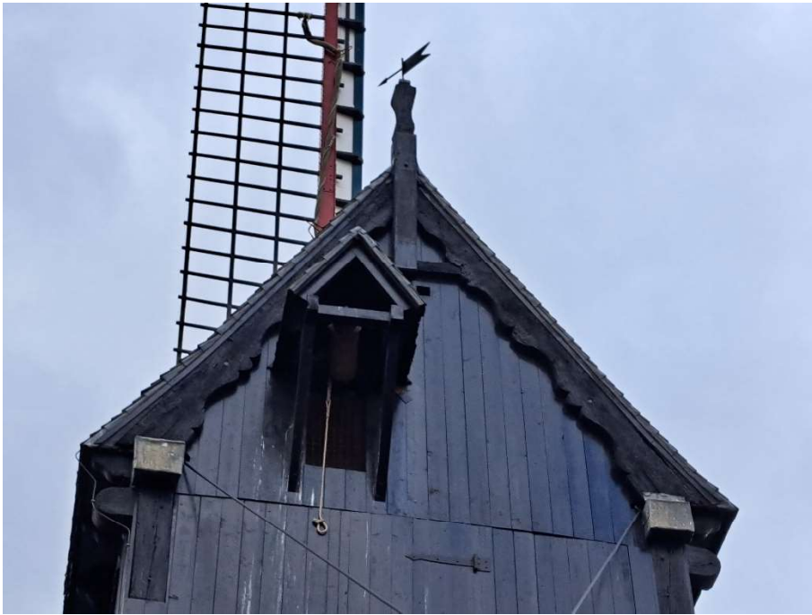
Foto 23-24: luikap ter hoogte van de kapzolder en daaronder korenluik in balkon
