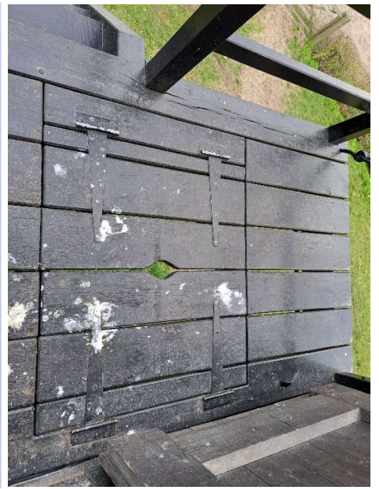
Foto 23-24: luikap ter hoogte van de kapzolder en daaronder korenluik in balkon
