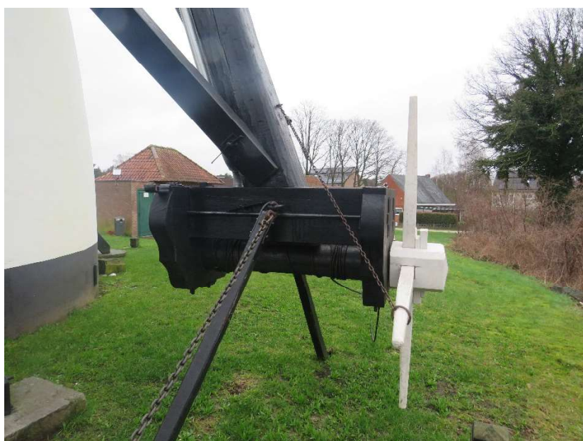
Foto 52 - Ezaartmolen. Uitwendig kruitwerk © 2024 Onroerend Erfgoed.
