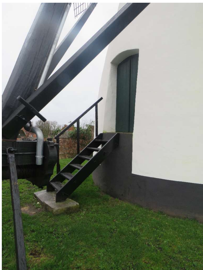
Foto 50 - Ezaartmolen. Oostelijke toegang tot meelzolder © 2024 Onroerend Erfgoed.
