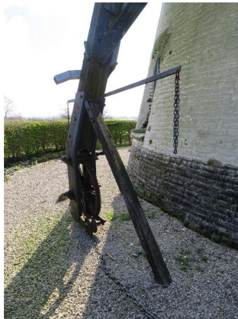
Foto 34 - Brouckmolen. Staart met uitwendig kruierwerk © 2024 Onroerend Erfgoed.
