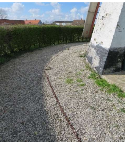
Foto 35 - Brouckmolen. Kruipalen met kruiketring © 2024 Onroerend Erfgoed.
