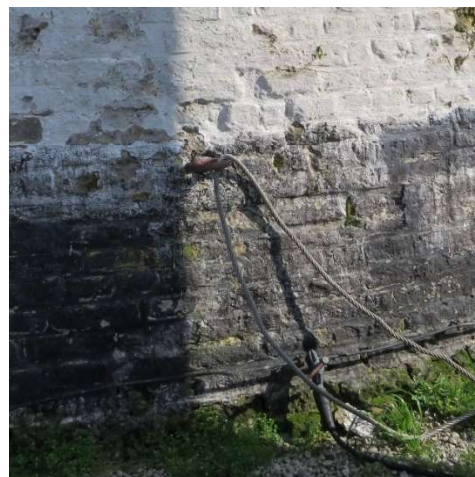
Foto 36 - Brouckmolen. Muurring © 2024 Onroerend Erfgoed.
