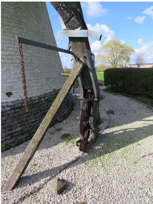
Foto 33 - Brouckmolen. Staart met uitwendig kruierwerk © 2024 Onroerend Erfgoed.
