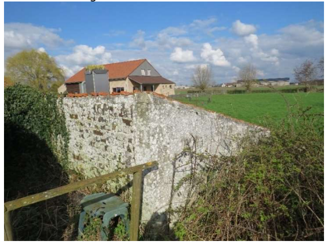
Foto 40 - Brouckmolen. Toegang tot oliekelder © 2024 Onroerend Erfgoed.
