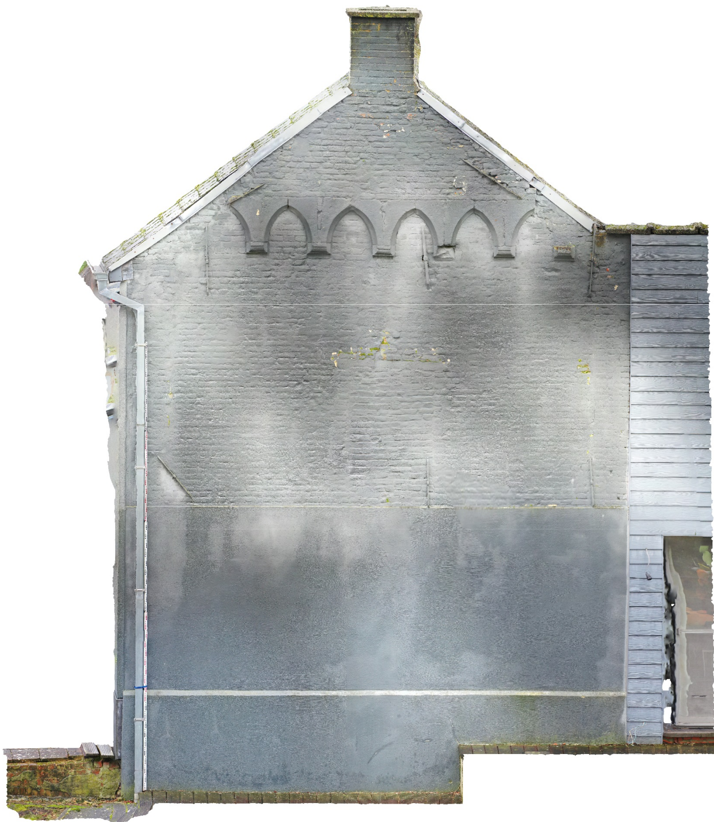
Foto 4: orthofoto van het overblijfsel van de zuidgevel van de vroegere toren (Johan Van Laecke, Onroerend Erfgoed). Opname 22 januari 2024.
