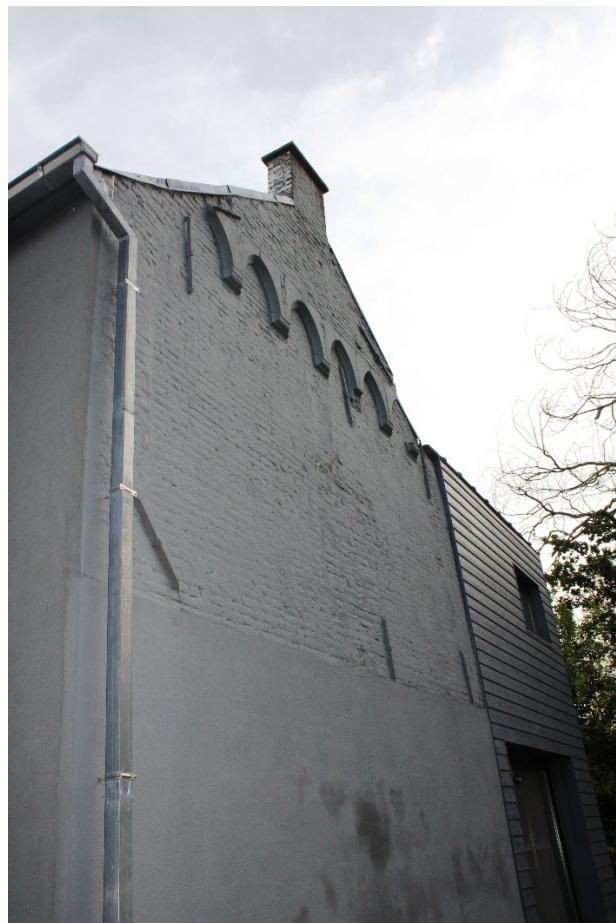
Foto 2: zicht op het overblijfsel van de zuidgevel van de vroegere toren (6 oktober 2023).
